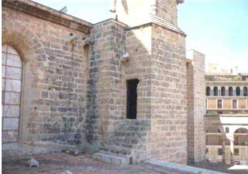
**Fig. 3. 15.4** Remate de la escalera, con la puerta de salida a la cubierta sobre la girola y los escalones descendentes para salvar el desnivel. Obsérvese el cambio de sección de los muros.
