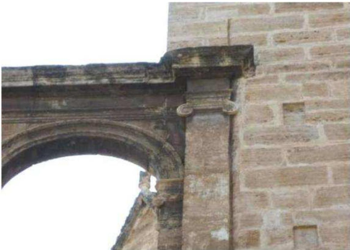
**Fig. 14. 19.1** Vista en detalle del encuentro de la pilastra superior con el muro del transepto, donde se puede apreciar el modo de indicar la pilastra mediante una incisión en los sillares del muro. Rematando la parte superior aparece una incisión que marca la altura que tenía el friso de coronación de las galerías, desmontado por Ramiro Moya en 1974. Puede apreciarse igualmente el estado de suciedad existente.
