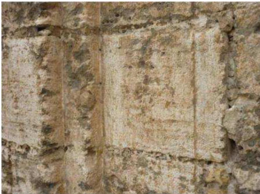
**Fig. 14. 18.1 Detalle de encuentro entre pilastra (izquierda) y sillares originales del muro de la Sacristía (derecha). Pueden verse las discontinuidades existentes y restos de pátinas.**
