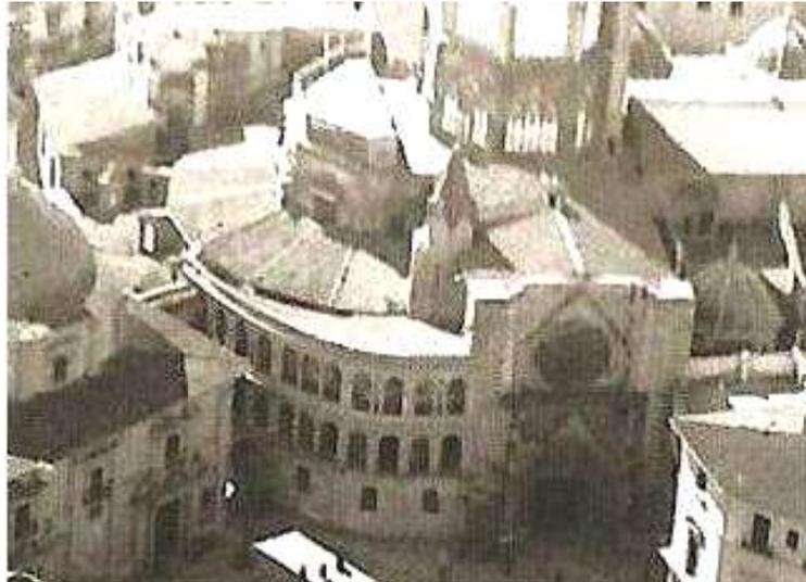
Fig. 10. 18.4 Vista aérea de la cabecera de la Catedral, hacia 1930 <sup>870</sup>. Se pueden apreciar las plantas altas de las galerías compartimentadas, la cubierta de teja y el estado general de cubiertas de la girola. Todos estos elementos serían los que desmontaría y sustituiría Ramiro Moya en la reforma de 1974.
