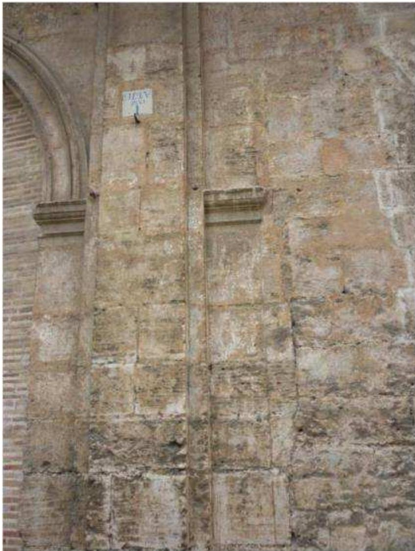
**Fig. 5. 18.1** Pilastra izquierda en planta baja del primer tramo recto. Se aprecian cortes y modificaciones sin correspondencia de hiladas. La pilastrilla de la parte derecha queda marcada por una simple incisión en la piedra y por el pequeño capitel, en correspondencia con el simétrico, que simularía el jarjamento del posible arco simétrico al de la izquierda.
