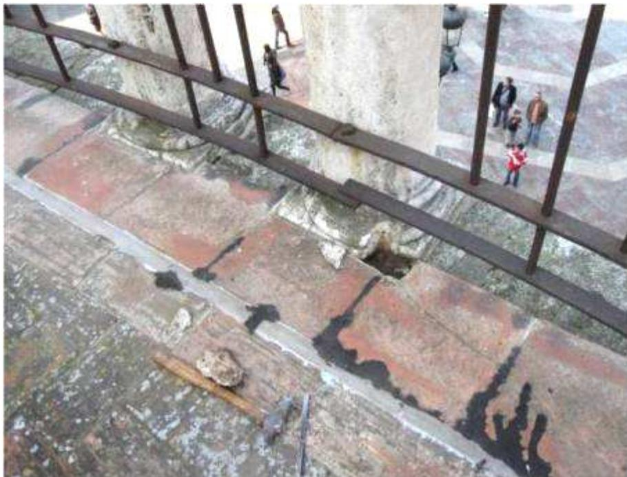
**Fig. 1. 19.3** Estado actual del encuentro del pavimento de cubierta con el antiguo antepecho y basa de las columnas cilíndricas.
