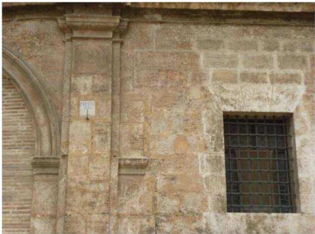
**Fig. 19. 18.1** Detalle de muro con ventana, pilastra, primer arco y enjuta. Se pueden apreciar las alteraciones, discontinuidades, irregularidades en los encuentros y restos de pátinas.
