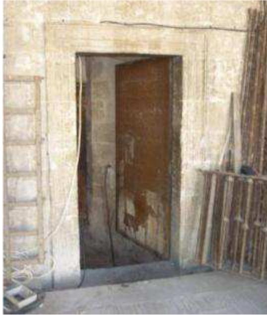
Fig. 10. 15.4 Terraza sobre la Sacristía Nueva (1ª planta actual de las galerías de la Obra Nova). La puerta de salida a la misma, ya de factura renacentista, está elevada respecto al nivel de la primitiva cubierta aproximadamente un metro.
