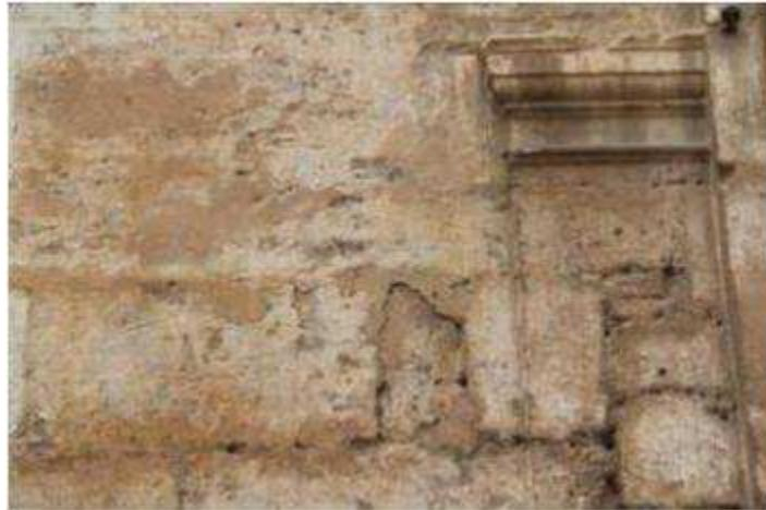
**Fig. 6. 18.1** Configuración de las pilastrillas del primer tramo en planta baja mediante incisión en los sillares originales y labrado de capitel en correspondencia con los enjarjes de la serie de arcos de esta planta. Se pueden apreciar los retacados existentes.
