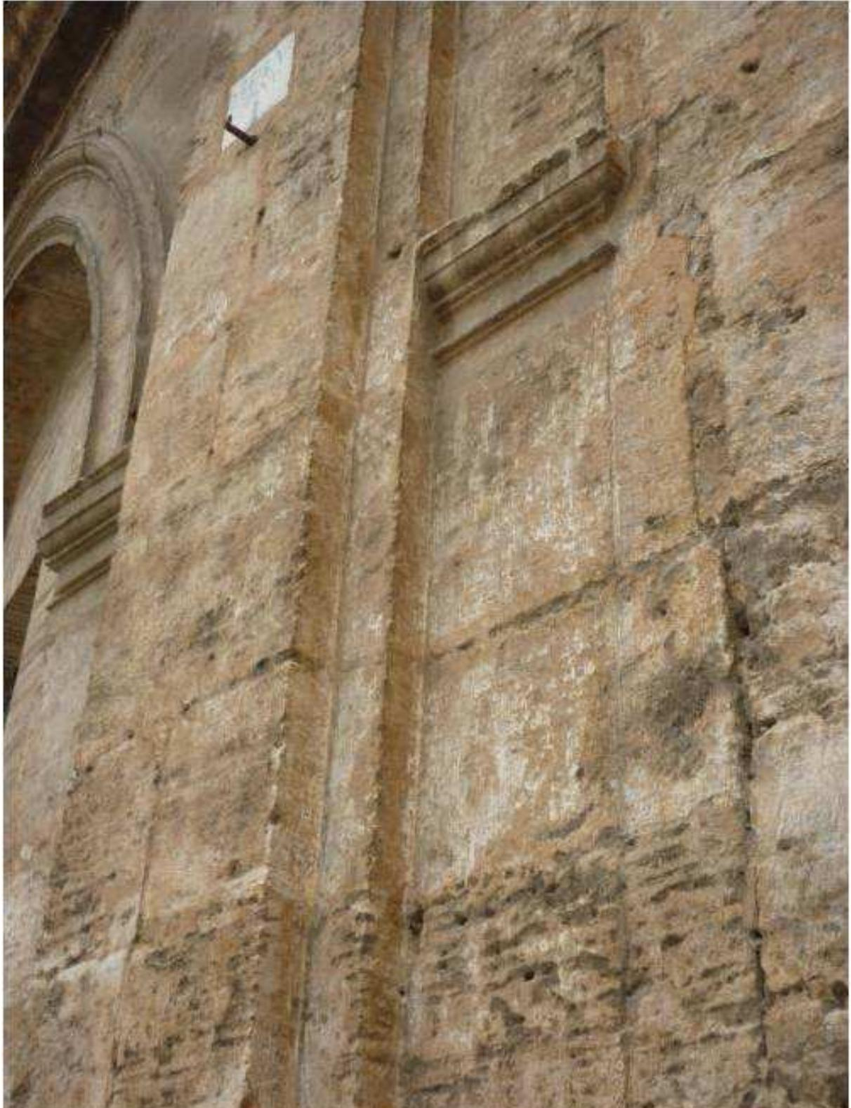
**Fig. 16. 18.1** Detalle de encuentro entre pilastra (izquierda) y sillares originales del muro de la Sacristía (derecha). Se pueden observar discontinuidades, cortes irregulares, retacados y restos de pátinas. También puede verse la ligera incisión vertical para significar la pilastrilla.
