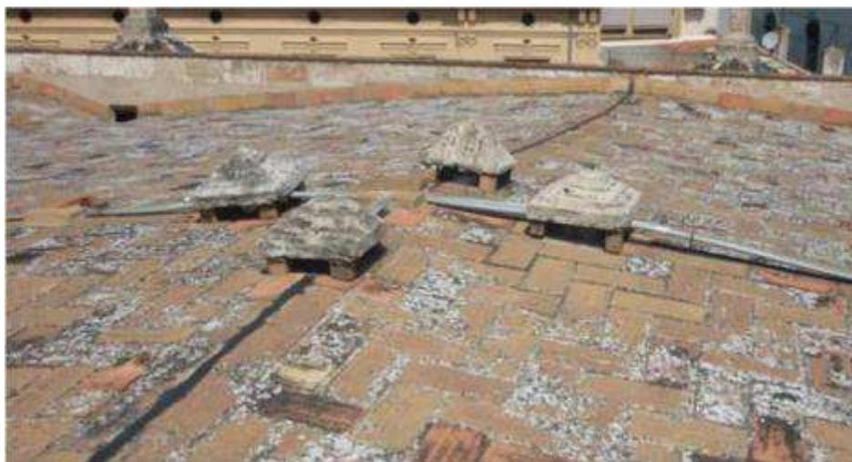
**Fig. 32. 13.3** Formación de cubiertas en la catedral, con las caperuzas cerámicas que cubren los orificios de salida de aire en lo alto de las bóvedas.
