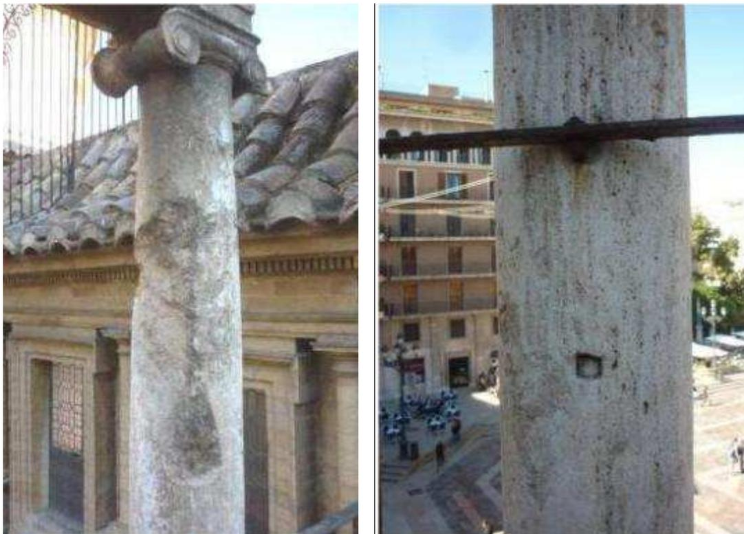
**Fig. 11. 19.1** Bombeos de origen químico, retacados y barandillas oxidadas en las columnas cilíndricas de la última planta.
