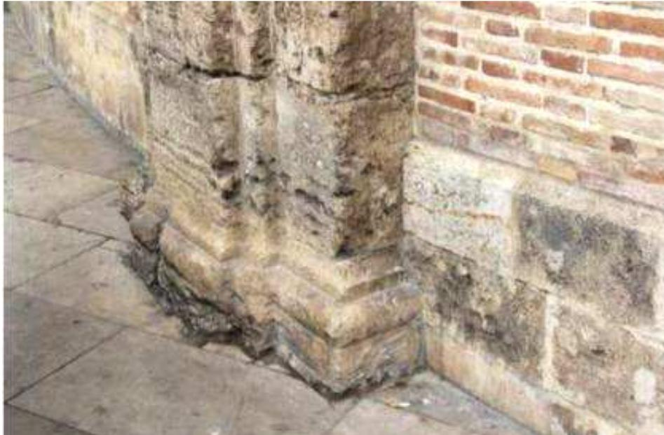
**Fig. 5. 19.1** Base de pilastra. Erosiones y moho por humedades.
