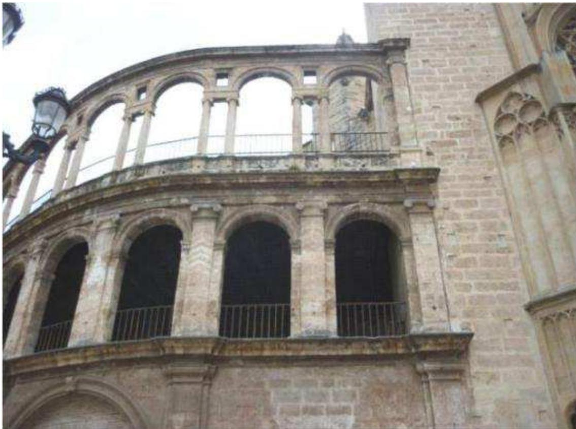
**Fig. 7. 18.1** Primera pilastra en plantas altas, marcadas por simple incisión en los sillares originales del lienzo de la Puerta de los Apóstoles.
