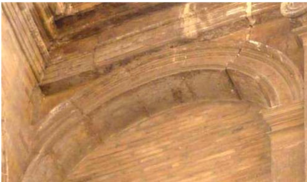
**Fig. 6. 18.3** Vista en detalle del arco cegado junto al pasadizo. Se aprecia el descenso de dovelas.
