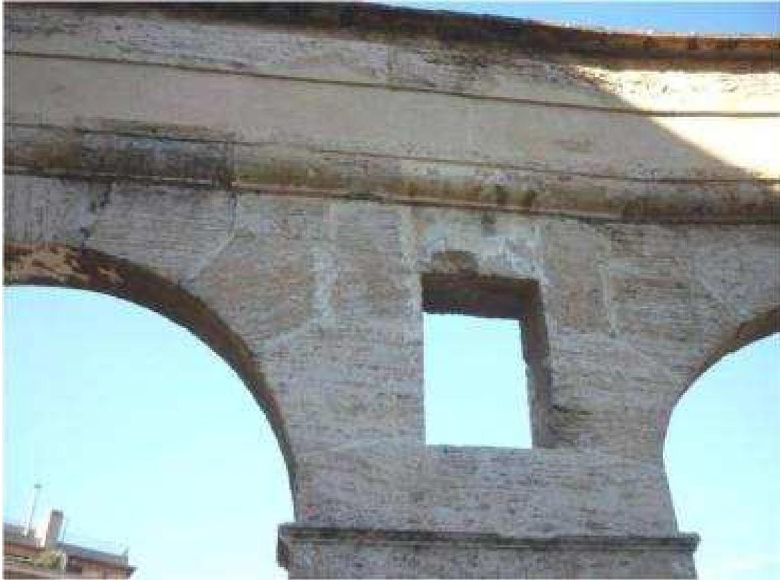
Fig. 29. 18.5 Estado actual del friso de remate por la parte interior de la cubierta. Se aprecia el enfoscado que recubre un zuncho de hormigón que se realizó en el año 1974 como refuerzo.
