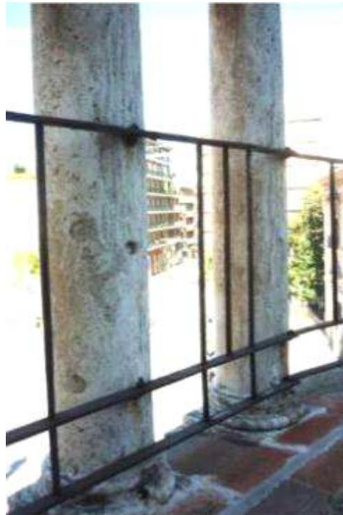
**Fig. 24. 18.5** Con la elevación del nivel de la terraza se eliminó la barandilla original y se colocó una nueva de mayor altura. Se aprecian los huecos en los pilares donde aquella se anclaba y los retacados con mortero de cemento.
