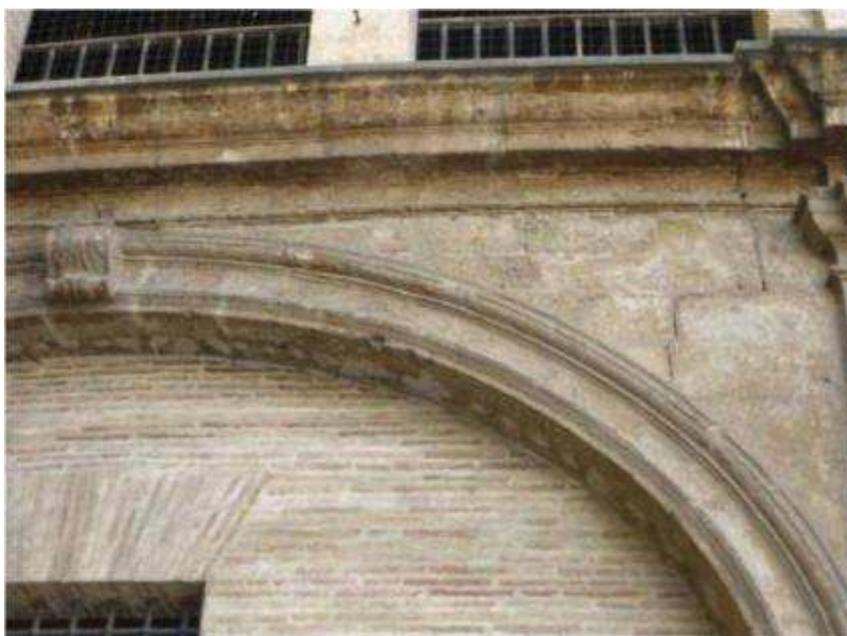
**Fig. 8. 19.1** Fisura escalonada en la enjuta del arco central.
