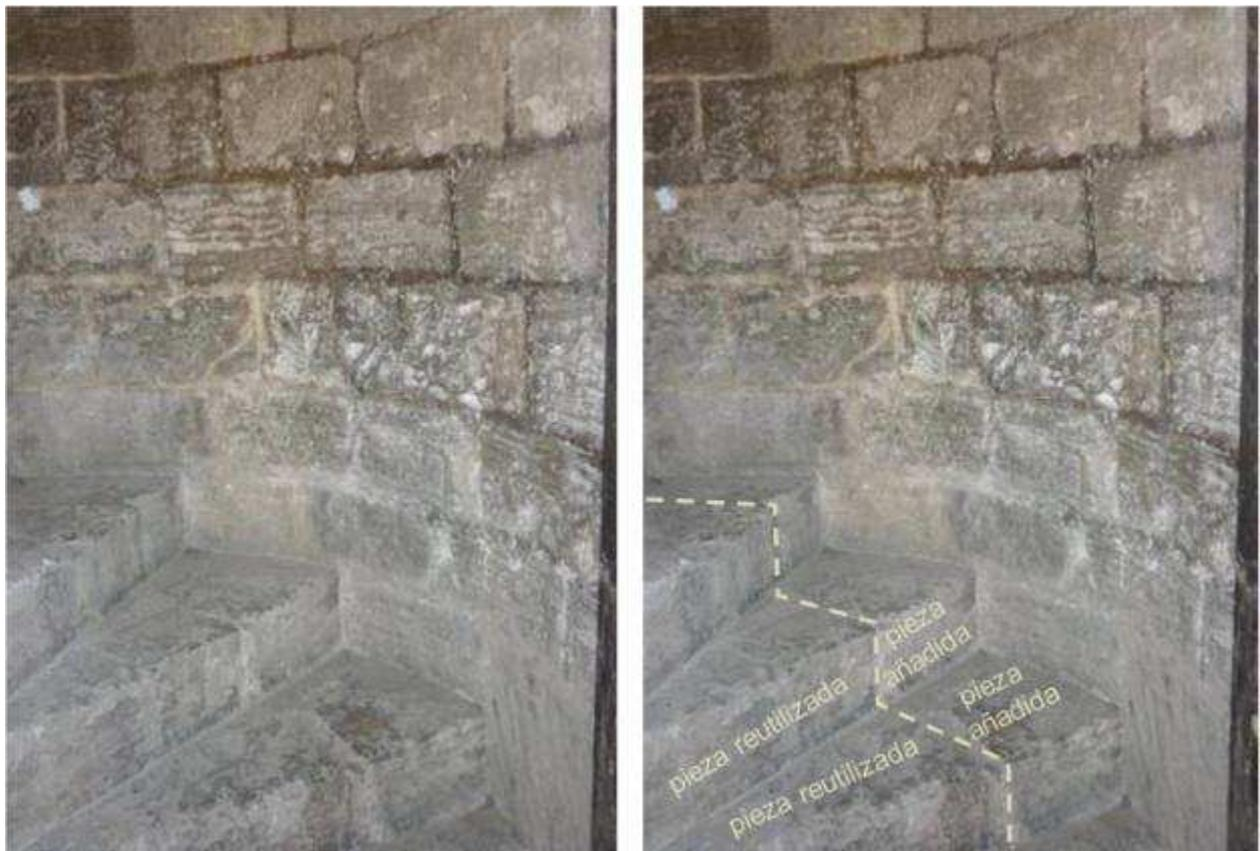
**Fig. 6. 15.2 Escalera, estado actual. Tramo inicial del caracol donde puede apreciarse la composición del peldaño con dos piezas.**
