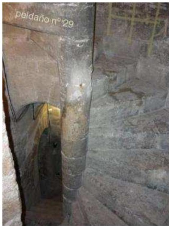
Fig. 4. 15.2 Escalera, estado actual. A partir del peldaño 28 ya apoyan en la bóveda de descarga.
