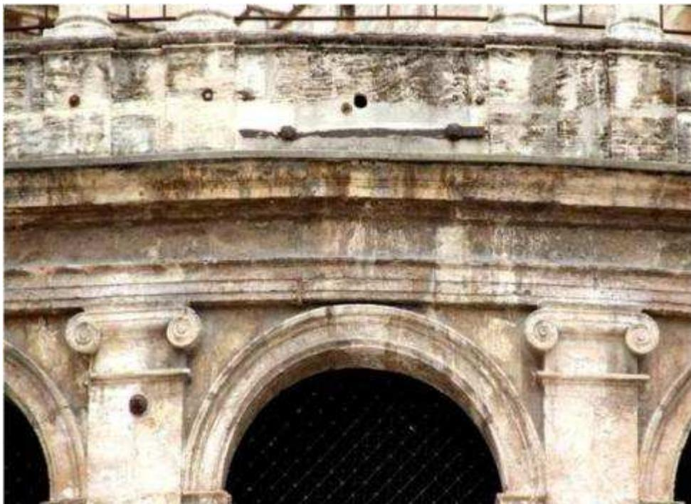
**Fig. 13. 19.1** Vista en detalle del antepecho de segunda planta. Además de mucha suciedad puede apreciarse el refuerzo metálico existente en el centro bajo el cuarto arco empezando desde la Puerta de los Apóstoles. También se ven, a media altura, los canalillos cegados y cabezas de tornillos metálicos del refuerzo efectuado en la reforma de 1974.
