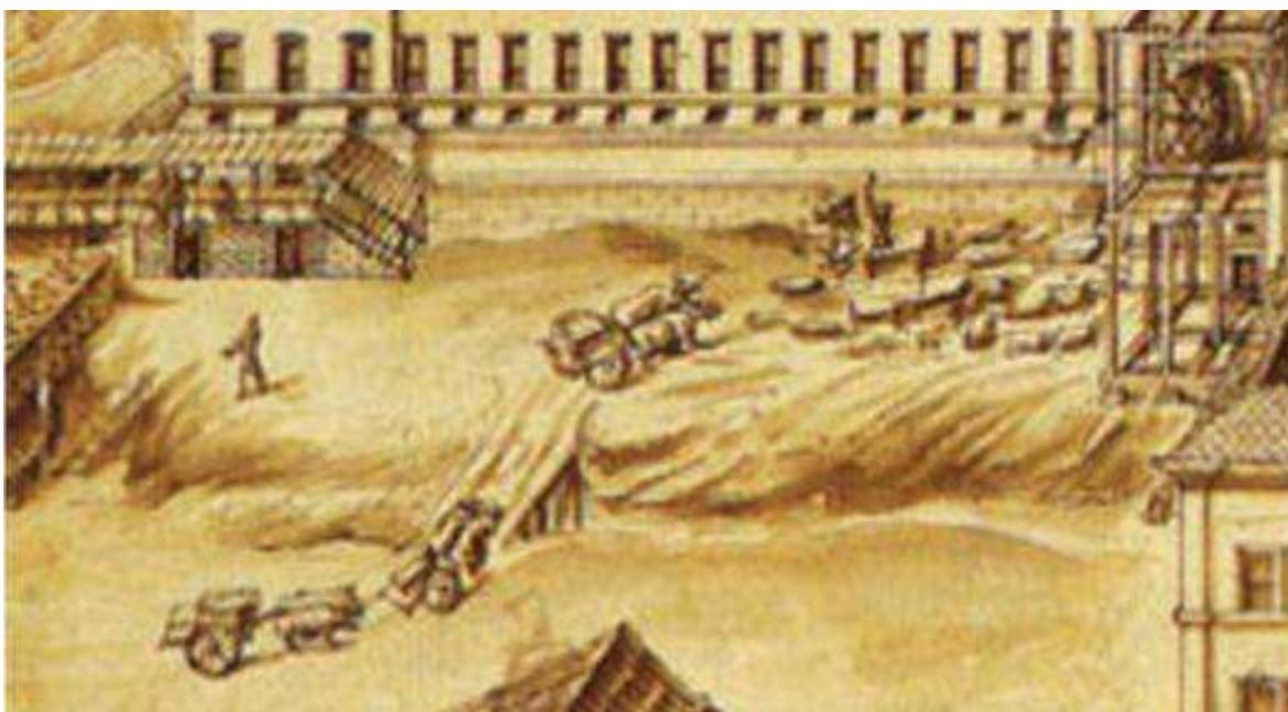
Fig. 3. 14.4 Dibujo Hatfield. Detalle mostrando el transporte de piedras en carros desde la cantera a la obra.
