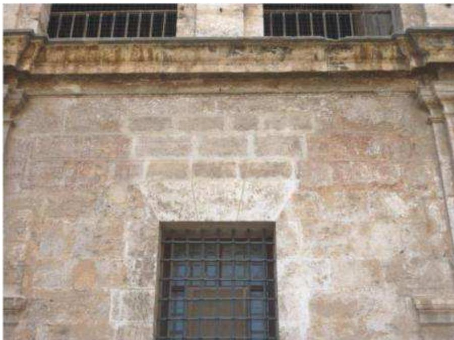
Fig. 13. 16.14 Estado actual del primer tramo recto. Alteraciones en sillares y restos de pátinas.
