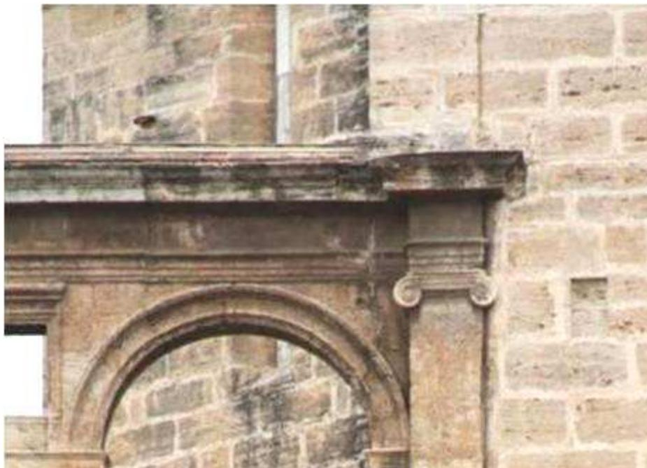
Fig. 22. 18.5 Encuentro de la parte superior con el muro de la puerta de los Apóstoles. Se aprecia la incisión que marca la altura del antepecho que existía.
