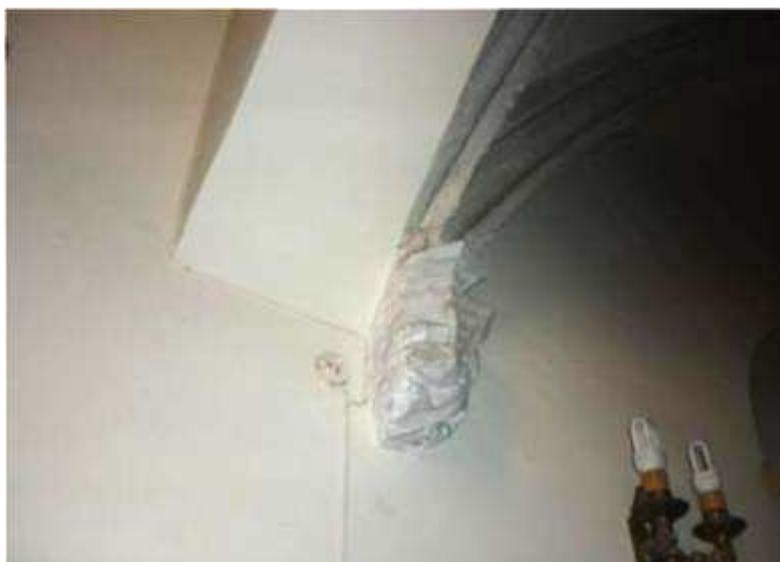
Fig. 7. 17.7 Detalle en el que se muestra cómo el enjarjamento de arranque de la bóveda de la sacristía ha sido separado del muro al desplazar éste..
