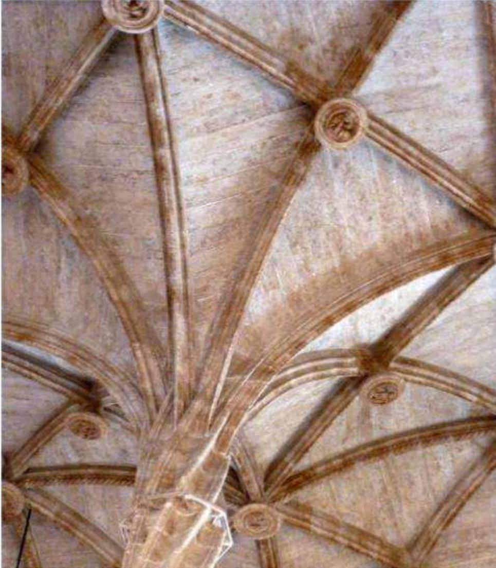
**Fig. 16. 13.3 Lonja de Valencia. Plementería a base de tiras paralelas de lajas enteras de piedra adoveladas.**
