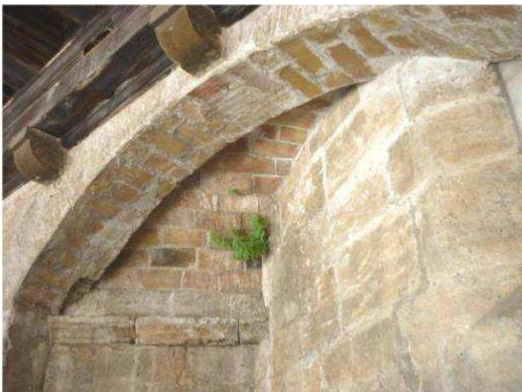
**Fig. 4. 19.2** Presencia de vegetación en los muros interiores correspondientes a la girola gótica.
