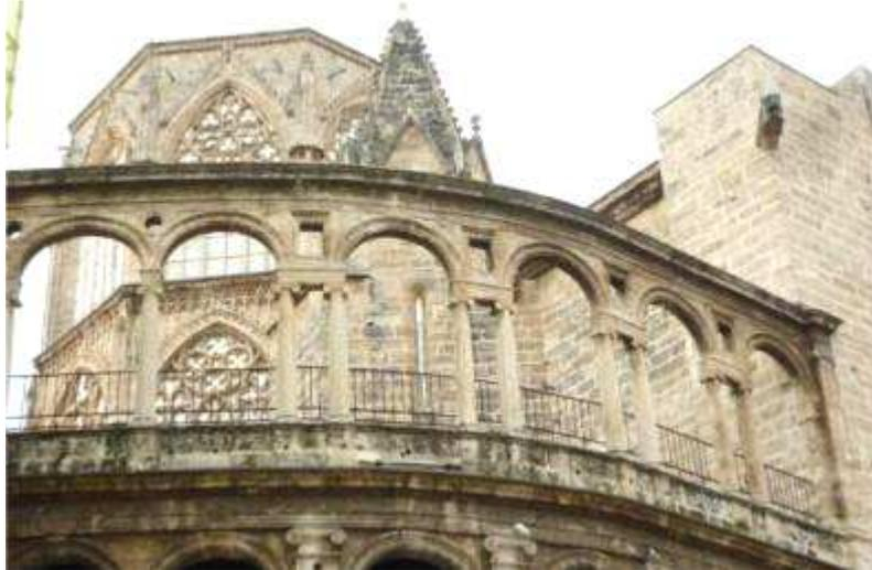
Fig. 7. 16.8 Arco entre dinteles con vacíos cuadrangulares y vacíos circulares sobre los salmeres.
