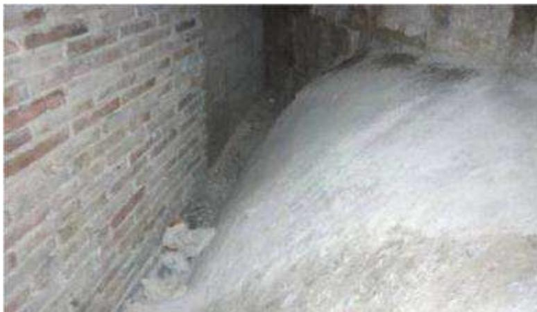
**Fig. 15. 18.5** Trasdós de la bóveda tabicada sobre la antigua capilla dels Tapiners. <sup>888</sup>
