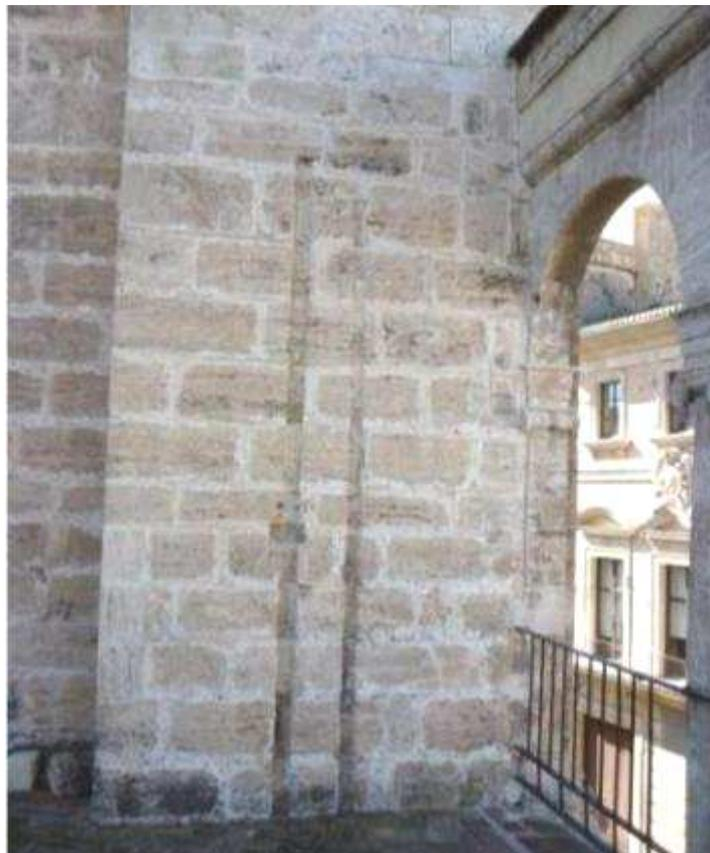
**Fig. 26. 18.5** Marcas en el muro del transepto de la inserción de tabiques existentes en segunda planta.
