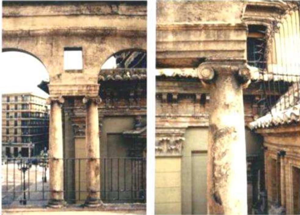
**Fig. 12. 19.1** Vista interior del estado de deterioro de las columnas de última planta, así como del friso de remate de las galerías.
