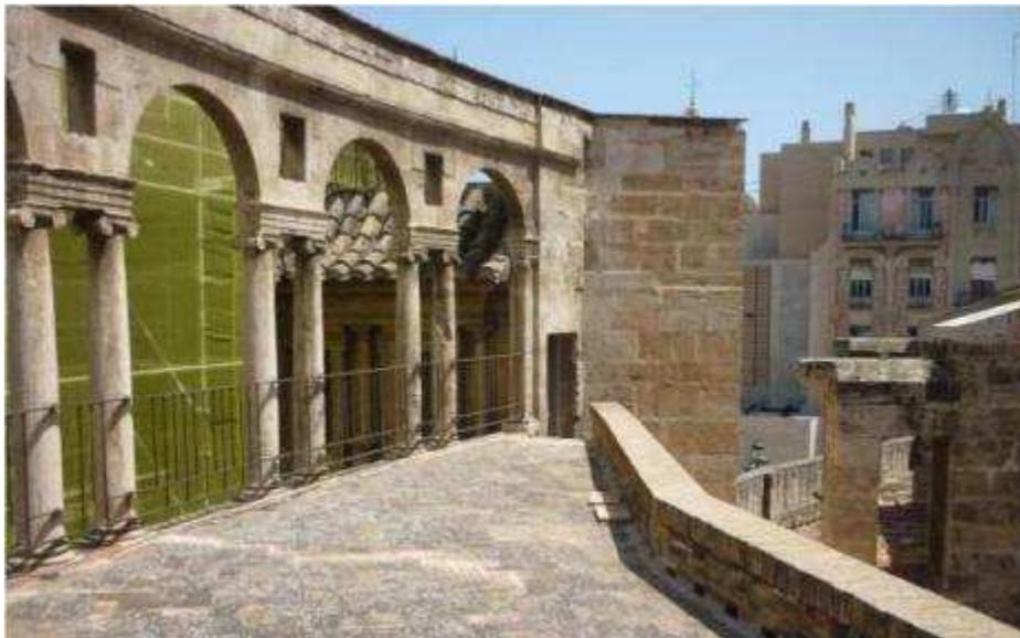
**Fig. 2. 19.3** Estado actual de la terraza con el pavimento elevado sobre el original.
