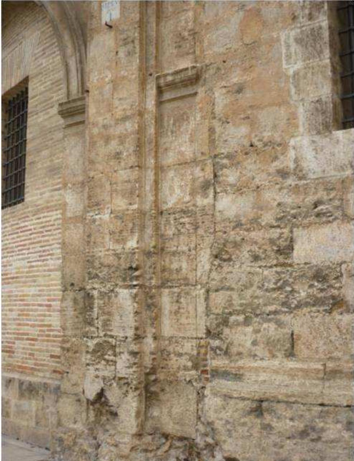
**Fig. 17. 18.1** Detalle en el que puede apreciarse a la derecha el muro original correspondiente a la ampliación de la Sacristía Nueva (anterior a 1563), la primera pilastra de las arcadas y el primer arco. También a la derecha, zócalo gótico, diferente al de la izquierda. Se aprecian las discontinuidades, los retacados y los restos de pátinas.
