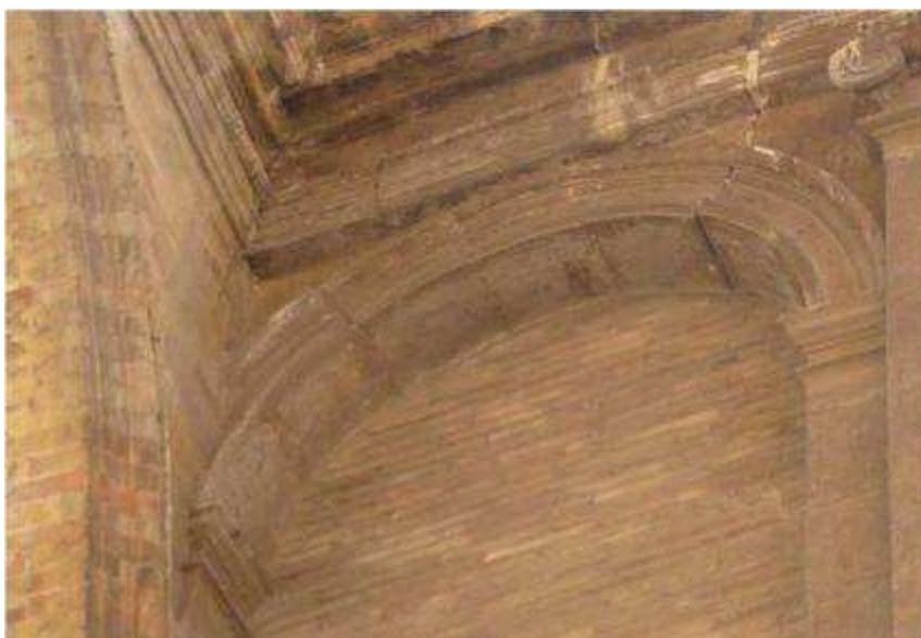
**Fig. 9. 19.1** Arco cegado junto al puente de conexión con la Basílica de la Virgen. Se aprecian fisuras en el arco, con descenso de dovelas, y en la imposta superior.
