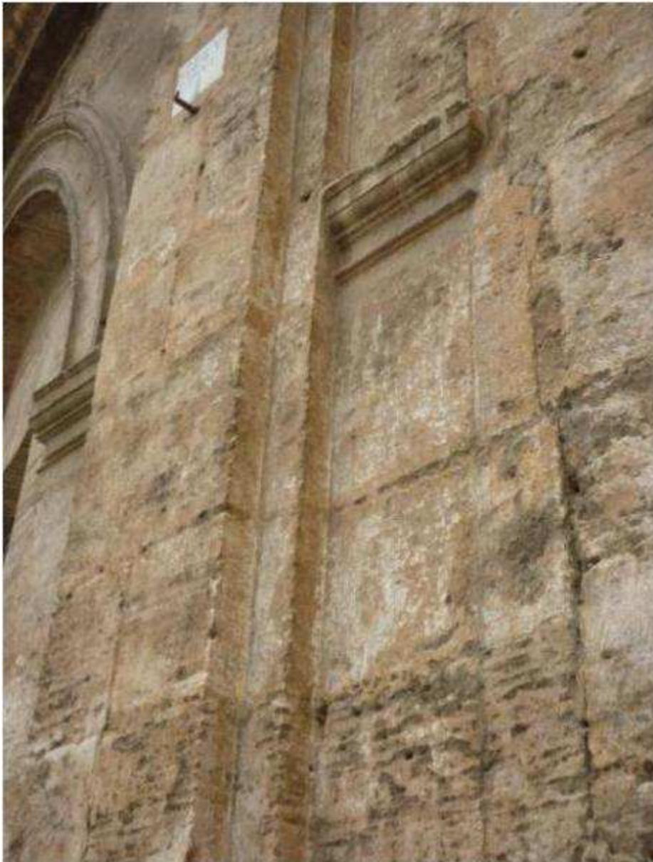
**Fig. 9. 18.1** Detalle de encuentro entre las pilastras que se añaden a la obra con los sillares originales del lienzo de la Sacristía Nueva. Existen, además, restos de pátinas que podrían indicar que la obra estaría recubierta con un revestimiento.
