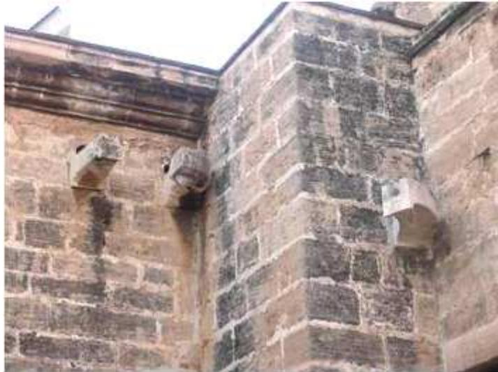
Fig. 5. 15.4 Detalle de la gárgola de evacuación de las aguas de las cubiertas del transepto en el encuentro con el muro de la escalera de caracol.
