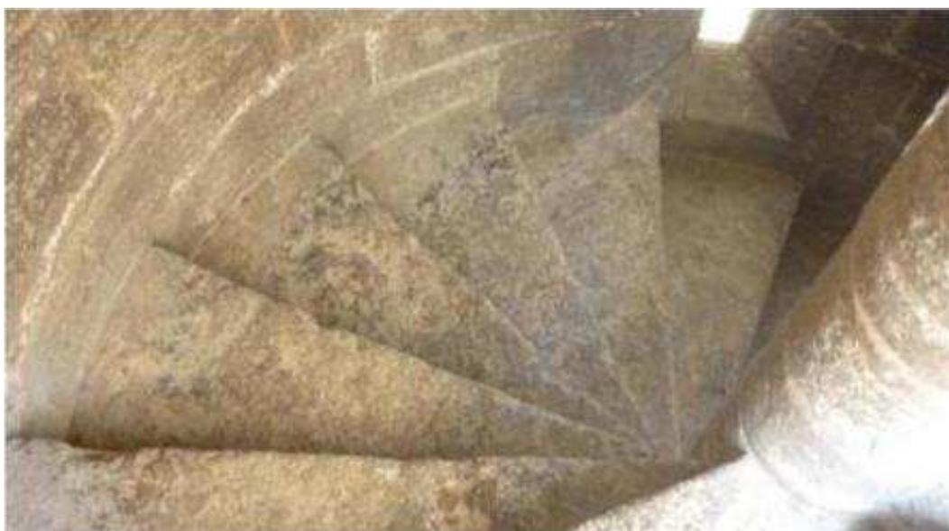
**Fig. 11. 15.3** Una vez que los peldaños ya son piezas enterizas, las dimensiones de los sillares del muro perimetral redondo comienzan a ser más regulares..
