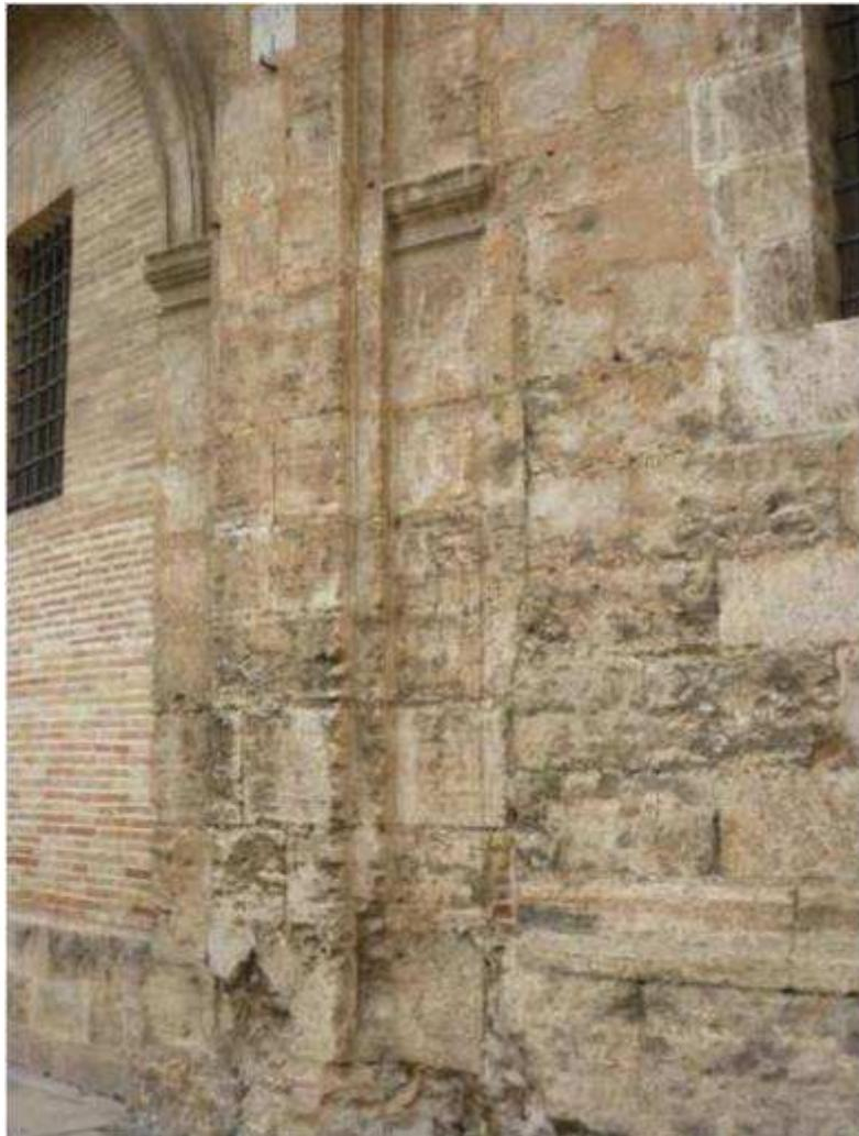
**Fig. 8. 18.1** Es significativa la descuidada ejecución a la hora de realizar las entregas de las pilastras que se añaden a la obra con los sillares originales del lienzo de la Sacristía Nueva. Pueden incluso observarse retacados de ladrillo entre los sillares de la pilastra y el zócalo.
