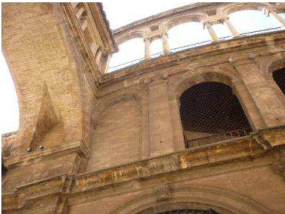
**Fig. 5. 18.3** Vista inferior del paso elevado entre la Basílica de la Virgen y la Catedral. Se puede ver cómo el primer arco de la planta primera, contiguo al pasadizo, está cegado
