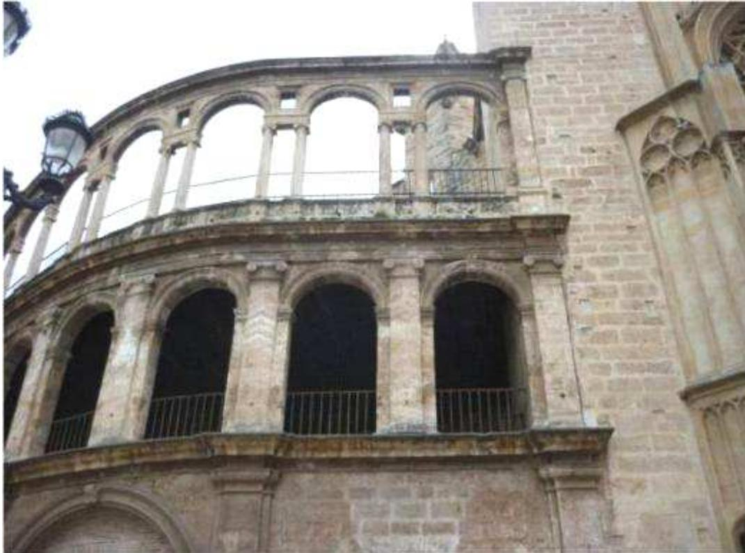
**Fig. 10. 19.1** Suciedad generalizada en toda la fachada.
