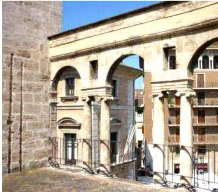
Fig. 9. 18.4 Hipótesis del autor. A la izquierda pueden verse unas incisiones en el muro del transepto, correspondientes con toda probabilidad a la traba de las antiguas tabiquerías que estuvieron hechas en esta planta hasta la reforma de Ramiro Moya del año 74.
