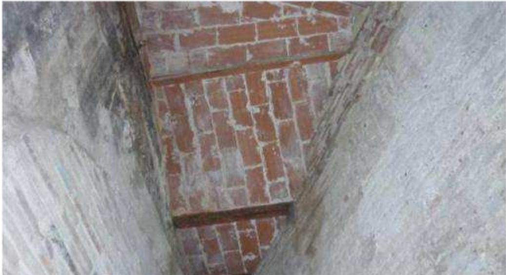
**Fig. 3. 19.3** Estado actual de las viguetas metálicas del forjado sobre el original. Se puede apreciar el estado de oxidación.
