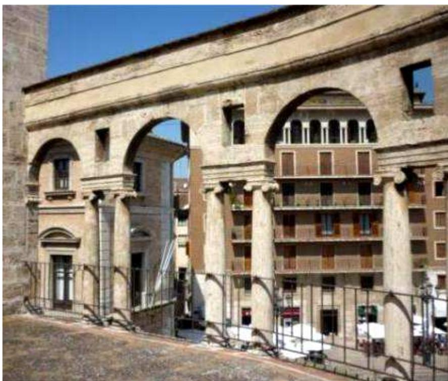
Fig. 5. 16.8 Arco entre dinteles con vacíos cuadrangulares en la terraza superior de la Obra Nova. Columnas con éntasis y orden jónico.
