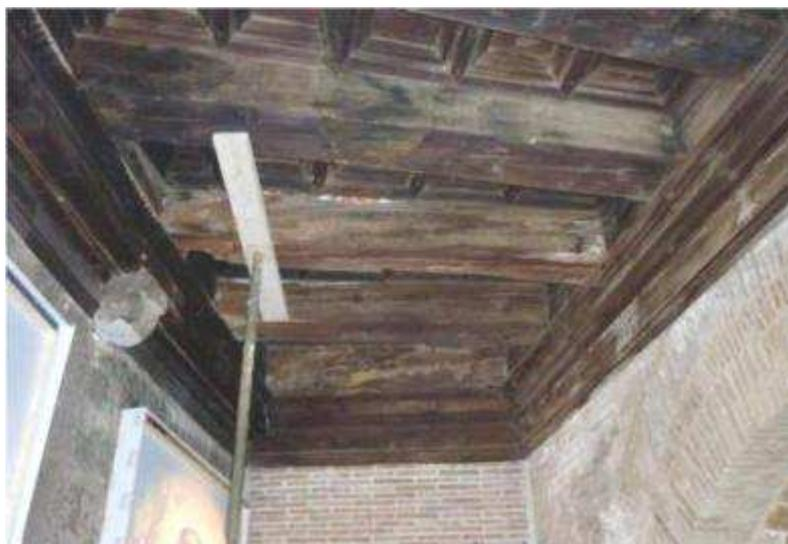
**Fig. 12. 18.5** Forjado original de vigas y casetones de madera.
