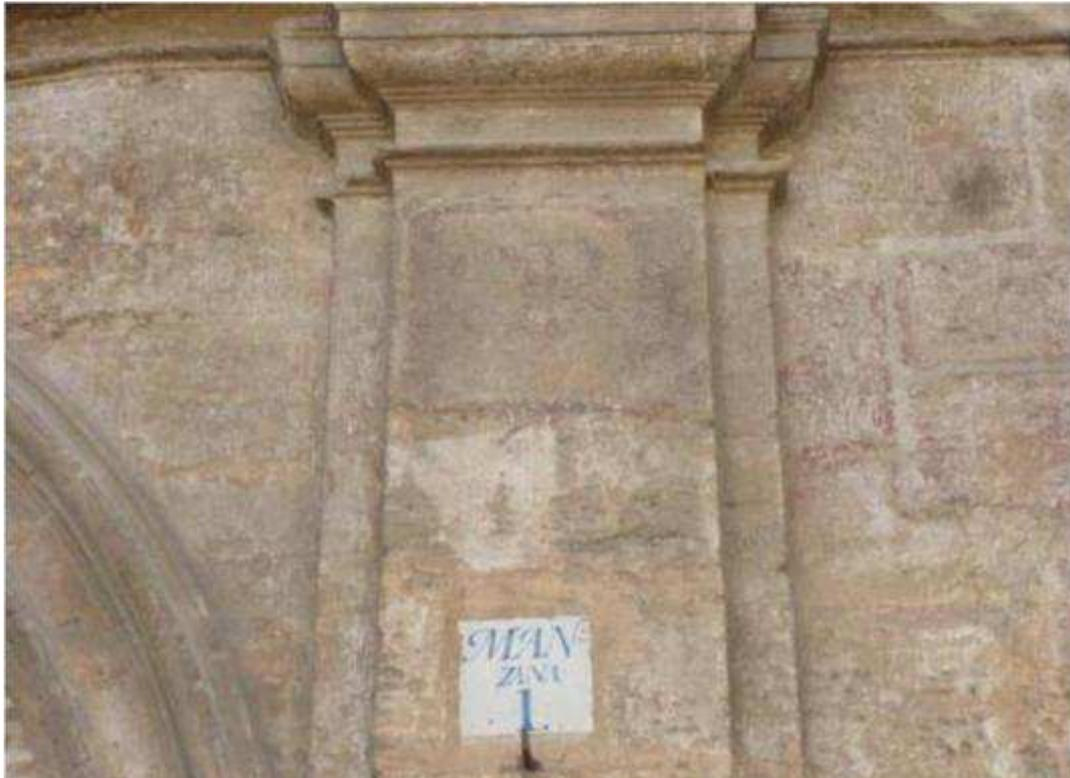
**Fig. 18. 18.1** Restos de pátinas en pilastra, muro, arco y enjuta.
