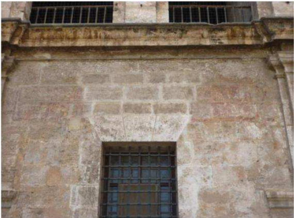
**Fig. 10. 18.1** Restos de pátinas en muro y pilastras.
