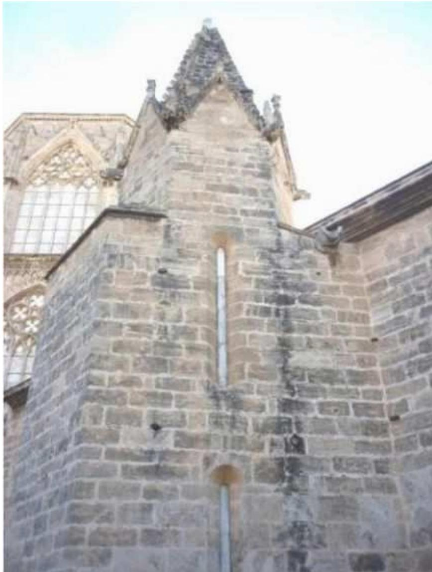
Fig. 1. 15.4 Remate de la escalera, con la visión frontal del muro y las ventanas que la iluminan. Pueden apreciarse también en esta imagen unas argollas ancladas en el muro que, supuestamente, se utilizaron para sujetar los toldos levantinos que se supone que cubrían en origen la azotea de la Obra Nova.
