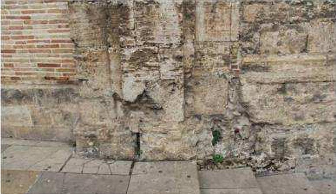
**Fig. 2. 19.1** Degradación de zócalo y base de pilastra izquierda.
