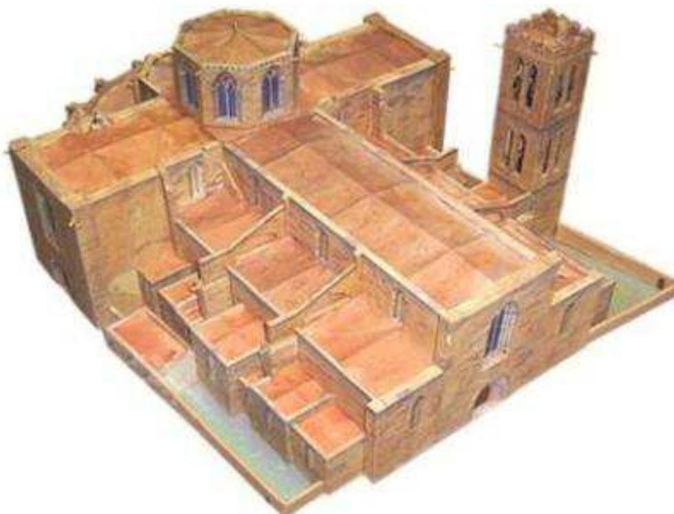
**Fig. 4. 12.2** Maqueta hacia principios del XIV, con el primitivo campanario, los tres primeros cuerpos de las naves longitudinales y el primer cuerpo del cimborrio.
