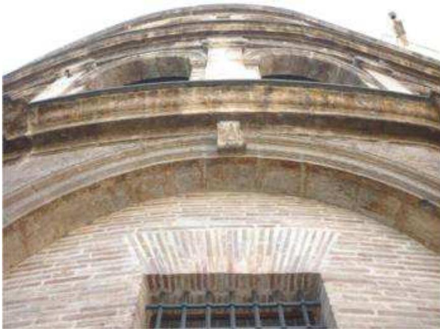
**Fig. 6. 17.5** Estado actual. Arquerías centrales. Arco en torre cavada y redonda.
