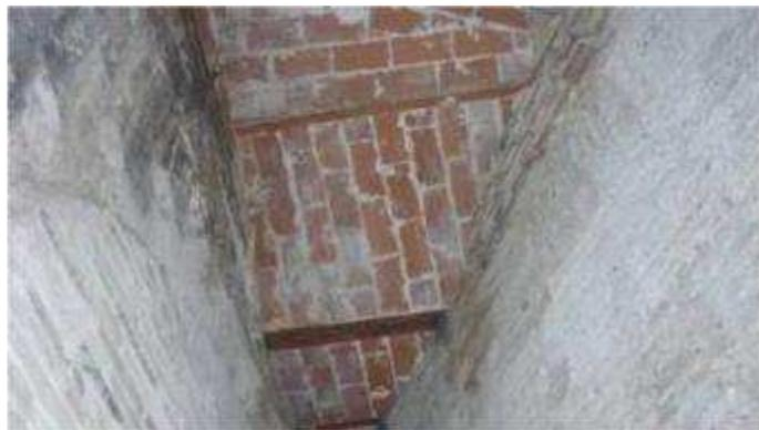
Fig. 17. 18.5 Forjado metálico que realiza Moya sobre el original, elevando el nivel de la terraza. <sup>889</sup>
