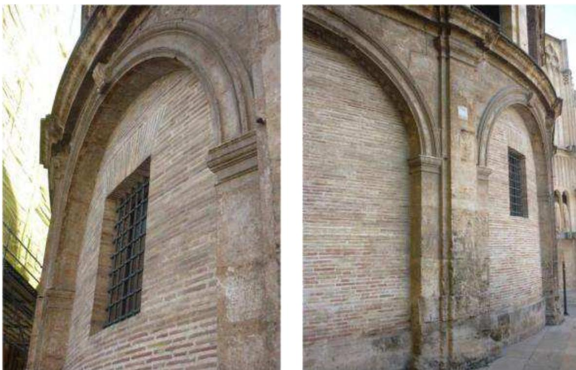
Fig. 18. 17.10 Arcos en torre cavada y redonda en la planta baja de la Obra Nova.
