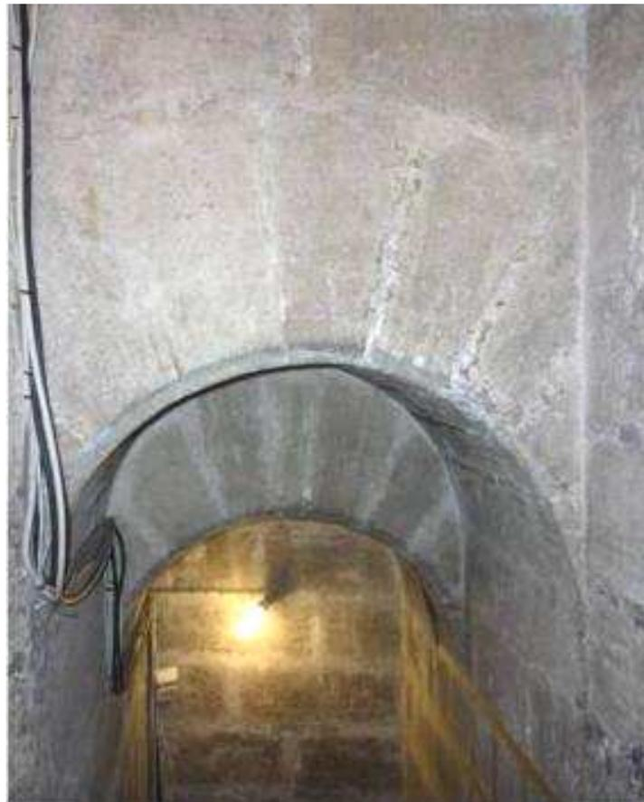
**Fig. 21. 15.3** Cambio de altura de la bóveda inicial y el arco de descarga de la escalera.
