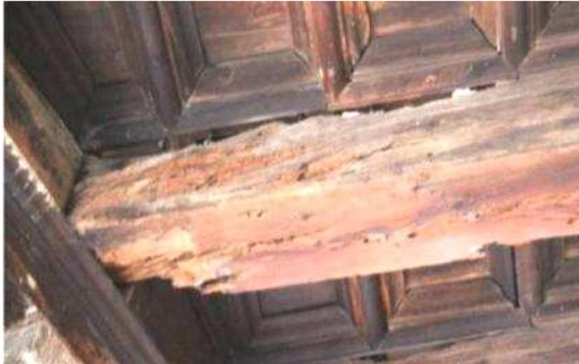
**Fig. 6. 19.2** Estado actual de algunas cabezas de vigas del techo de primera planta.
