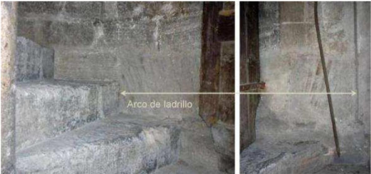
**Fig. 20. 15.3** Arco de descarga de ladrillo que salva la zona de rellenos del muro de fondo de la antigua capilla de San Nicolás.
