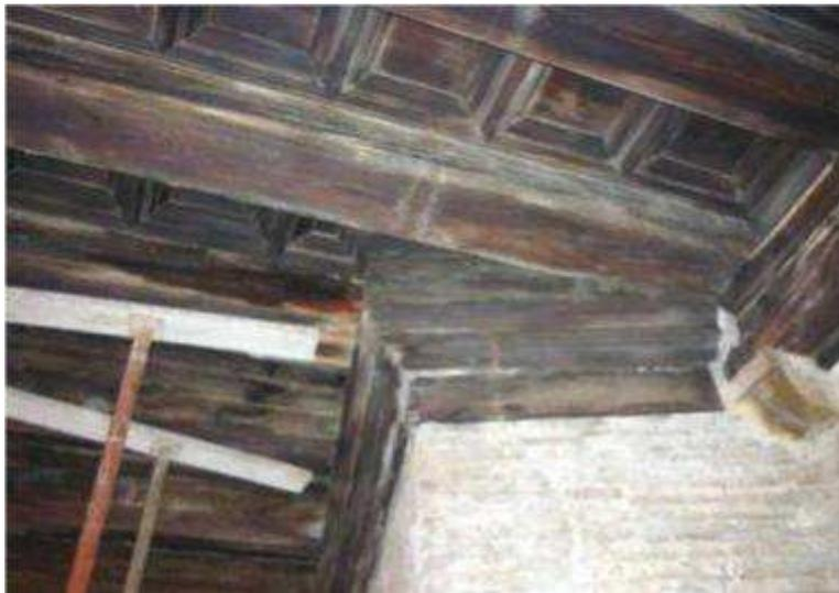
**Fig. 14. 18.5** Forjado original de vigas y casetones de madera en el quiebro del muro.
