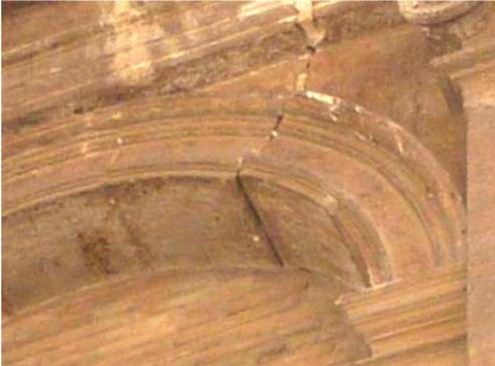
**Fig. 7. 18.3** Vista en detalle del arco cegado junto al pasadizo. Se aprecia el descenso de dovelas.
