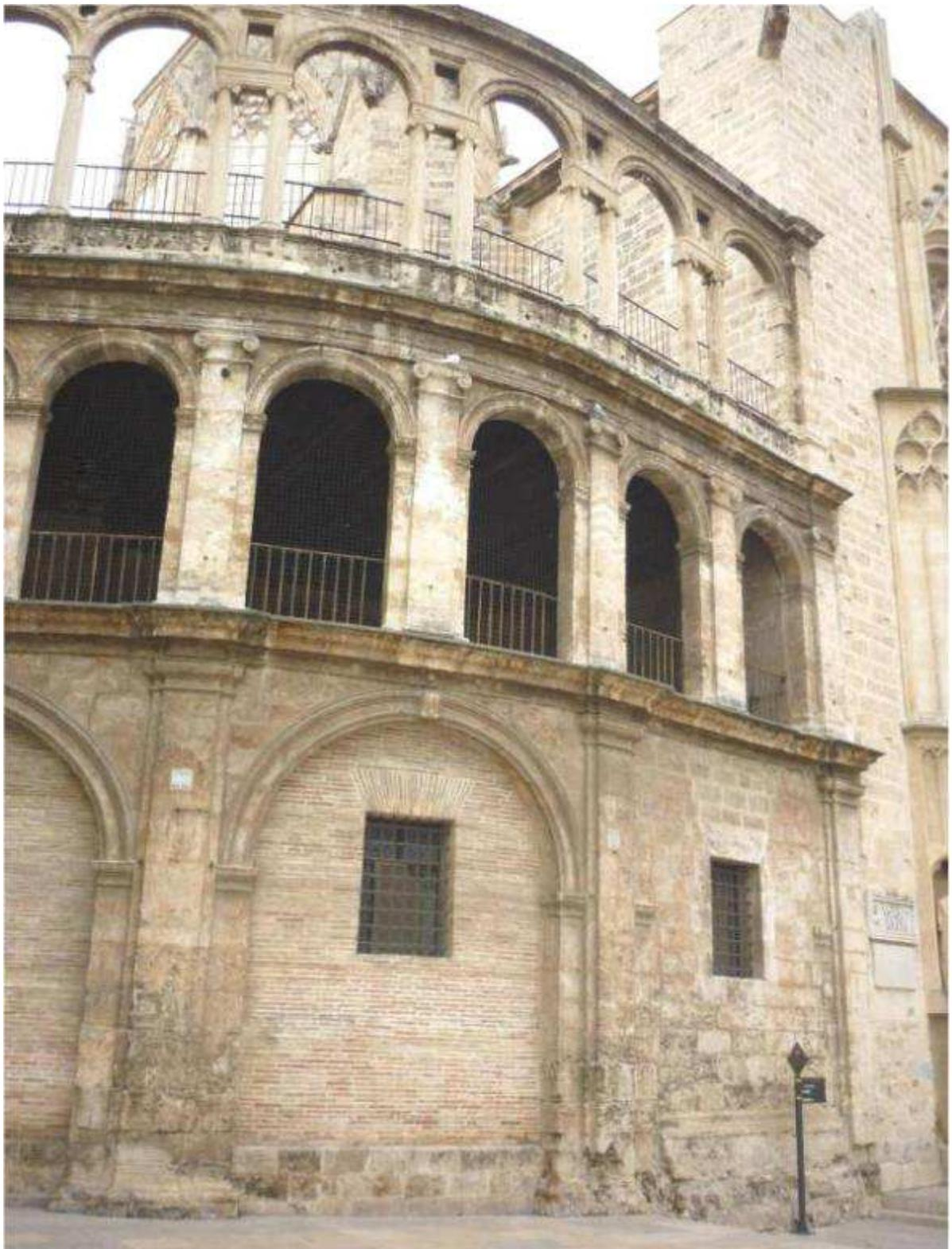
**Fig. 9. 16.8** Estado actual de la Obra Nova. Esquema de dos arcos entre columnas jónicas sobre arco inferior único de gran tamaño, situado entre pilastras dóricas y sin arquitrabe, inspirado en el pórtico de Pompeyo de la Lámina XXXII del Libro Tercero de Serlio
