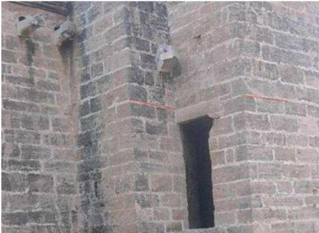
**Fig. 4. 15.4** Detalle de la puerta de salida de la escalera a la cubierta sobre la girola. La no coincidencia de las hiladas de los muros de la escalera con las del contrafuerte de las bóvedas del transepto, junto a la forma de resolver la gárgola de evacuación de las aguas de las cubiertas de éste, indica una diferencia cronológica entre el origen de la catedral y la escalera, siendo ésta posterior.
