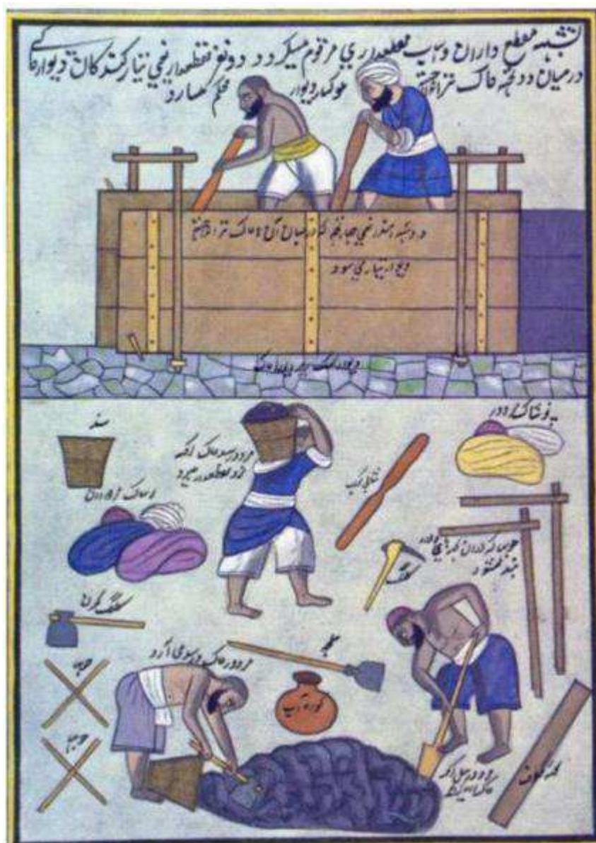
Fig. 1. 7.4 Miniatura con obreros haciendo un muro de tapial. <sup>102</sup>
