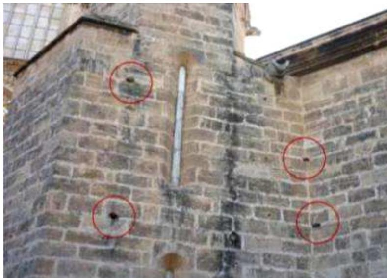
**Fig. 9. 17.5** Argollas actualmente repartidas en el muro de la escalera de caracol, que sugieren la existencia original de una cubierta mediante el sistema de toldos levantinos, atirantados entre estos puntos y una serie de postes repartidos por la cubierta de la girola y el remate de la arcada superior de las galerías, de un modo similar al supuesto de cubrición original del Coliseo de Roma.
