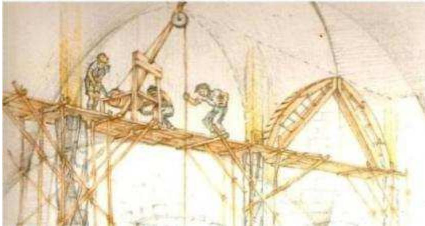
**Fig. 1. 14.5** Grúa de polea con doble manivela horizontal y cimbra para la construcción de las bóvedas de la Lonja
