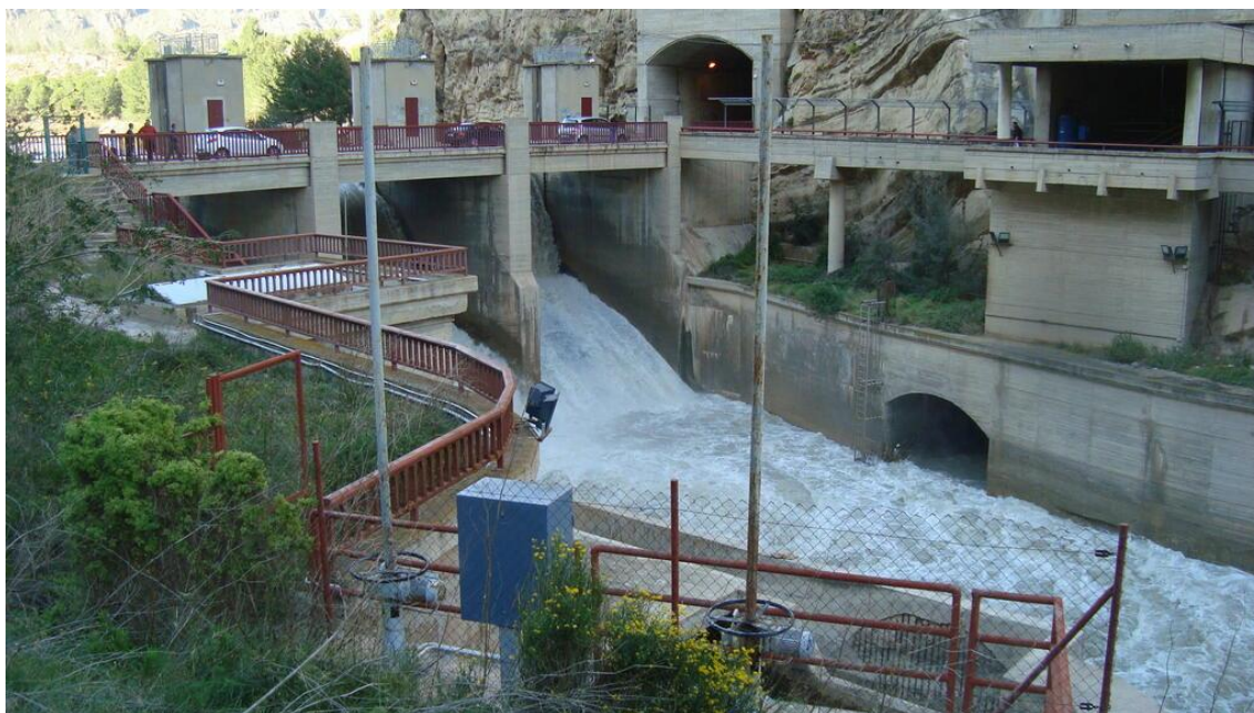
Figura 49. Azud de Ojós para derivación de las aguas.
