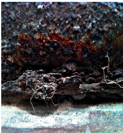
Fig. 14. Suciedad superficial y dep. calcáreos.
