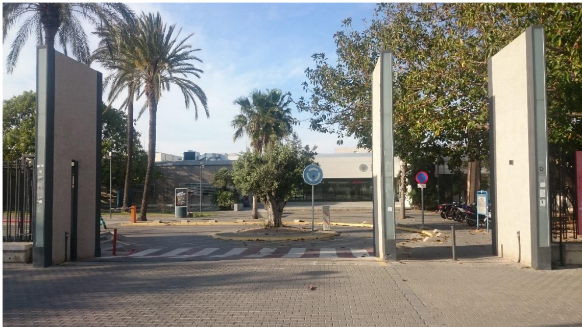
Ilustración 30. Acceso principal edificio 1B (imagen de libre acceso web)
