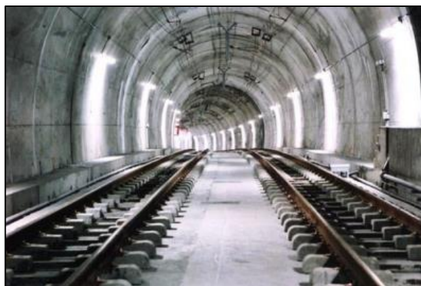
Ilustración 2. Sección Tipo Vía en Placa. Fuente: www.balzola.com
