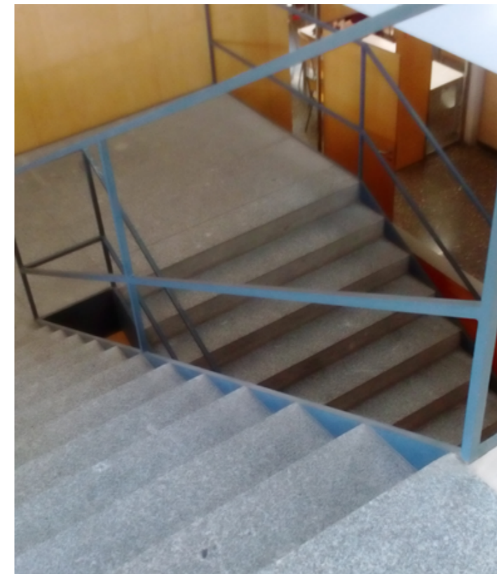
Escalera 3 de acceso a 2ª Planta (aulas de proyectos).
