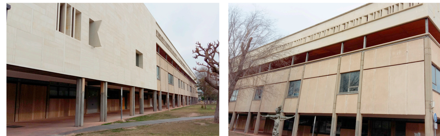
Diferentes ángulos de la Fachada Oeste del Edificio en su Estado actual tras la reforma y ampliación (2016).
