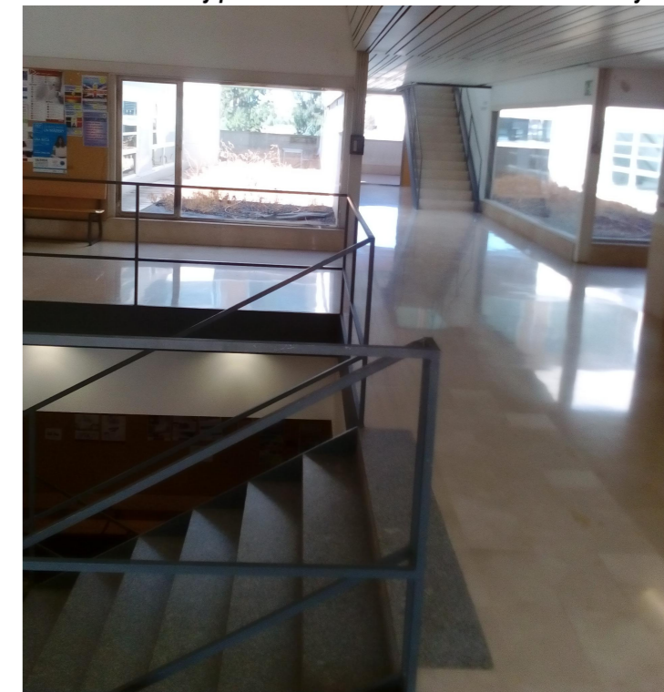
Escalera 4 en planta segunda, patios y terraza Oeste al fondo.
