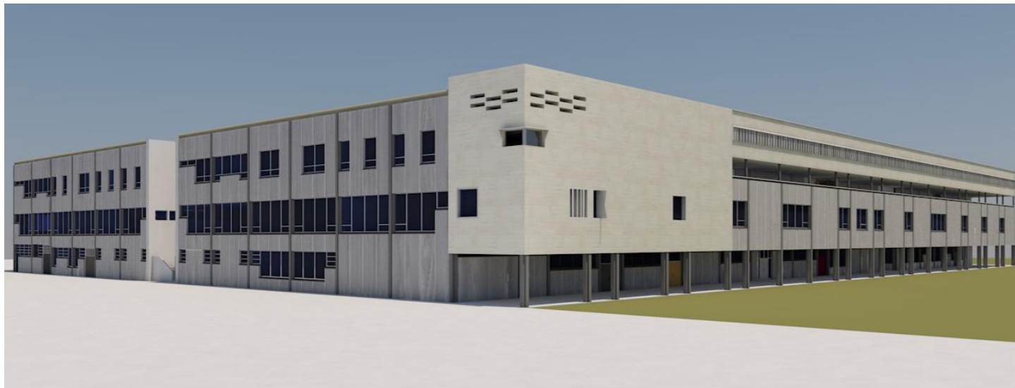
Encuentro entre fachadas Norte y Oeste.
