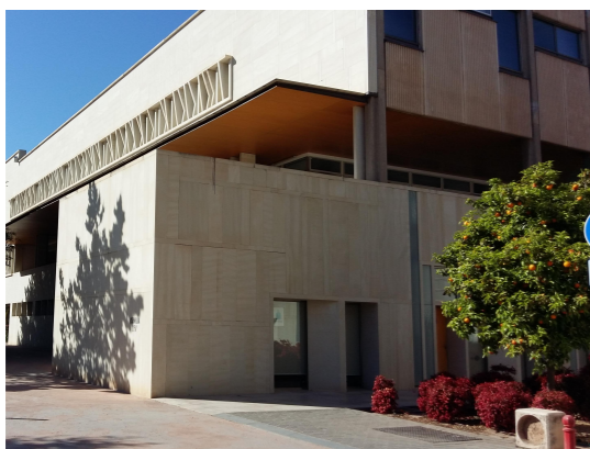
Encuentro entre Fachadas Este y Sur (módulo 8).
