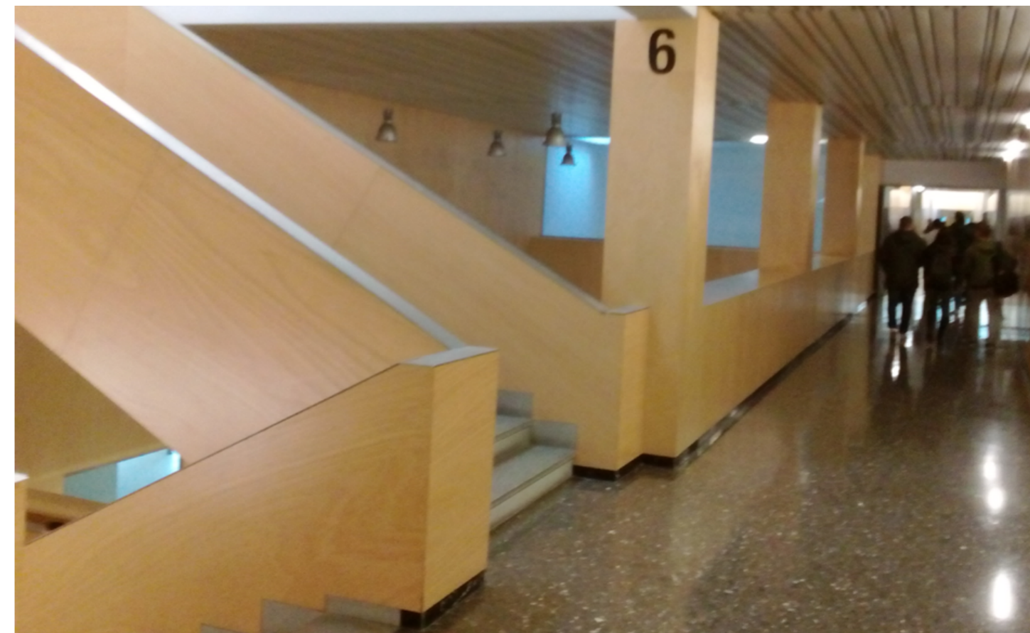
Escalera 6 (Planta 1ª junto a vestíbulo Este): Perspectiva del pasillo que comunica con los núcleos de escalera 3 y 4.
