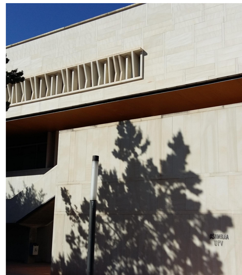
Fachada Sur recayente a la Avenida Tarongers (módulo 8).
