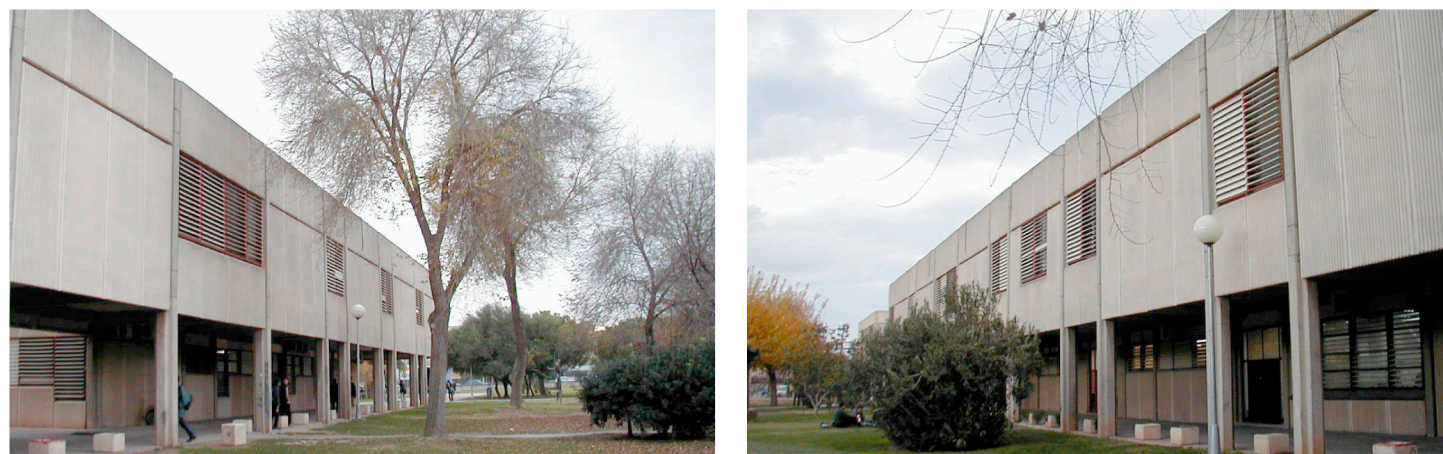
Distintos ángulos de la Fachada Oeste del Edificio en su Estado original previo a la reforma y ampliación (1998).
