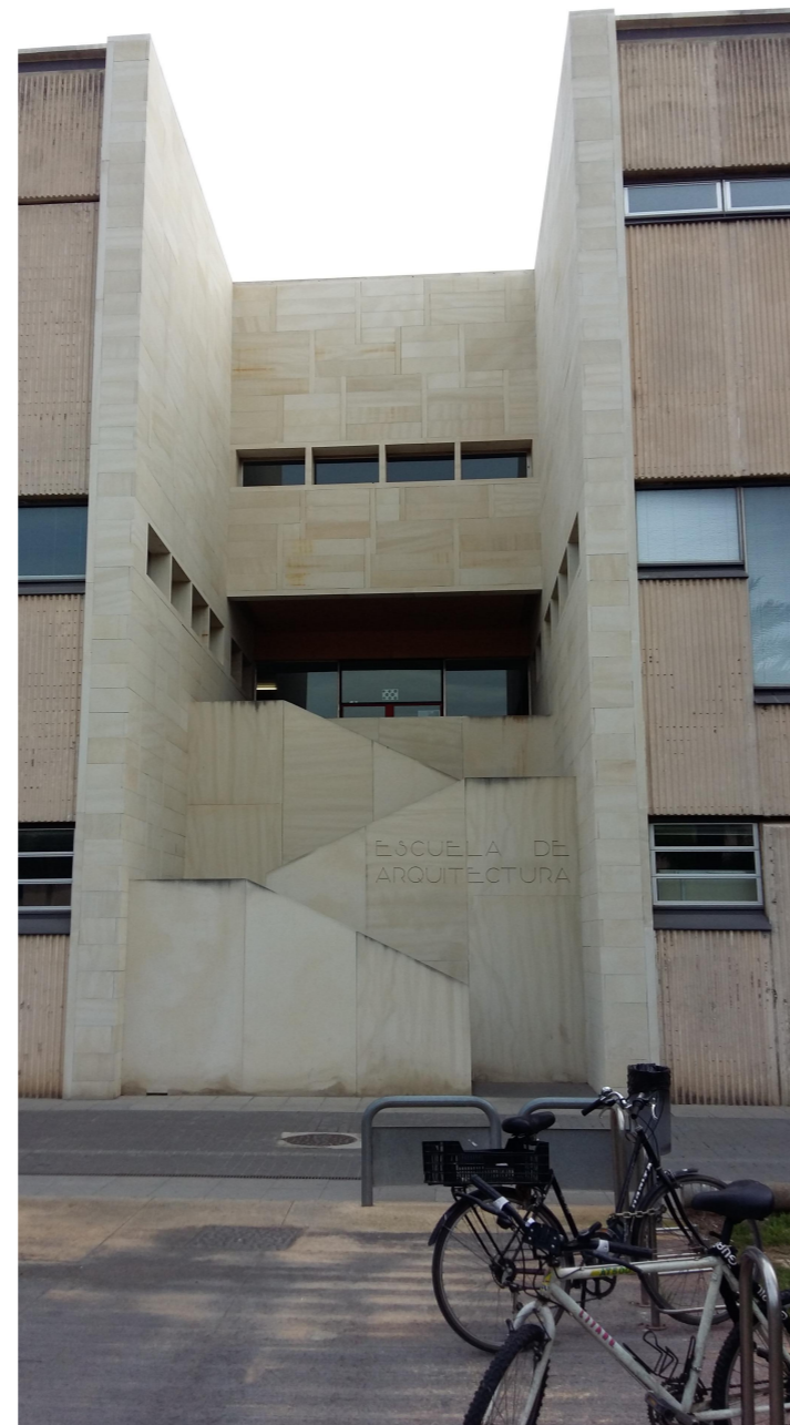
Fachada Norte: escalera de Acceso Principal.
