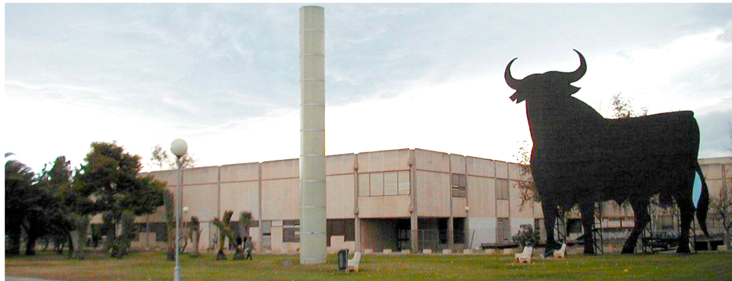
Fachada Sur del bloque 2B del Edificio y zona libre ajardinada en su Estado original (1998).
