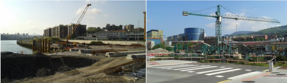
Imagen 15: Vista obras del canal Zorrozaurre Fuente: elaboración propia, Mayo 2016
