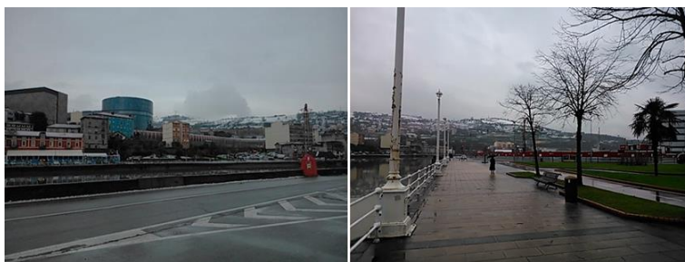
Imagen 14: Vistas obras del canal Zorrozaurre Fuente: elaboración propia, Febrero 2015
