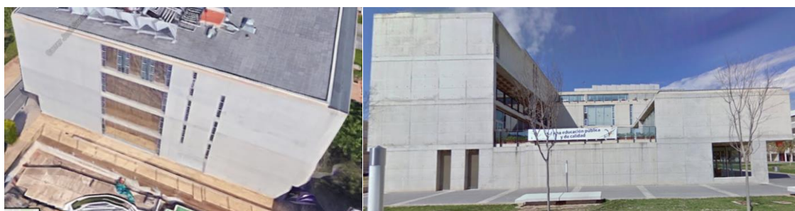
Ilustración 5. Fotografía de la cara este (derecha) y oeste (izquierda) del edificio
