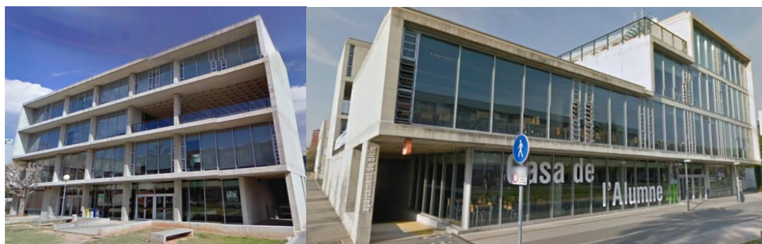
Ilustración 4. Fotografía de la cara norte (derecha) y sur (izquierda) del edificio
