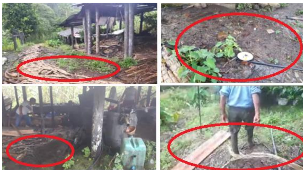
Figura 41. Superficies irregulares en la planta de producción de alcohol destilado. Fuente: Mario Paguay G.
