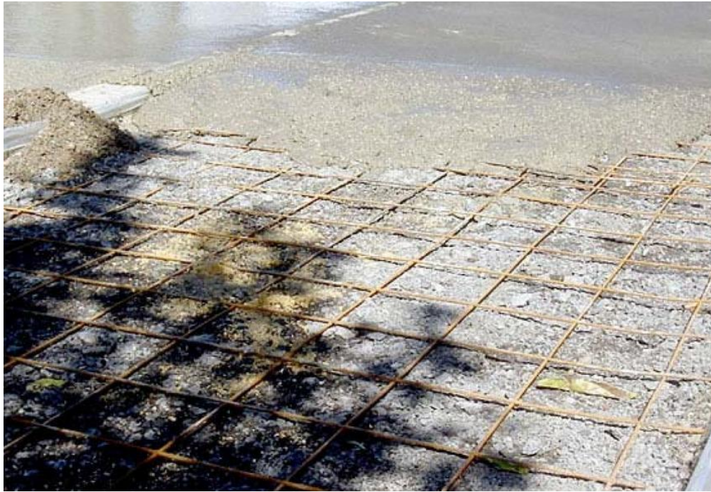
Figura 44. Materiales para hormigonar el piso.
