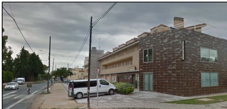
Imagen 3. Estado actual del edificio. Fuente propia
