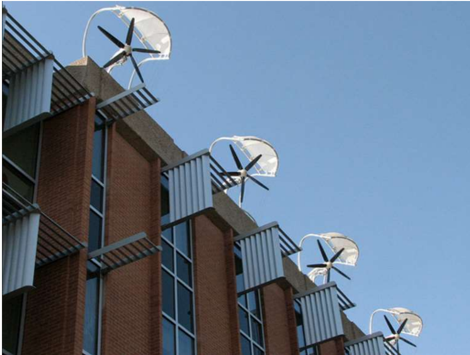
Figura 40.- Instalación de Mini-aerogeneradores en viviendas.
