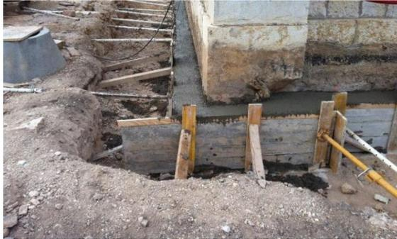
Figura 113. Imágenes Zanja, armado, encofrado y hormigonado del recalce fachada noroeste marzo 2016 Nave 4. Figuras propias 2016.
