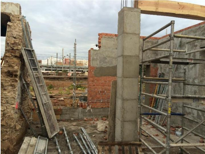
Figura 134. Imagen pilar en planta baja y viga de madera de forjado planta primera julio 2016 Alquería. Figuras propias 2016.
