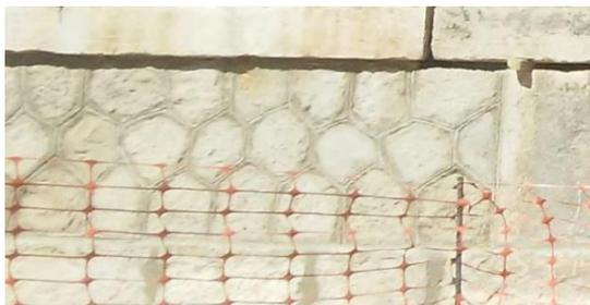
Figura 118. Imágenes antes y después del tratamiento de protección en muro de carga junio 2016 Nave 4. Figuras propias 2016.
