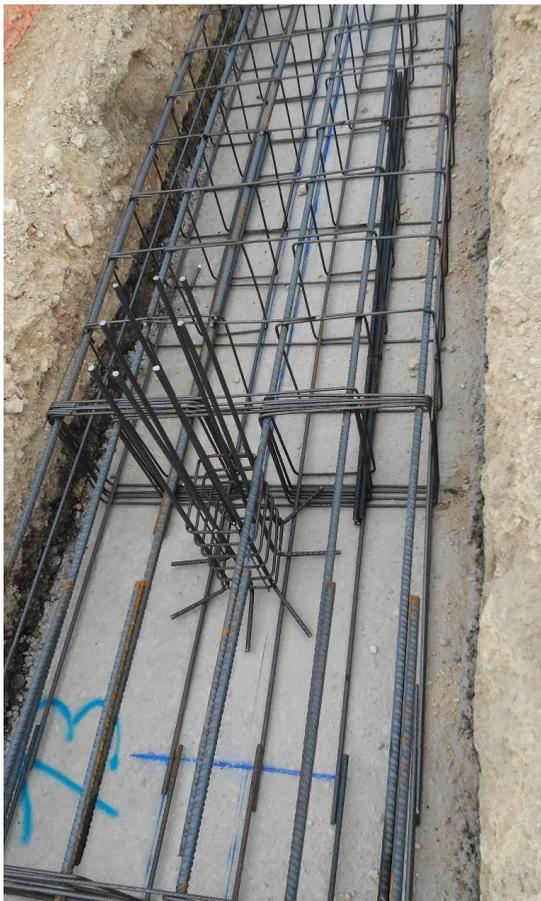
Figura 121. Imagen armado cimentación octubre 2015 Muelle 3. Figuras propias 2016.
