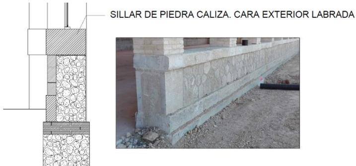
Figura 55. Detalle e imagen muro carga. Nave 1. Figuras propias 2016
