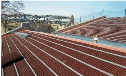
Figura 111. Imágenes montaje cubierta tipo diente de sierra febrero 2016
