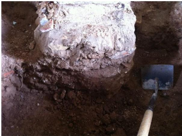
Figura 130. Imagen Cata de zapata aislada original junio 2016 Alquería.
