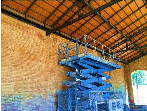
Figura 115. Imagen Plataforma elevadora para retacado interior del muro abril 2016 Nave 4. Figuras propias 2016.
