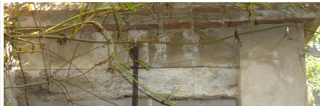
7. Vigas de madera de la cubierta del Baño de PB.
