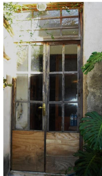
Ilustración 91. Trasdós de la Puerta doble de acceso al patio
