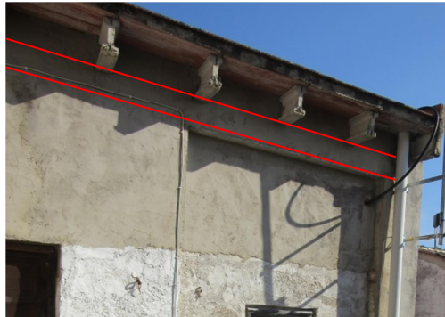
Ilustración 20. Localización de durmientes de las estructura de azotea
