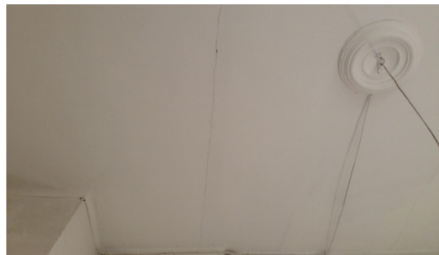
Ilustración 85. Falso techo de la cocina de PB
