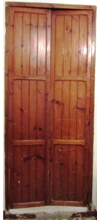
Ilustración 96. Puerta doble de acceso al dormitorio principal de PB
