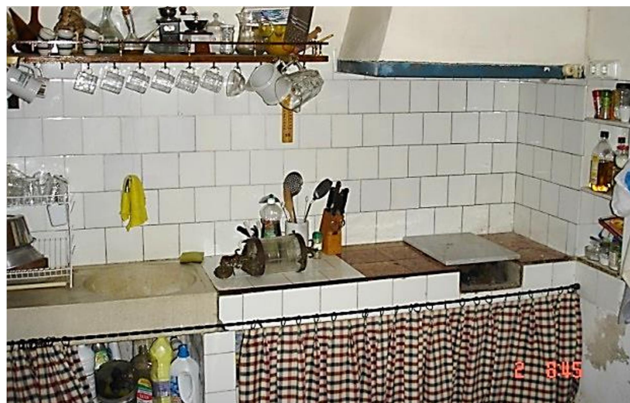
Ilustración 82. Cocina PB zona de fregadero y base de chimenea de cocina
