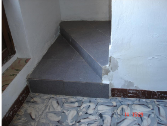
Ilustración 71. Primeros peldaños de la escalera
