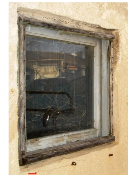
Ventana del Baño de P1ª
