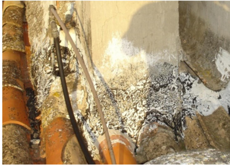
Ilustración 105. Salida de la tubería de agua fría por el tejado
