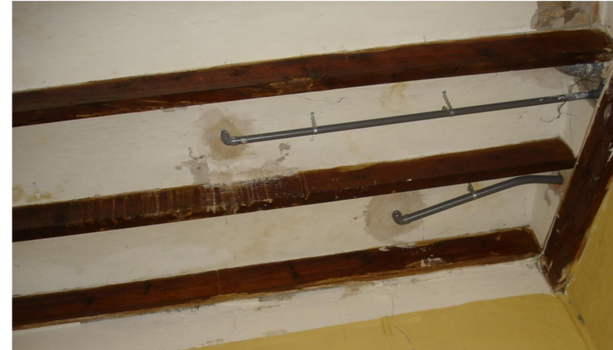
4. Techo del dormitorio 2 con colectores de saneamiento empotrados.
