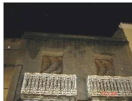
Fachada Principal Exterior en un día de Lluvia.
