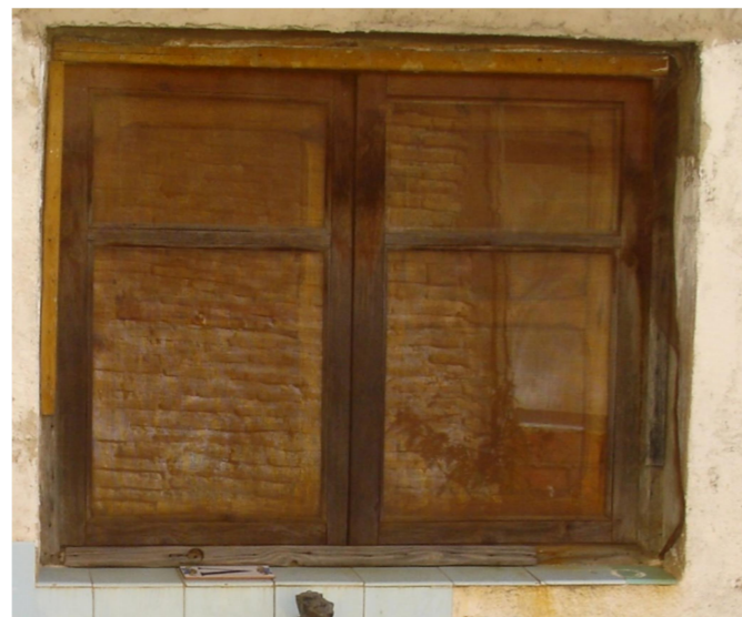
Ventana de la cocina de P1ª
