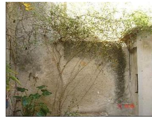
Muro Medianero Norte del Patio.
