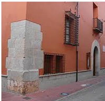
Ilustración 123. Esquina del Edificio consistorial de Potries
