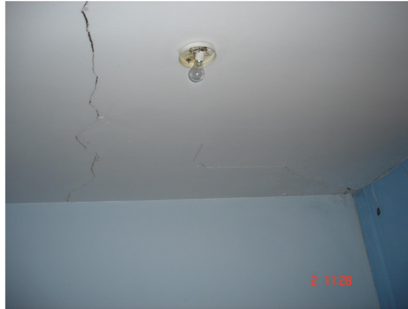
4. Lámpara y cableado del dormitorio 4.
