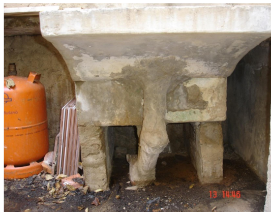
Ilustración 110. Tubería cerámica de saneamiento del lavadero del patio
