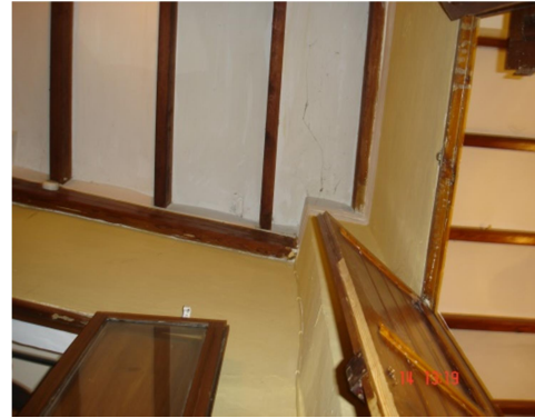
Ilustración 31. Viga entre pilastras zona Nord-este del dormitorio principal de PB
