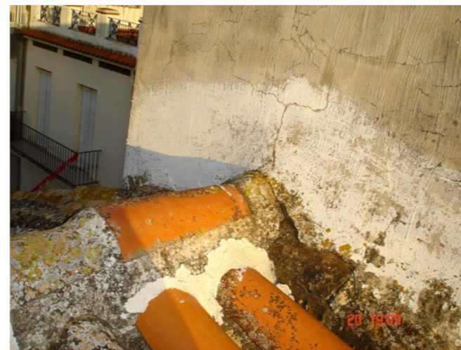
5. Encuentro de la cumbrera y el faldón del tejado con el muro Medianero Sur.
