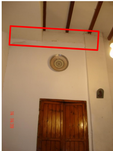
Ilustración 18. Viga intermedia entre el forjado principal y el forjado del dormitorio principal, que además sirve de apoyo a la escalera.
