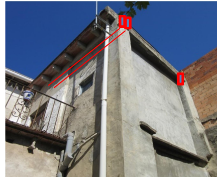
Ilustración 21. Localización de durmientes de las estructura de azotea
