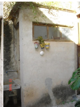
Ilustración 111. Regata de la tubería de saneamiento del lavabo del baño en PB
