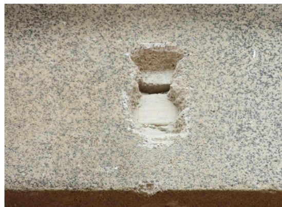
Ilustración 48. Cata en el trasdós del dintel del portón donde se observan 3 hiladas de fábrica de ladrillo, dispuestas a soga, y la esquina de la viga de hormigón armado
