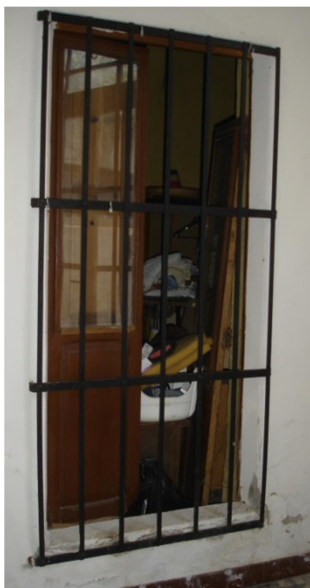
Ilustración 101. Reja del ventanal que comunica el dormitorio 2 PB con la cocina
