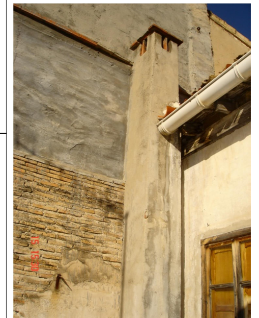
Chimenea y Alero de la Fachada Interior.
