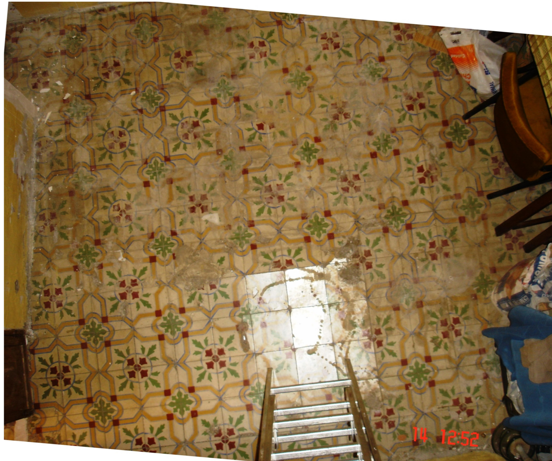
3. Zona central del pavimento del dormitorio 2.
