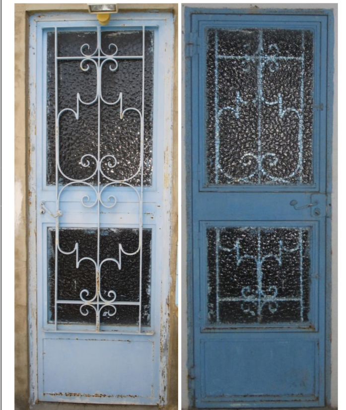
Puerta de acceso a la terraza
