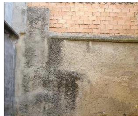
Muro Medianero Sur del Patio.
