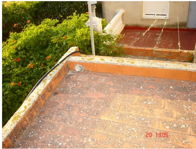
Ilustración 41. Azotea mediante forjado de bardos y acabado en rasillas
