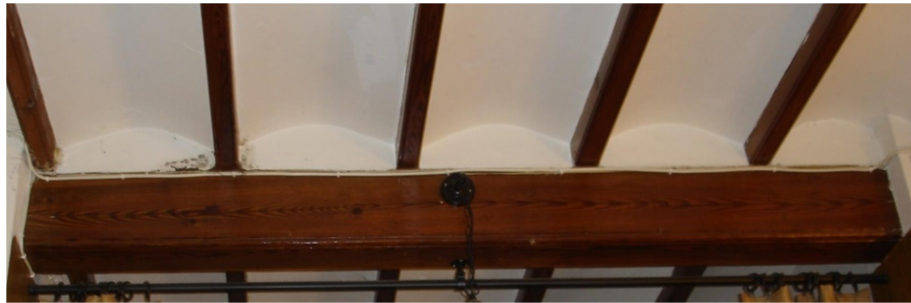
Ilustración 17. Viga central de madera del forjado principal.
