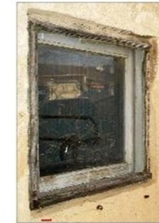
⑨ Trasdos de la ventana del Baño
