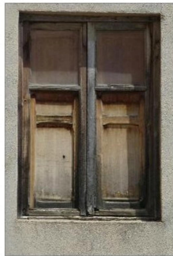
③ Trasdos de la ventana de la Fachada lateral
