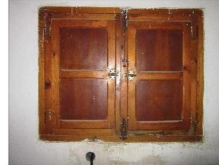
⑧ Intrados de la ventana de la cocina
