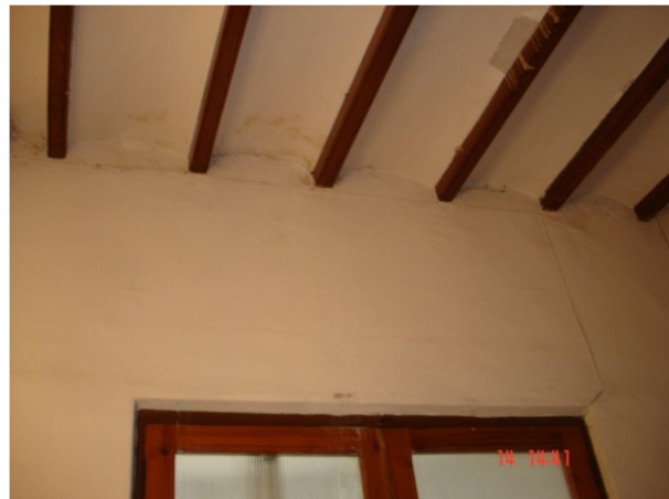
Ilustración 27. Apoyo interior de viguetas del forjado principal en muro
