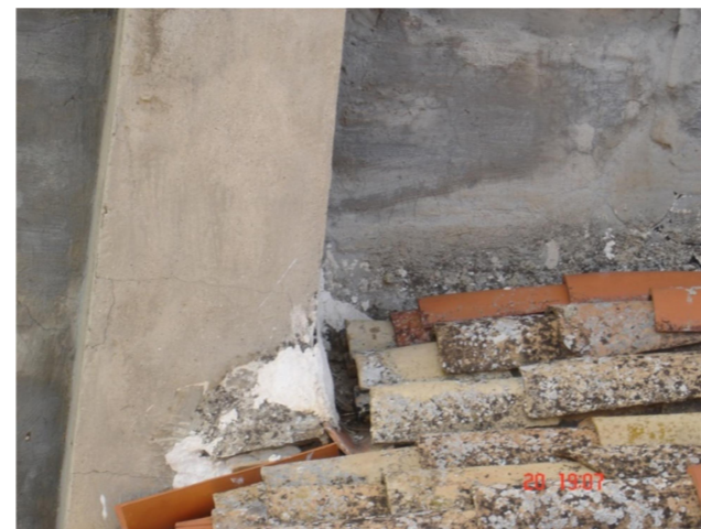
2. Encuentro del faldón del tejado con la chimenea de la cocina de PB.
