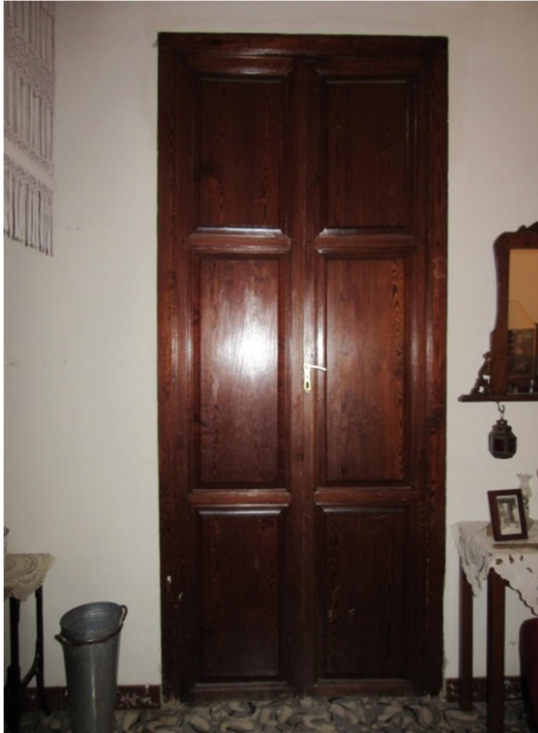
Ilustración 95. Puerta doble de acceso a la dormitorio lateral de PB que comunica con la escalera
