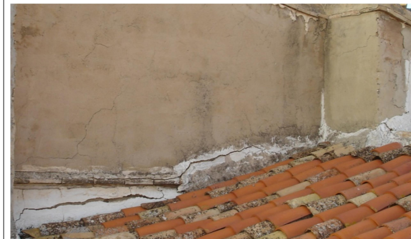
3. Encuentro del faldón del tejado con el muro Medianero Norte.
