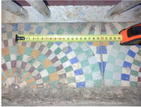
Ilustración 75. Baldosas hidráulicas en el trasdós ventanal de la fachada principal.
