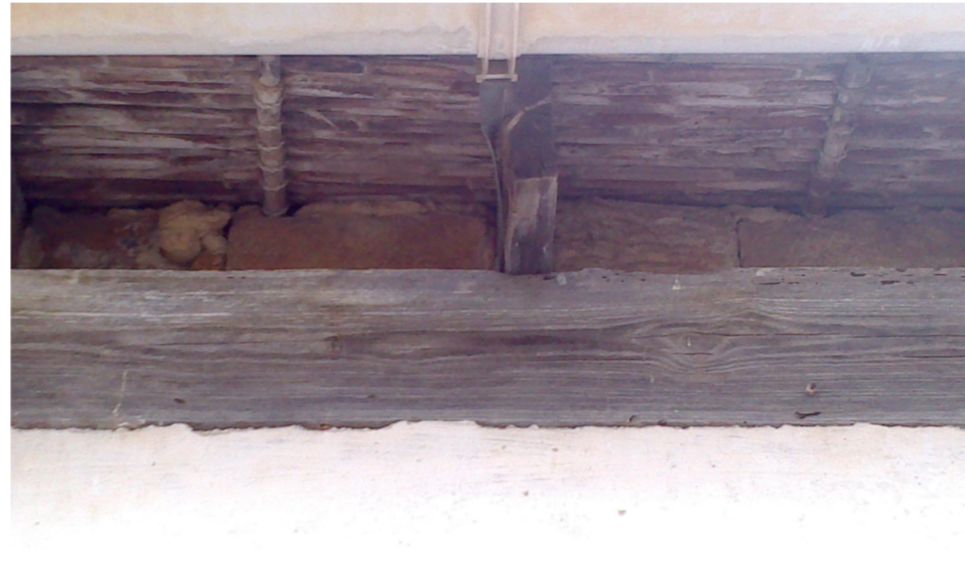
4. Alero del tejado en la fachada interior.
