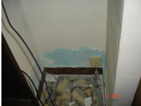
Ilustración 118. Salida de cableado telefónico
