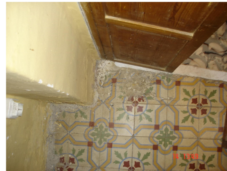
1. Zona cercana a la puerta de acceso a la dormitorio 2.
