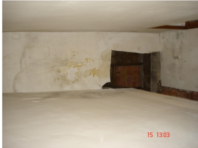
3. Falso techo del descansillo de la escalera donde hubo una importante reparación del tejado.
