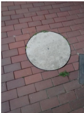
Ilustración 126. Tapa de registro del Aljibe
