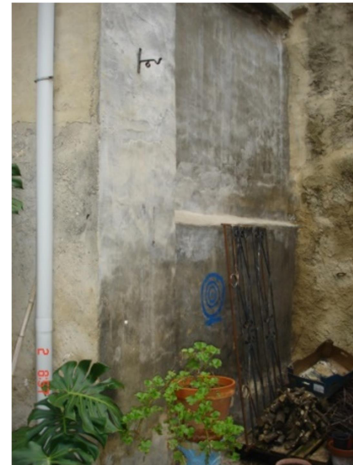
Ilustración 52. Fachada del Patio trasdós del dormitorio principal
