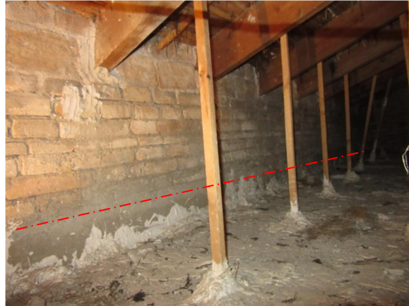
Ilustración 50. Dintel que cubre los vanos de las puertas de acceso a los balcones, marcado en línea roja discontinua
