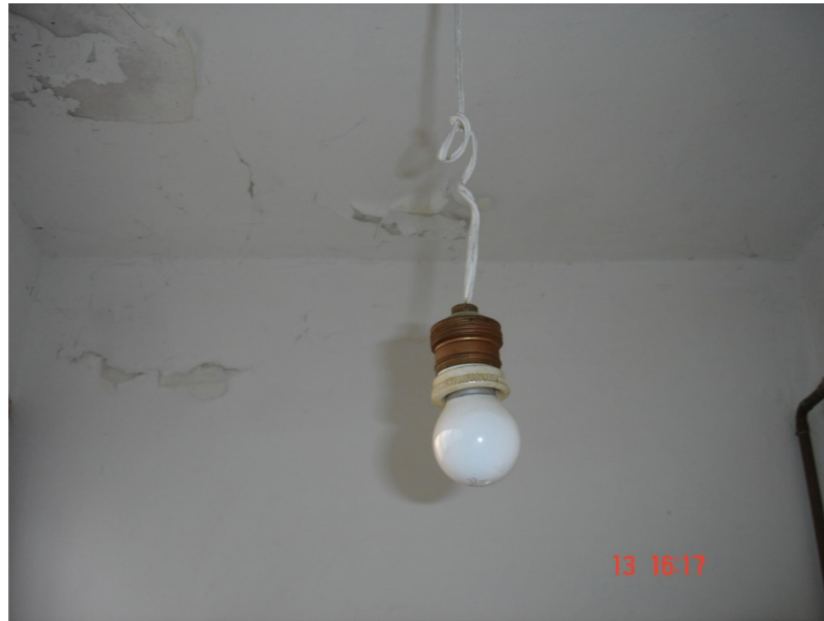
3. Techo del baño de PB.
