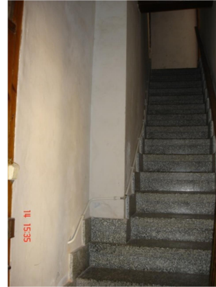
Ilustración 72. Escalera vista desde el primer descansillo
