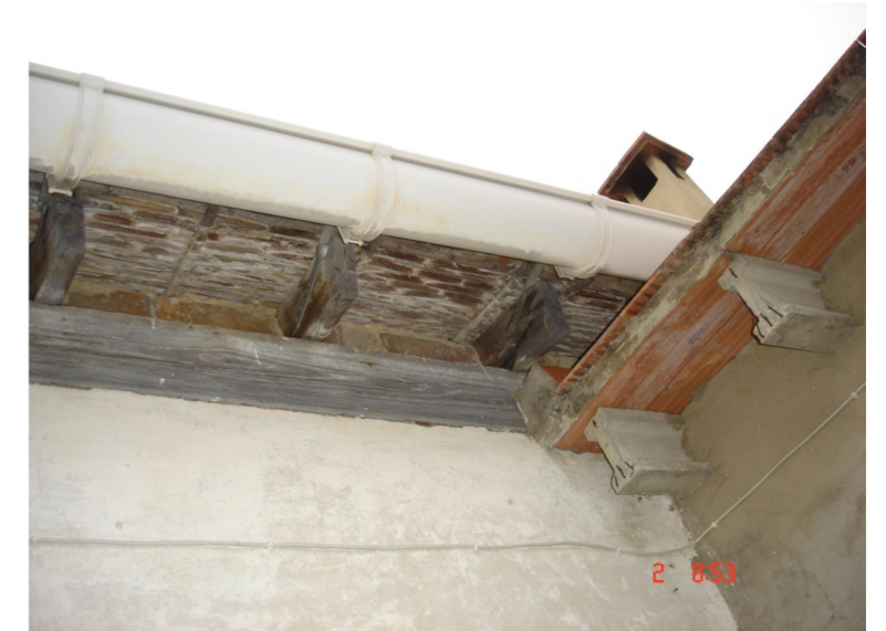
5. Alero del tejado en la fachada interior.
