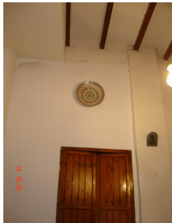
Ilustración 26. Apoyo interior de viguetas del forjado principal en viga entre pilastras
