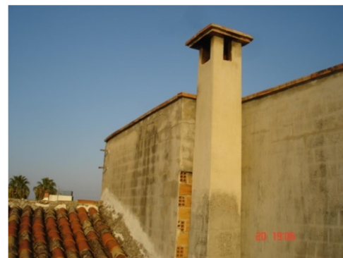
Ilustración 65. Remate del tubo de extracción de la chimenea del salón-comedor
