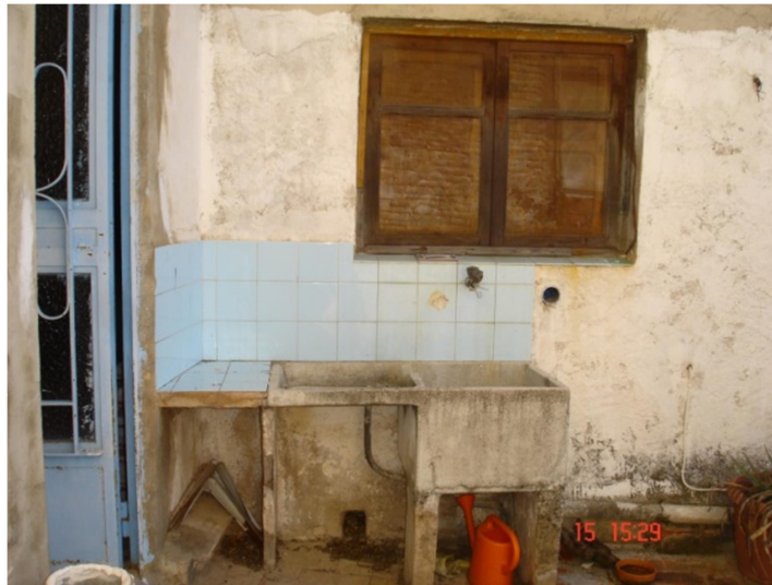
Ilustración 81. Fachada interior del patio donde se sitúa el lavadero en P1
