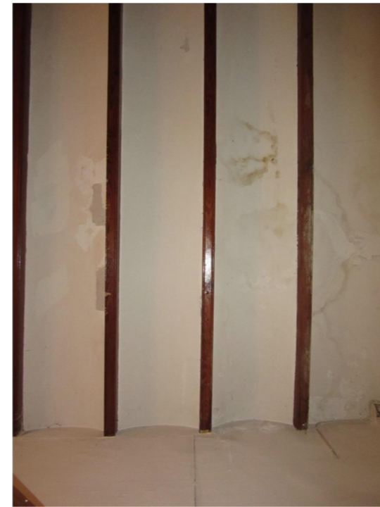
1. Techo del salón-comedor de PB.
