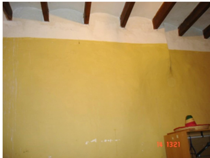
Ilustración 32. Muro medianero sur del dormitorio 2 de PB
