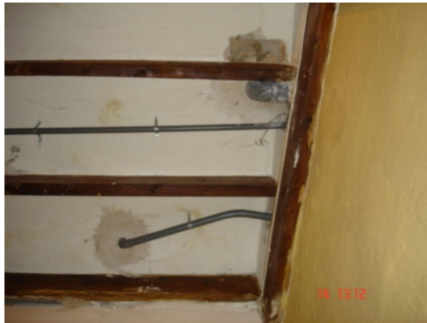
Ilustración 108. Recogida de aguas fecales del baño y cocina de P1
