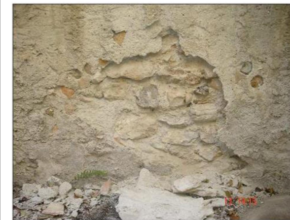
1. Muro Oeste del patio
