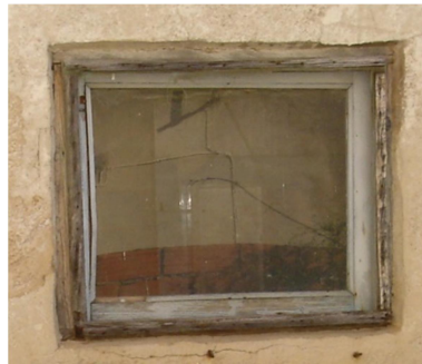
Ilustración 94. Trasdós de la ventana simple del baño P1ª
