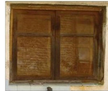
⑦ Trasdos de la ventana de la cocina
