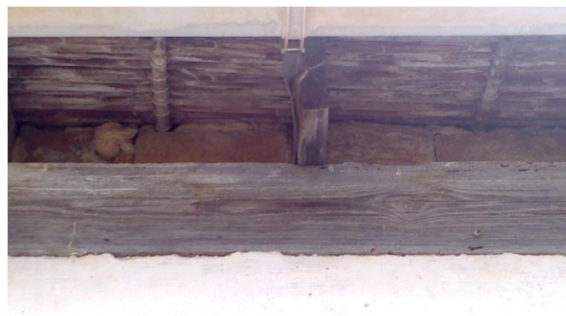
Ilustración 19. Dormiente o viga de reparto de cubierta
