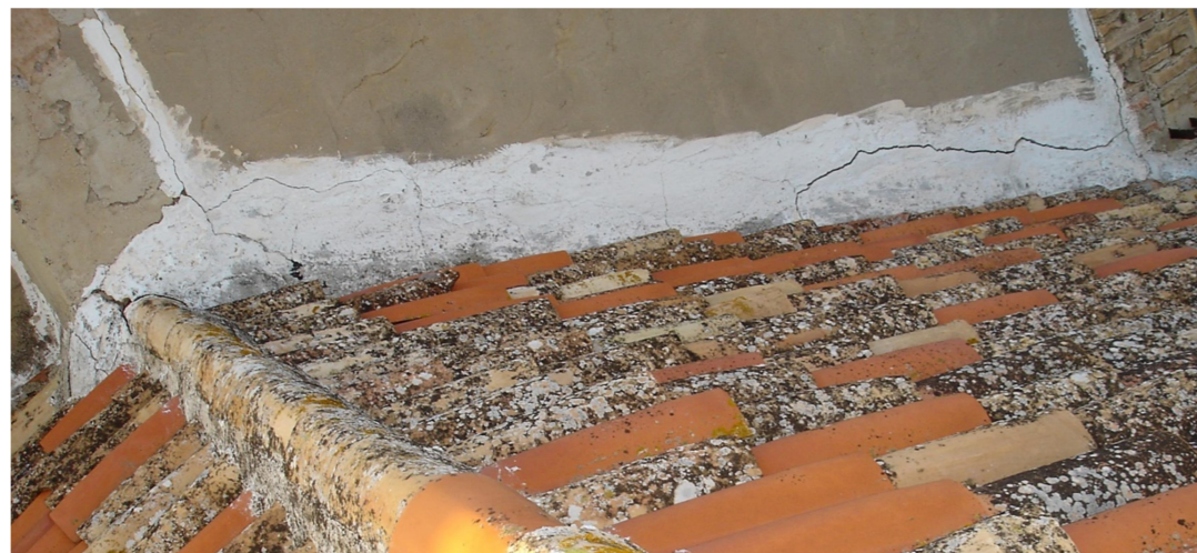
4. Encuentro de la cumbrera y el faldón del tejado con el muro Medianero Norte.
