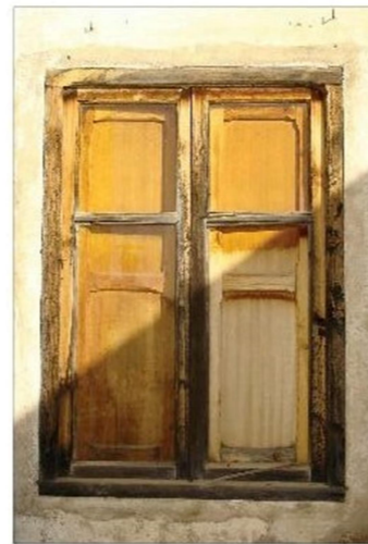
⑤ Trasdos de la ventana del Dormitorio 3
