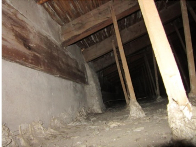
Ilustración 28. Apoyo de cargas de cubierta en estructura vertical de la fachada interior-patio
