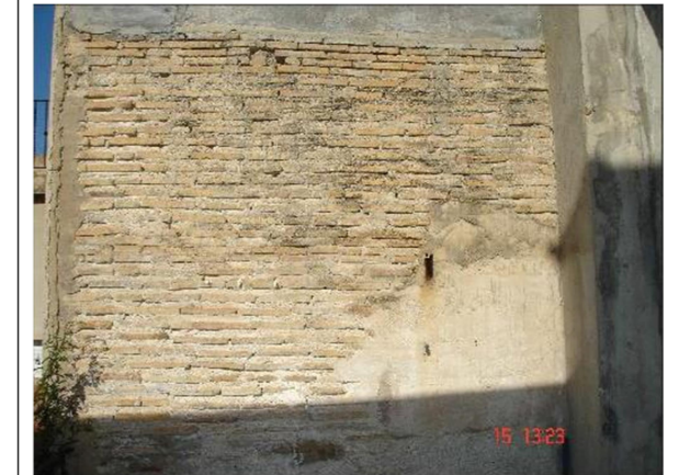
2. Muro Medianero Norte del patio (a la altura de la terraza)
