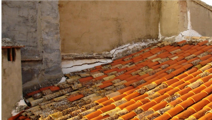
Ilustración 39. Encuentro del tejado con paramento medianero
