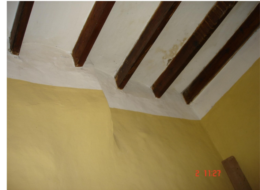
4. Techo del dormitorio 2.
