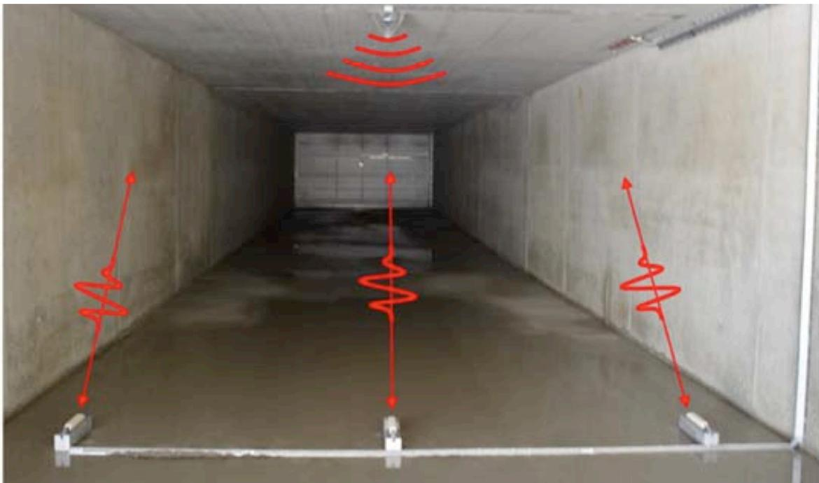
Imagen 3. Instalación del equipo NivuFlow750 en el canal.
