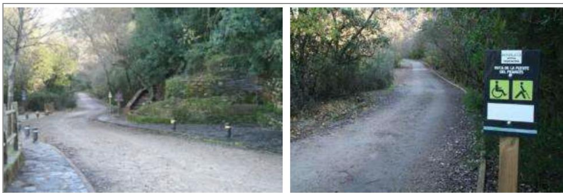
Ilustración 25: Ruta de la Fuente del Francés (Cantabria). Señalética, pivote guía y pavimento accesible.
