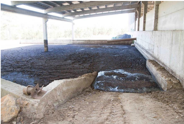
Figura 4.4. Fosa séptica. (Fuente: elaboración propia)
