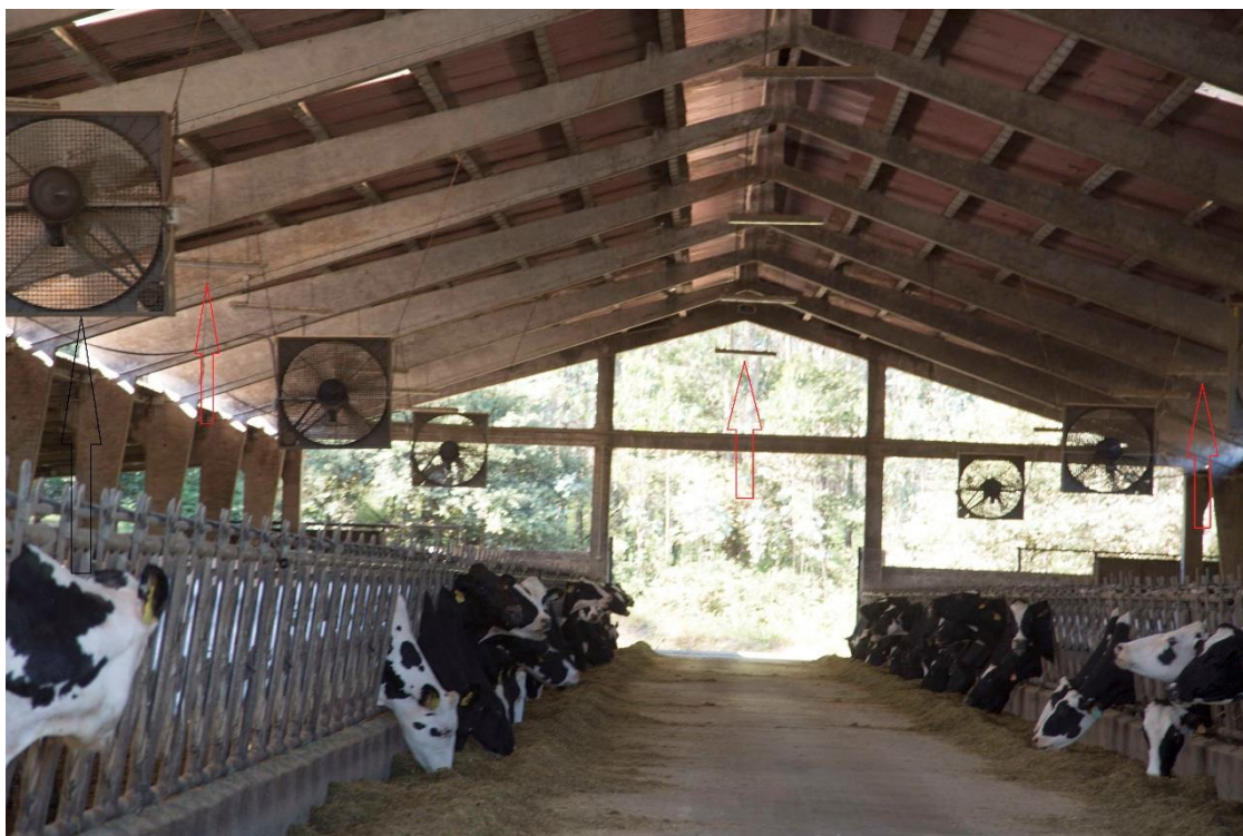
Figura 2.3. Flechas rojas iluminación, flecha negra ventilador. Fuente: elaboración propia
