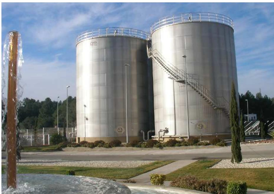
**Figura 5:** Depósitos para recogida de aguas pluviales y posterior reutilización.
