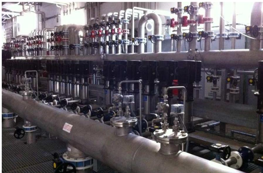
Figura 7: Colectores de sistema de colectores de distribución de aguas para servicio de producción y auxiliar.
