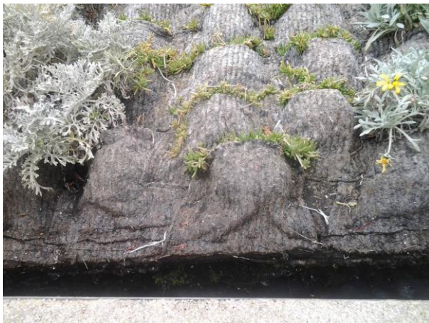
Figura 3. Paneles forrados con geotextiles tejidos retenedores de agua.
