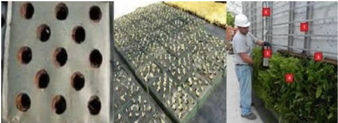
Figura 16. Sistema modular de paneles vegetados en caja metálica de GSKy Plant Systems Inc.
