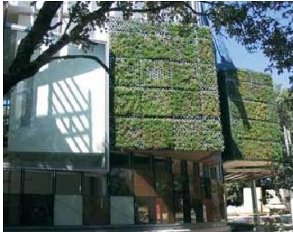
Figura 15. Paneles vegetados en celdas metálicas. Sistema creado por Intemper.
