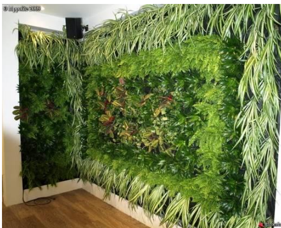
Figura 8. Sistema hidropónico en fachadas.
