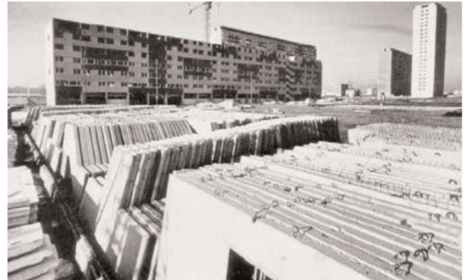
Gráfico 91: Acopio a pie de obra de grandes paneles de la patente Tracoba, Francia Fuente: https://www.mysciencework.com/publication/read/2171257/proceso-continuo-de-
