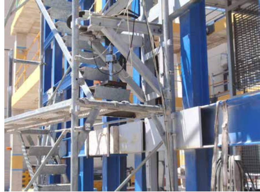
Gráfico 115: Sistemas de andamios Fuente: http://www.lineaprevencion.com/ProjectMiniSites/IS35/html/2-1-2/2_1_2_2.html
