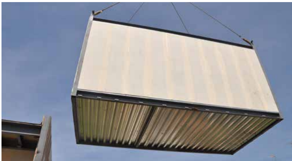
Gráfico 131: Montaje de una vivienda en base a un sistema modular Fuente: https://ecodomusarquitectos.files.wordpress.com/2012/06/blackberry-131.jpg
