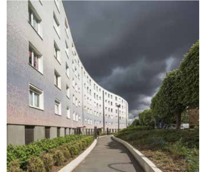
Gráfico 98: Fachada del bloque de vivienda HLM en la Grande Borne, Grigny, al Sur de París, entre 1964 Fuente: http://www.descroll.com/architecture/the-rebirth-of-the-serpentin-public-housing/attachment/2-223
