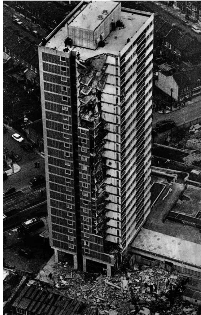
Gráfico 108: Derrumbamiento de la torre prefabricada Ronan Point en Londres en 1968
