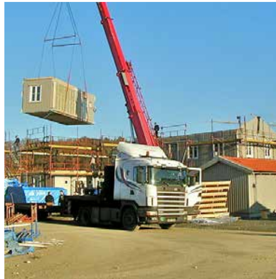
Gráfico 159: Montaje de casas modulares de Ikea Fuente: https://arquitecturayrehabilitacion.wordpress.com/2012/05/17/boklok-las-casas-modulares-de-ikea/
