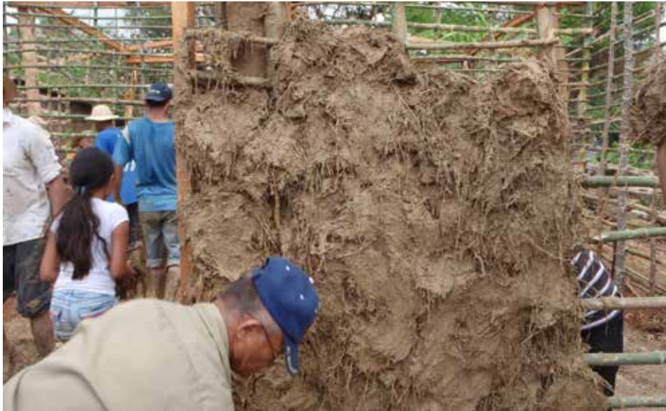
Gráfico 286: Construcción de muro con quincha tradicional
