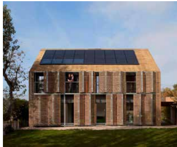
Gráfico 322: Diseño de vivienda pasiva en bambú en Benssacourt. La estructura está conformada de paneles de madera sólida y está cubierta con una segunda piel de bambú no tratado. Fuente: http://noticias.arq.com.mx/Detalles/11304.html#.VkZqs3YvfiV
