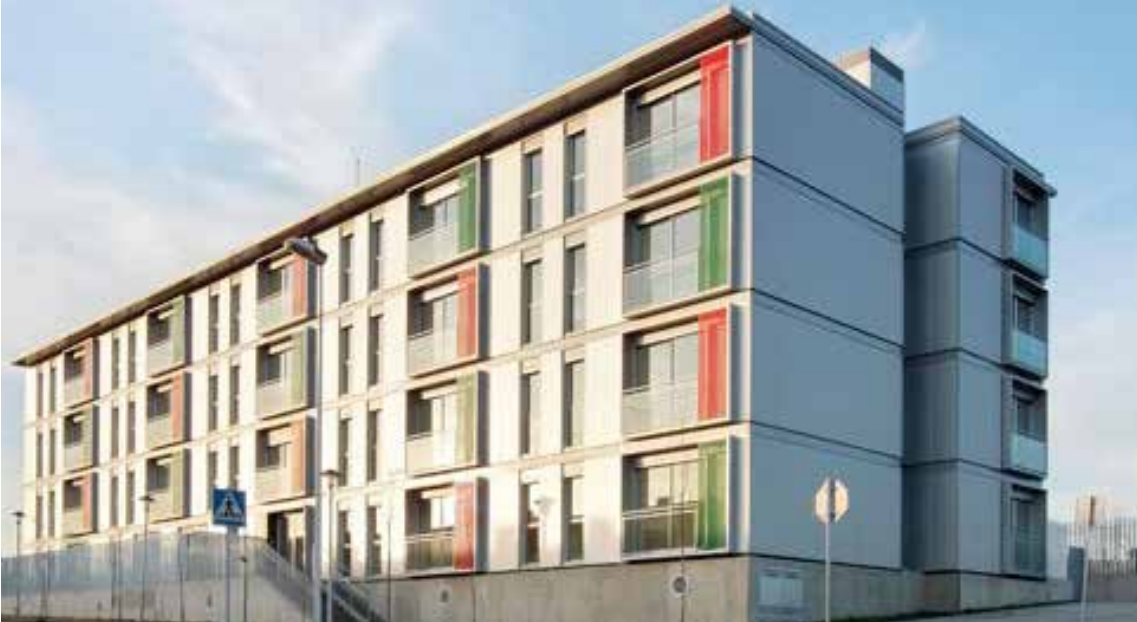
Gráfico 165: Vista General de edificio a base de Sistema Modular, Moldutec Fuente: http://www.modultec.es/qui%3%A9nes-somos/
