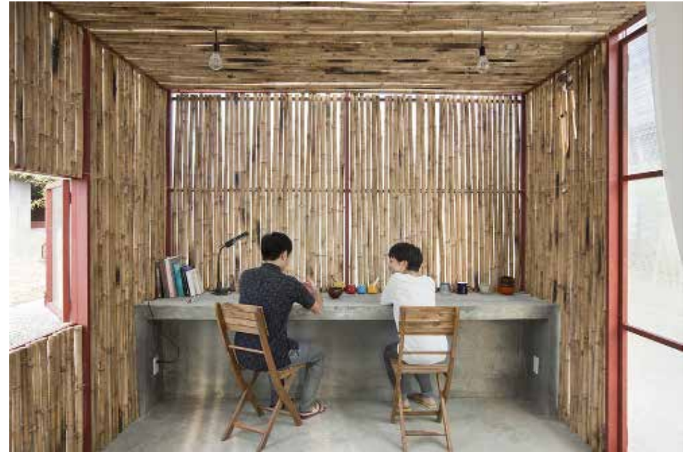
Gráfico 357: Paredes de caña picada Fuente: http://faircompanies.com/news/view/10-casas-bambu-el-
