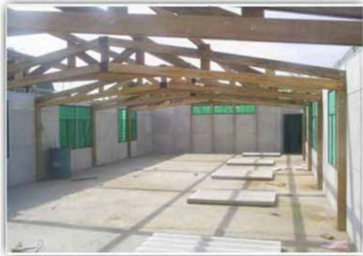
Gráfico 275: Albergue construido con las mismas tecnologías de viviendas prefabricadas Fuente: http://es.slideshare.net/FernandoEnriquez1/cotizaciones-modelo-principal-mariana-de-jesus-14349403
