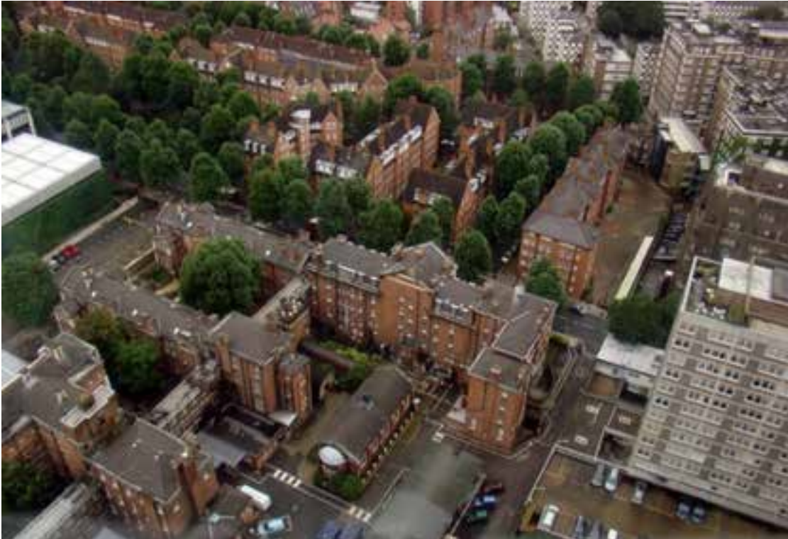
Gráfico 11: Vista Superior del Millbank Estate del LCC en Londres Fuente: http://www.britishlistedbuildings.co.uk/images/buildings/en/411/411462-29495-800.jpg
