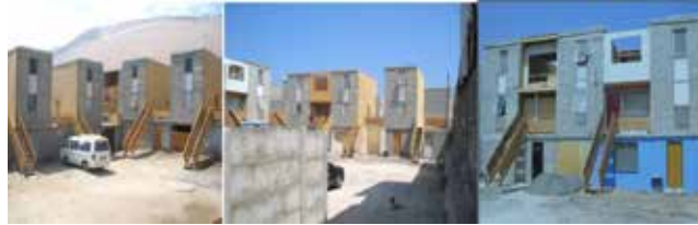
Gráfico 226: Intervención autoconstrucción fachada Fuente: http://laboratoriovivienda21.com/magazine/?p=133
