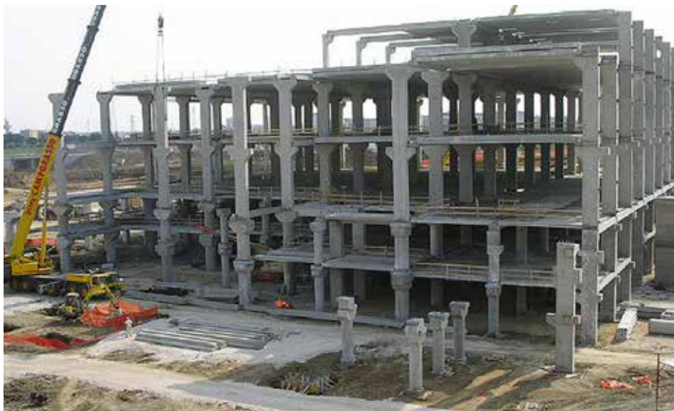
Gráfico 81: Prefabricación de un edificio en hormigón
