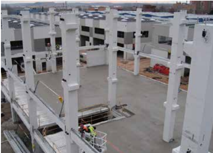
Gráfico 80: Edificios prefabricados modernos Fuente: http://www.tecnyconta.es/archivos/noticias/390100th-web_pilares_foto_06.jpg
