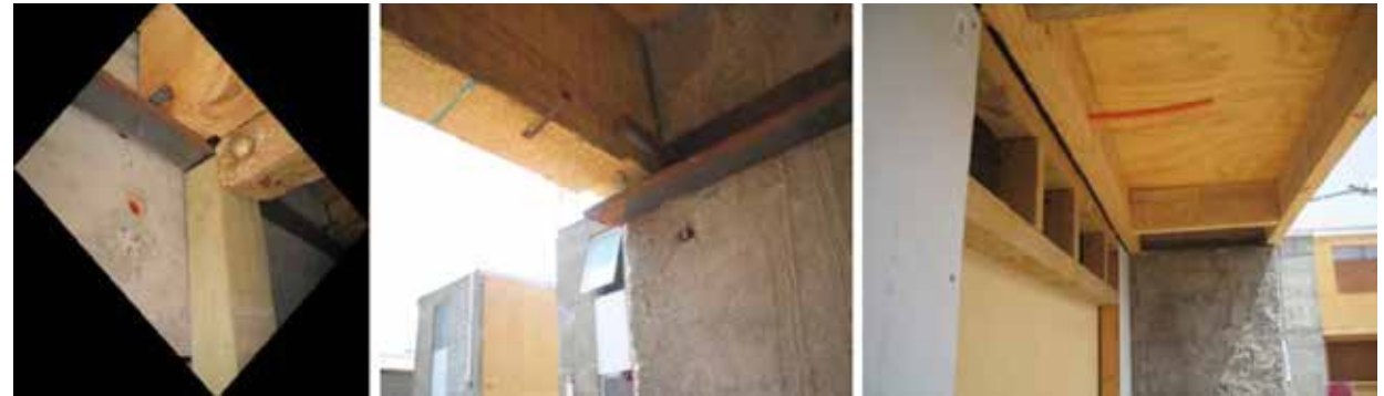
Gráfico 233: Uso de tabiquerías livianas entre medianeras Fuente: http://laboratoriovivienda21.com/magazine/?p=133
