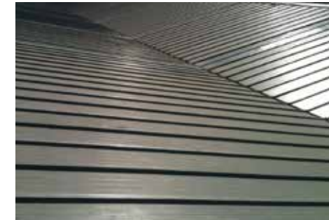
Gráfico 360: Cubierta metálica Fuente: http://metalyamianto.blogspot.com.es/2011_12_01_archive.html
