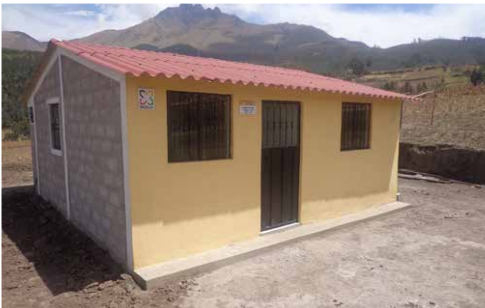
Gráfico 271: Fachada frontal de vivienda tipo MIDUVI
