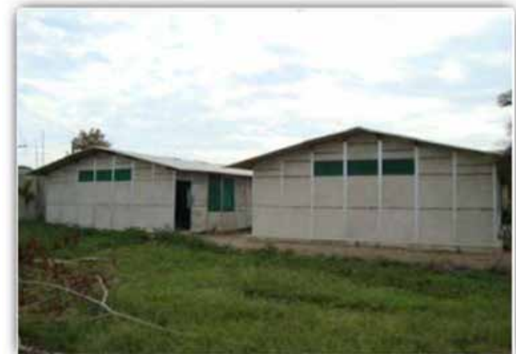
Gráfico 276: Vista exterior de albergue construido con las mismas tecnologías de viviendas prefabricadas Fuente: http://es.slideshare.net/FernandoEnriquez1/cotizaciones-modelo-principal-mariana-de-jesus-14349403
