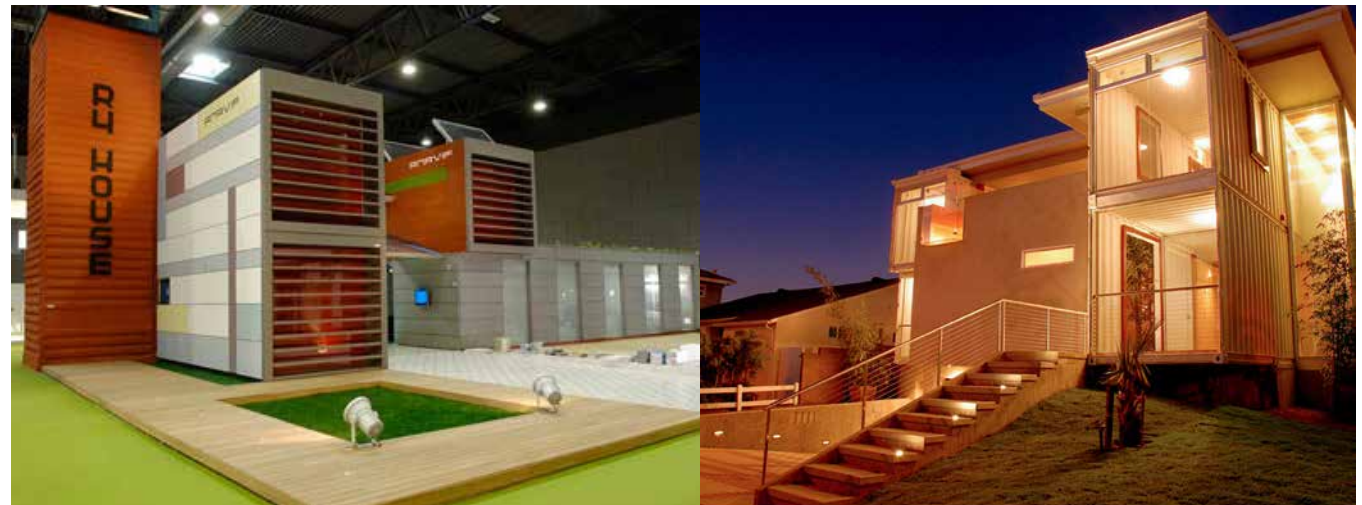
Gráfico 186: A la izquierda R4, Chile y a la derecha Rdondo Beach cointainer houseFuente: http://www.actividades-mcp.es/gestionresiduos/2012/05/casas-modulares-fabricadas-con-contenedores-baratas-y-ecologicas/
