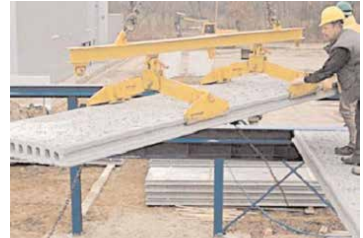
Gráfico 117: Prelosa para la construcción del forjado
