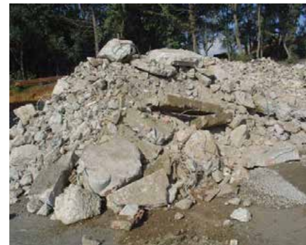
Gráfico 172: Demolición de residuos Fuente: http://www.interempresas.net/Construccion/Articulos/31287-El-mercado-
