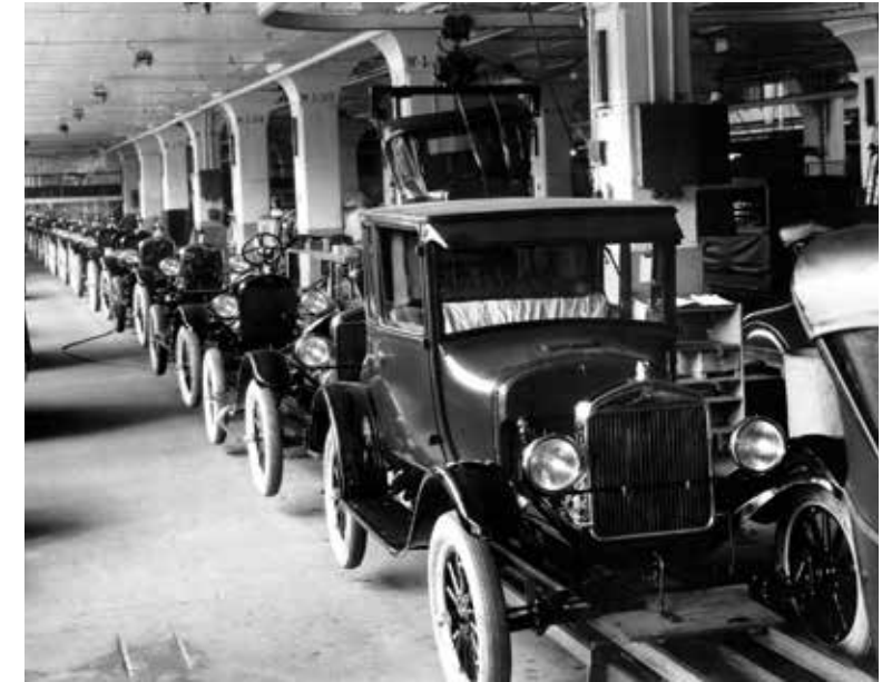
Gráfico 88: Cadena de montaje de Henry Ford Fuente: http://lostractoresantiguos.blogspot.com.es/2013/07/historia-de-henry-ford-y-tractores-ford.html
