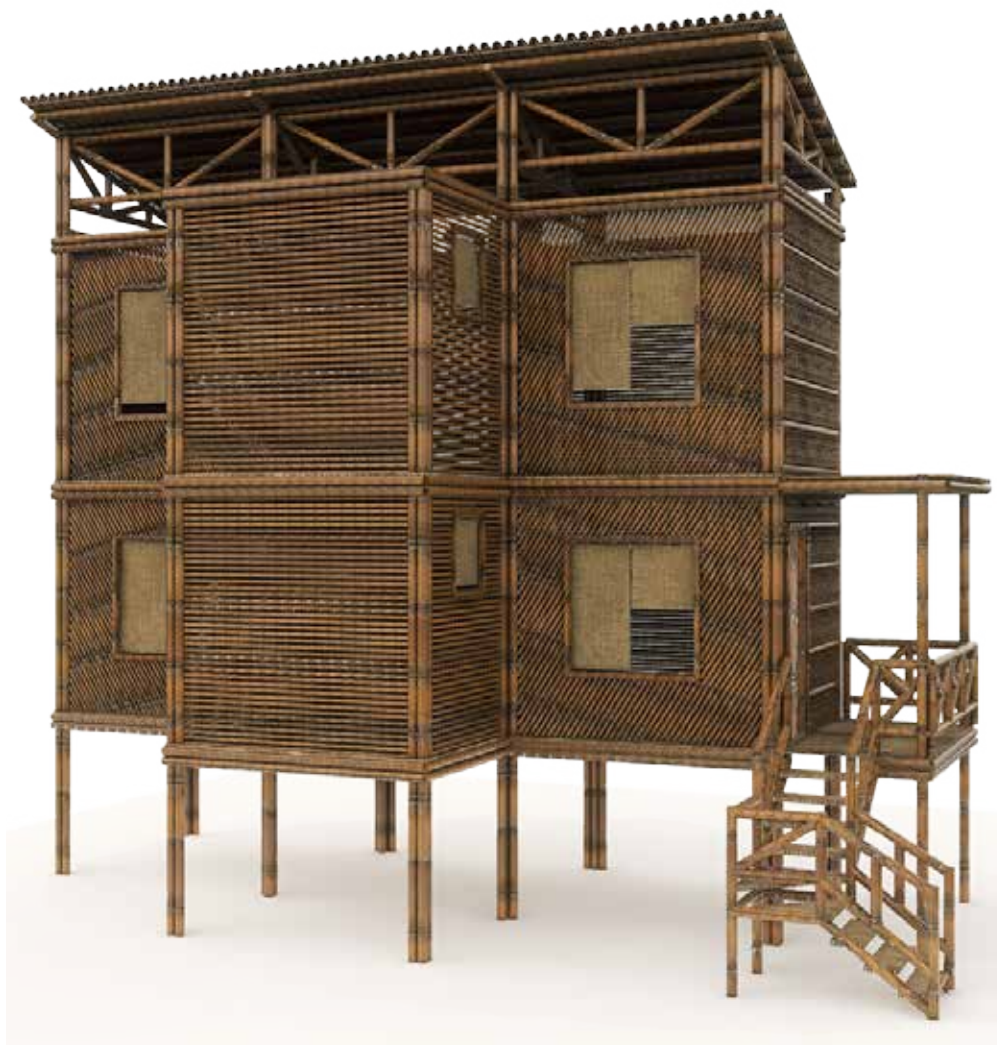
A la izquierda se muestra la fachada lateral de la tipología de vivienda A, donde se puede visualizar el volumen que encierra a la escalera, cuyos paneles dotados de transparencia permiten el paso de la luz natural. Las ventanas se ubican mayormente hacia ésta fachada que es la más larga de la vivienda.
