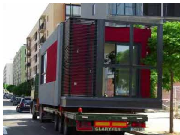
Gráfico 144: Transporte Sistema Constructivo Habidite Fuente: https://www.youtube.com/watch?v=kUYlg_qXkig
