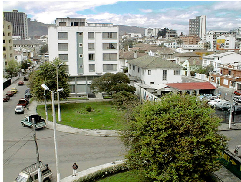
Figura 70. Estado anterior a la intervención
