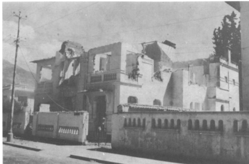
Figura 49. Vivienda en deterioro Fuente: Revista geográfica 84, 1976
