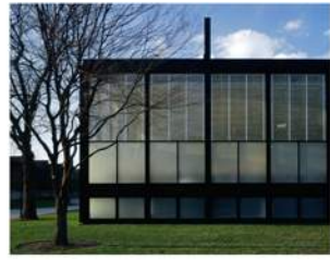
Fig. 29 Vista exterior, volumen que se extiende en voladizo en los laterales. Crown Hall.
