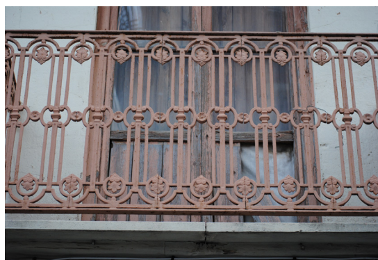
Calle Jose Benllure Barandilla de hierro fundido con fantasías curvadas y flores
