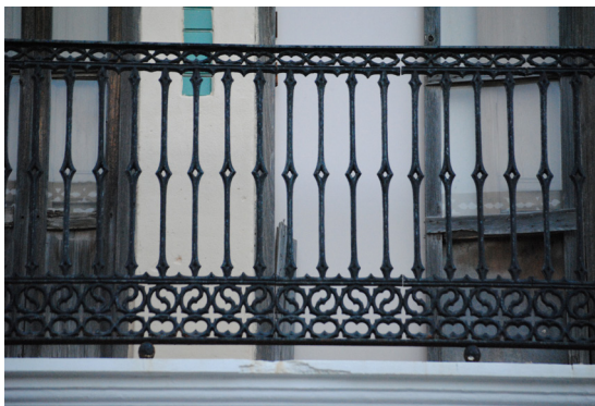
Calle Barraca 151 Barandilla de hierro fundido con tracerías
