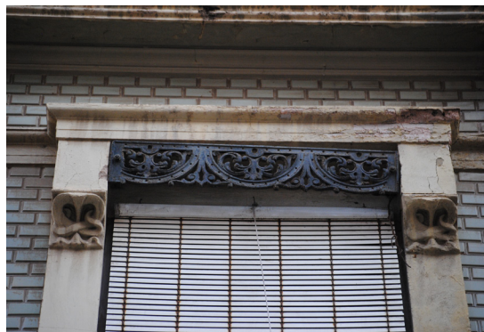
Calle Jose Benllure 98 Guardamalleta de perfil rectangular de hierro fundido con fantasías de inspiración Barroca
