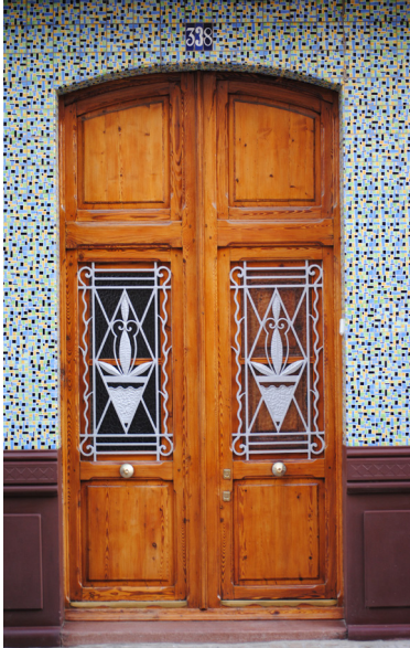
Calle del Padre Luis Navarro 338 Portón de dos hojas de madera de perfil curvado con rejas centrales con fantasías modernistas
