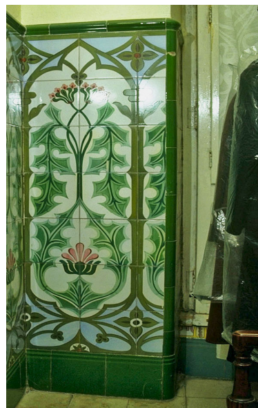
Calle Jose Benllure 317 Zócalo de azulejos de mayólica decorados por el sistema de trepas en fantasía enlazada ascendente con elementos florales y vegetales
