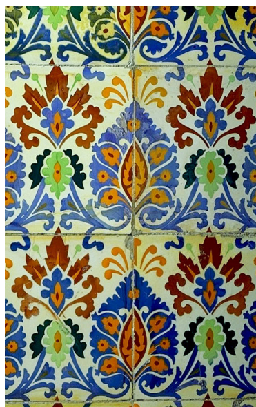
Calle Jose Benllure 246 Zócalo de azulejos de mayólica decorados por el sistema de trepas en fantasía simple con arabescos
