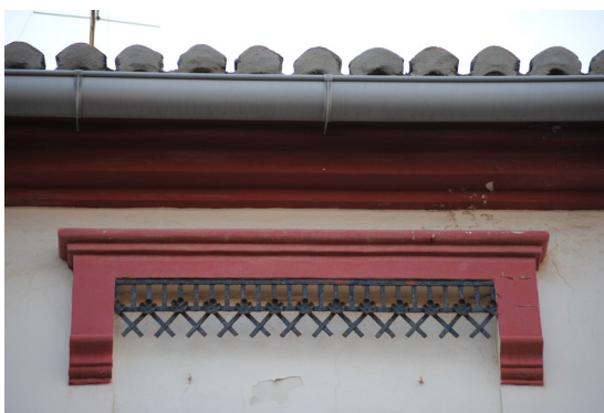
Calle del Progreso 249 Guardamalleta de perfil rectangular de hierro forjado con elementos florales
