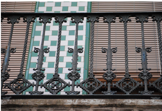
Calle de la Reina 196 Barandilla de hierro fundido con fantasías florales y elementos geométricos
