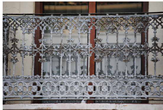
Calle José Benllure 231 Barandilla de hierro fundido con tracerías y elementos florales de inspiración Gótica
