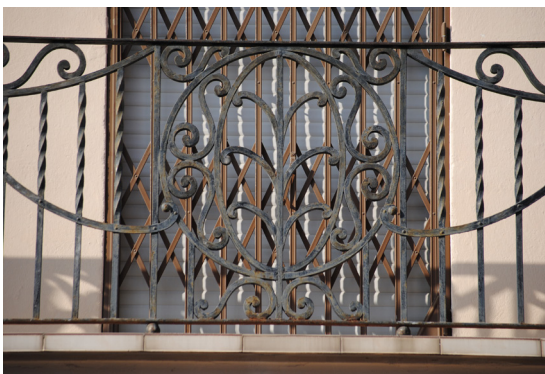
Calle Escalante 327 Barandilla de hierro forjado con elemento central con espirales
