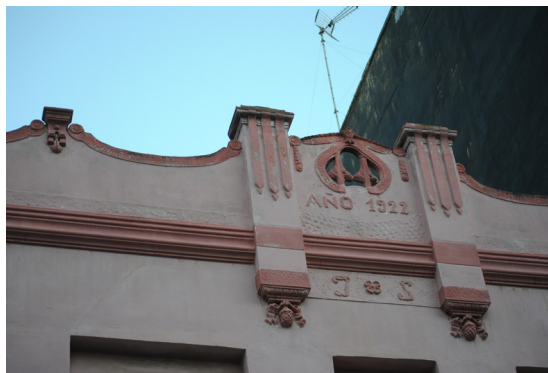
Calle Barraca 104 Frontispicio de perfil mixtilíneo con óculo central, elementos vegetales y geométricos y monogramas de letras y fecha
