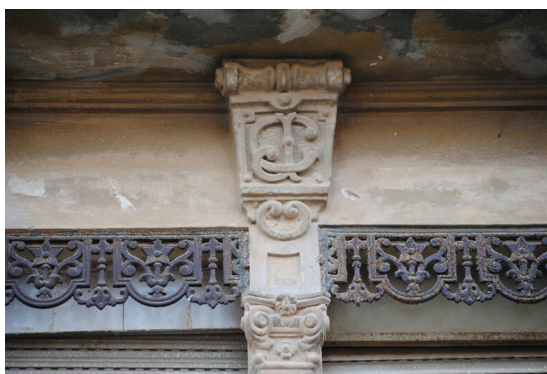
Calle de Amparo Guillem 2 Monogramas de iniciales en piedra artificial posicionado en capitel
