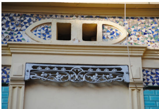
Calle de Escalante 279 Guardamalleta de perfil rectangular de hierro fundido con elementos florales y fantasías estilo Art Nouveau
