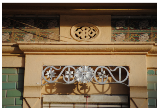
Calle del Progreso 220 Guardamalleta de perfil mixtilíneo de hierro forjado con elementos floreales
