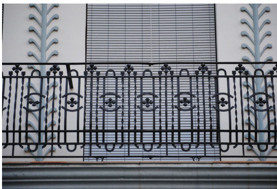
Calle Barraca 23 Barandilla de hierro forjado con elementos florales
