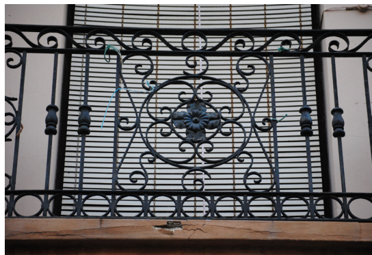
Calle Jose Benllure 23 Barandilla de hierro forjado con elemento central con espirales y flor
