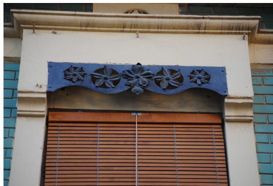
Calle Barraca 257 Guardamalleta de perfil rectangular de lámina de hierro perforada con flores forjados
