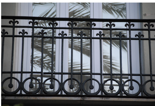
Calle Barraca 98 Barandilla de hierro fundido con fantasía simple
