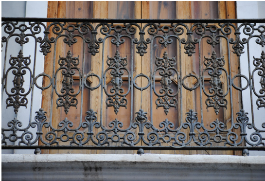
Calle José Benllure 152 Barandilla de hierro fundido con fantasías de inspiración Barroca
