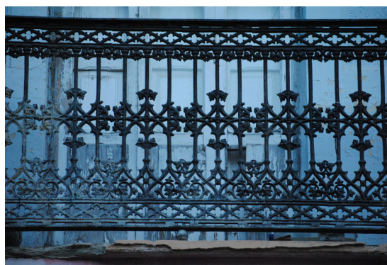
Calle Escaante 214 Barandilla de hierro fundido con tracerías de inspiración Gótica
