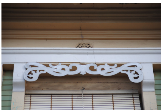
Calle del Progreso 180 Guardamalleta de perfil mixtilíneo de lámina de hierro perforada con fantasía simple
