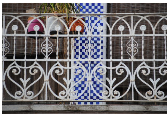
Calle Escalante 323 Barandilla de hierro forjado con fantasías florales
