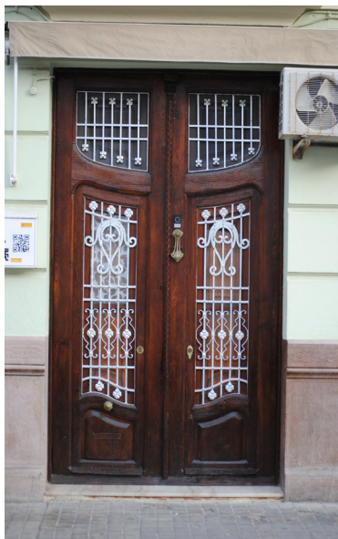
Calle Jose Benlure 214 Portón de dos hojas de madera con rejas centrales y superiores de perfil curvado con fantasías florales
