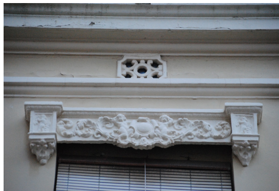
Calle Jose Benlure 203 Guardapolvo de perfil rectangular de piedra artificial con fantasías vegetales, puttos y escudo heráldico central
