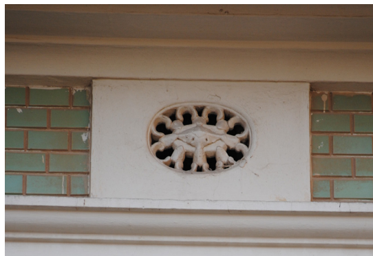
Calle del Progreso 227 Respiradero de perfil oval de piedra artificial con elementos curvilíneos
