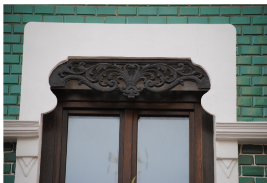
Calle del Progreso 259 Guardamalleta de perfil rectangular de hierro fundido con elementos vegetales de inspiración Barroca
