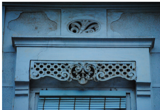
Calle de Escalante 214 Guardamalleta de perfil rectangular de hierro fundido con volutas, perforaciones y elementos de inspiración Barroca
