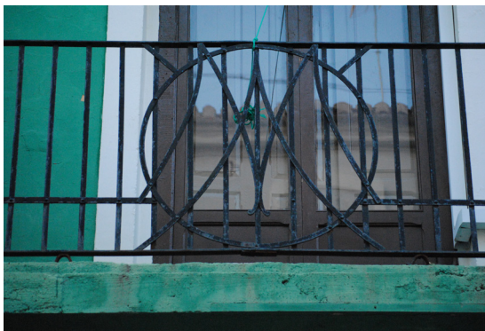
Calle Padre Luis Navarro 57 Barandilla de hierro forjado con elemento central simple
