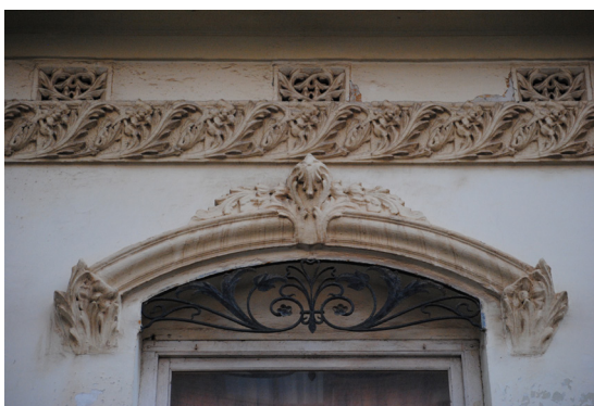
Calle Padre Luis Navarro 145 Guardamalleta de perfil curvado de hierro forjado con elementos florales y vegetales
