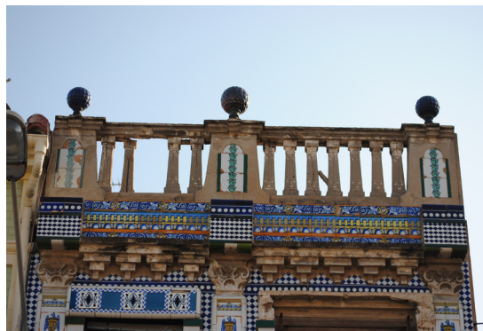
Calle de Escalante 262 Antepedecho de cemento con armadura, con piñas y azulejos de recubrimiento
