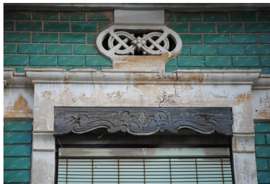
Calle del Progreso 196 Guardamalleta de perfil rectangular de madera labrada con elementos vegetales
