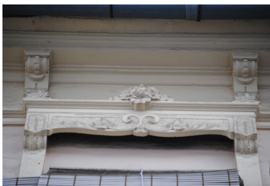
Calle Jose Benllure 106 Guardapolvo de perfil rectangular de piedra artificial con elementos vegetales y volutas
