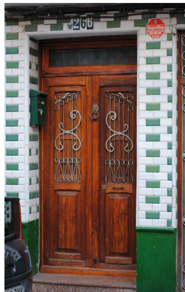
Calle Barraca 266 Portón de dos hojas de madera con rejas centrales y superiores con fantasía simple
