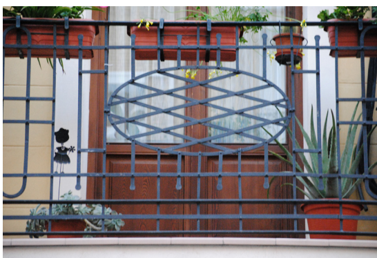
Calle Barraca 77 Barandilla de hierro forjado con motivo central con oval
