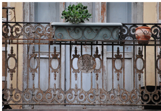
Calle de la Reina 115 Barandilla de hierro fundido con espirales y puttos de inspiración Barroca
