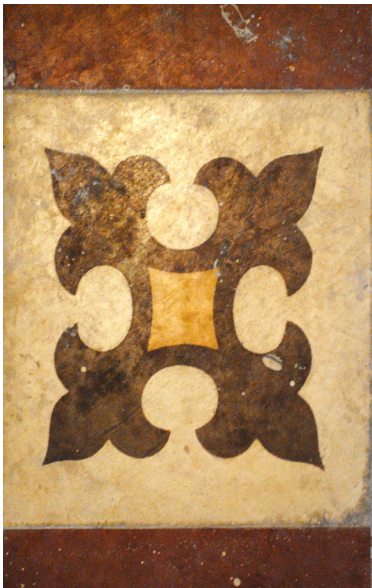
Calle del Progreso 200 Baldosa hidráulica de pavimentación en fantasía simple con elementos geométricos
