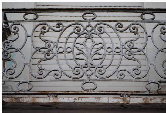
Calle del Progreso 78 Barandilla de hierro forjado con motivo central con fantasías florales
