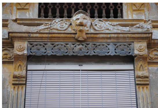
Calle de los Angeles 25 Guardamalleta de perfil rectangular de madera labrada y perforada con elementos vegetales
