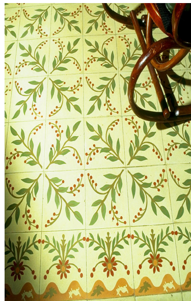
Calle Jose Benllure 246 Baldosa hidráulica de pavimentación en fantasía compleja con elementos florales, vegetales y animales
