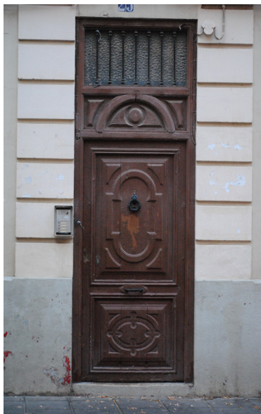
Calle Padre Luis Navarro 25 Puerta de madera con reja superior con fantasías simples
