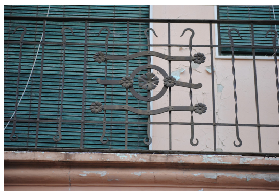
Calle Barraca 245 Barandilla de hierro forjado con motivo central con fantasías simples y flores
