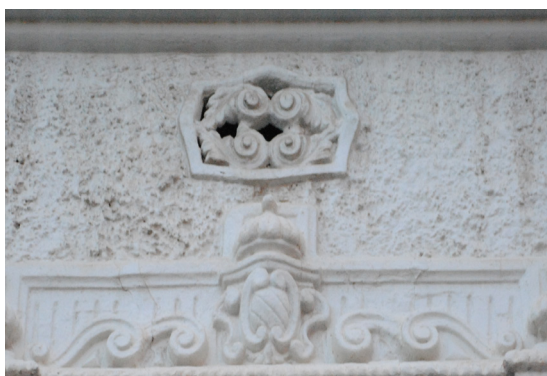
Calle Padre Luis Navarro 188 Respiradero de perfil mixtilíneo de piedra artificial con elementos vegetales y roleos
