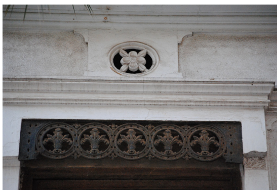
Calle Barraca 50 Guardamalleta de perfil rectangular de hierro fundido con elementos vegetales y círculos
