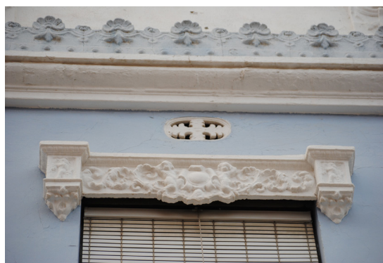
Calle del Progreso 65 Guardapolvo de perfil rectangular de piedra artificial con fantasías vegetales, puttos y escudo heráldico central
