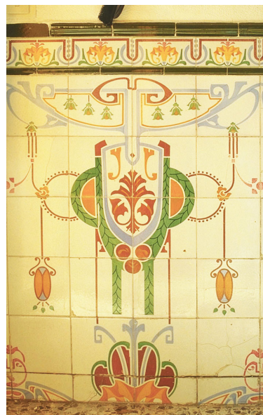
Calle Jose Benllure 323 Zócalo de azulejos de decorados por el sistema de trepas pintados policromáticamente en fantasía enlazada descendente con elementos florales y vegetales estilo Art Nouveau
