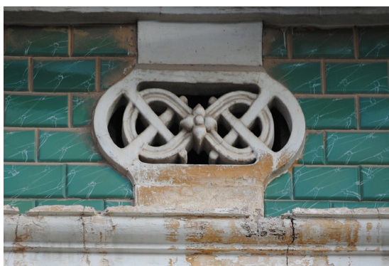
Calle del Progreso 196 Respiradero de perfil mixtilíneo de piedra artificial con elementos curvilíneos y flor central
