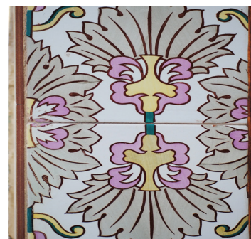
Calle del Progreso 226 Azulejo de mayólica plano decorado por el sistema de trepas con fantasía policroma con elementos vegetales
