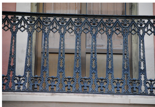
Calle de la Reina 128 Barandilla de hierro fundido con tracerías geométricas de Inspiración Art Decó
