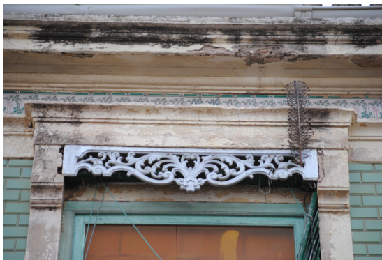
Calle Jose Benllure 131 Guardamalleta de perfil rectangular de hierro fundido con elementos vegetales de inspiración Barroca
