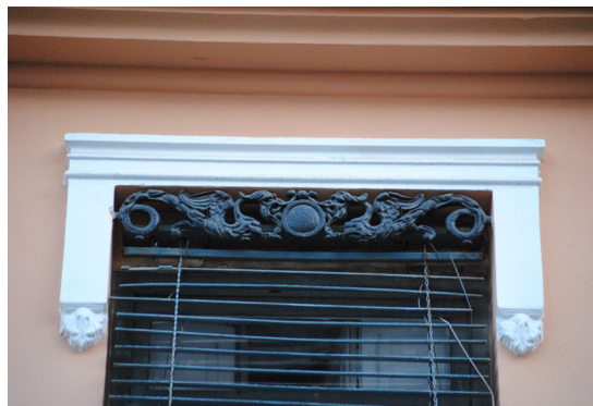
Calle barraca 64 Guardamalleta de perfil rectangular de hierro fundido con elementos zoomorfos
