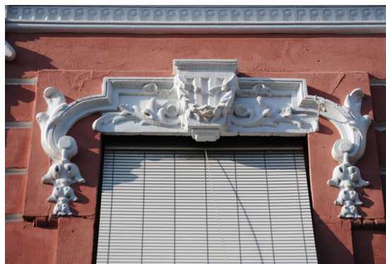
Calle del Rosario 81 Guardapolvo de perfil mixtilíneo de piedra artificial con elementos vegetales, florales, festones y guirlandas
