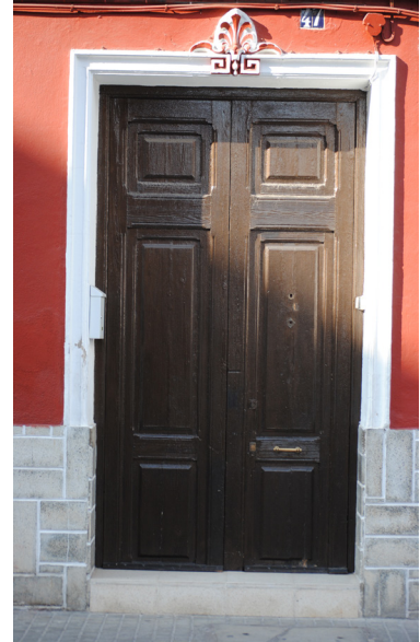
Calle del Arzobispo Company 47 Portón de dos hojas de madera
