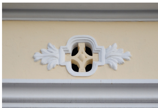
Calle Jose Benllure 216 Respiradero de perfil mixtilíneo de piedra artificial con tracería geométrica y elementos vegetales
