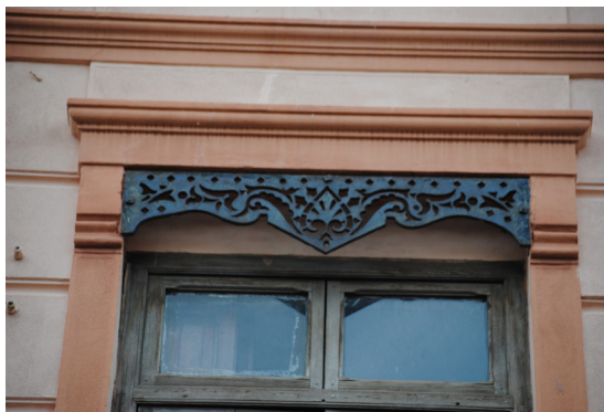
Calle del Progreso 159 Guardamalleta de perfil rectangular de lámina de hierro perforada con fantasía simple
