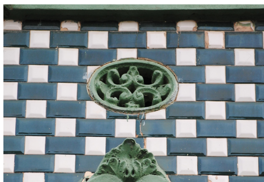
Calle del Progreso 232 Respiradero de perfil oval de piedra artificial con elementos vegetales
