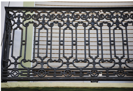
Calle José Benllure 20 Barandilla de hierro fundido con fantasías de inspiración Barroca
