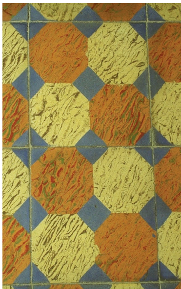
Calle Jose Benllure 214 Baldosa hidráulica de pavimentación en fantasía simple con elementos geométricos marmorizados
