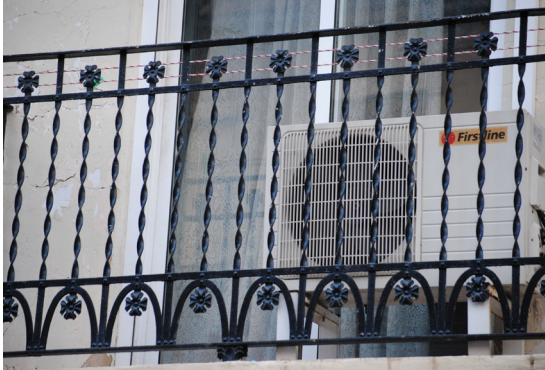
Calle Barraca 22 Barandilla de hierro forjado con fantasías florales
