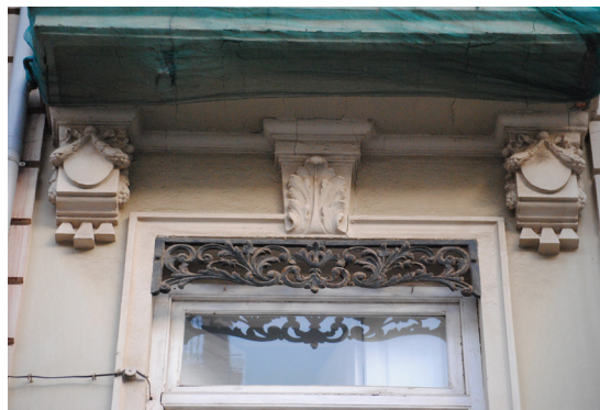
Calle Jose Benllure 189 Guardamalleta de perfil rectangular de hierro fundido con elementos florales y vegetales de inspiración Barroca
