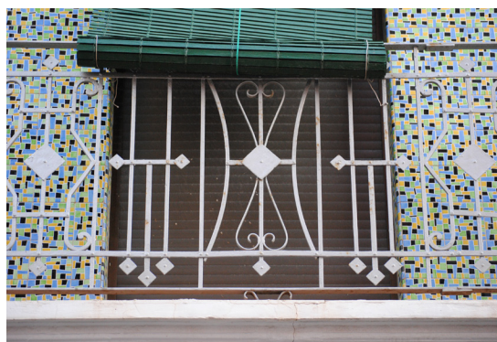
Calle Padre Luis Navarro 338 Barandilla de hierro forjado con fantasías geométricas de inspiración modernista
