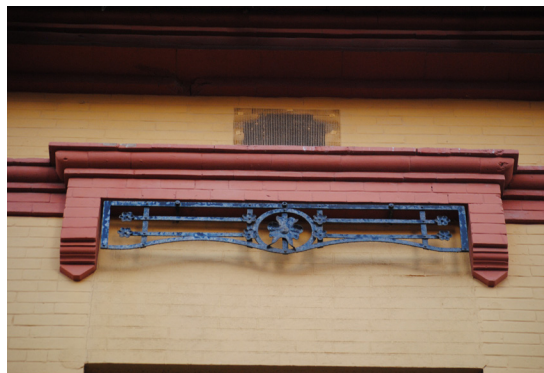
Calle Padre Luis Navarro 218 Guardamalleta de perfil mixtilíneo de hierro forjado con elementos florales
