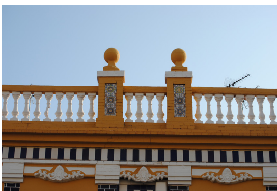
Calle de Escalante 274 Antepedecho de piedra artificial con globos
