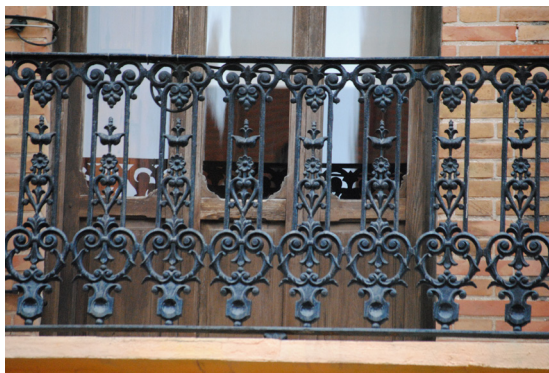
Calle de la Reina 105 Barandilla de hierro fundido con roleos y elementos florales de inspiración Barroca
