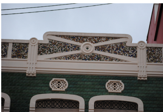
Calle de la Reina 150 Frontispicio de perfil curvado con aplicación cerámica y elementos geométricos
