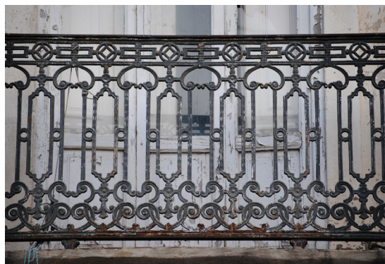
Calle Barraca 15 Barandilla de hierro fundido con fantasías de inspiración Barroca
