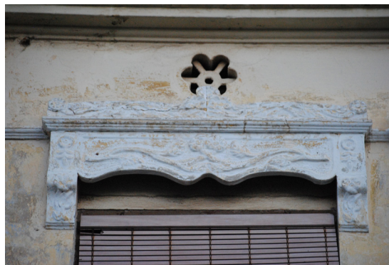
Calle Barraca 136 Guardapolvo de perfil rectangular de piedra artificial con elementos vegetales
