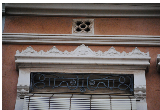
Calle del la Reina 111 Guardamalleta de perfil mixtilíneo de hierro forjado con elementos floreales
