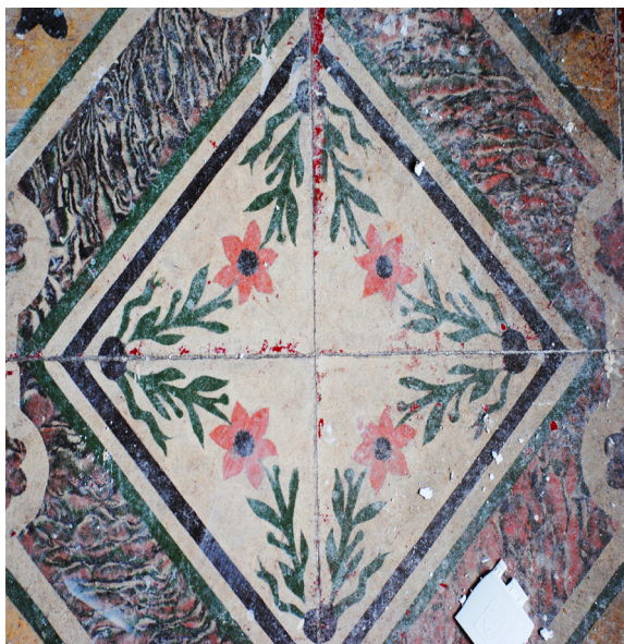
Calle del Progreso 200 Baldosa hidráulica de pavimentación en fantasía compleja con elementos geométricos marmorizados y elementos florales
