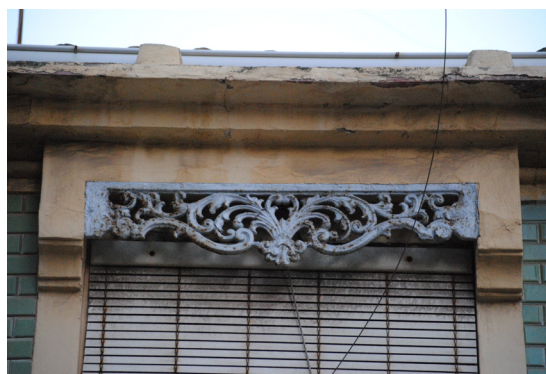
Calle Barraca 118 Guardamalleta de perfil rectangular de hierro fundido con elementos florales y vegetales de inspiración Barroca
