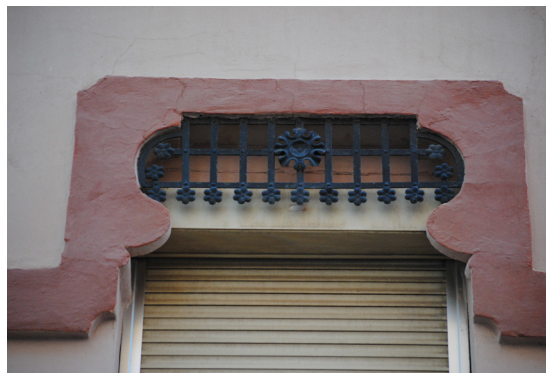
Calle Padre Luis Navarro 159 Guardamalleta de perfil mixtilíneo de hierro forjado con elementos florales
