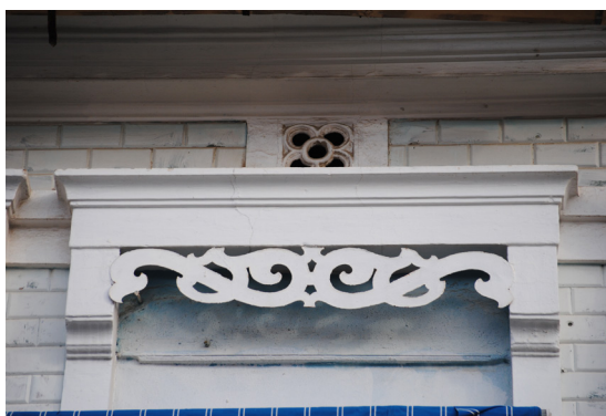
Calle del Progreso 186 Guardamalleta de perfil mixtilíneo de lámina de hierro perforada con roleos
