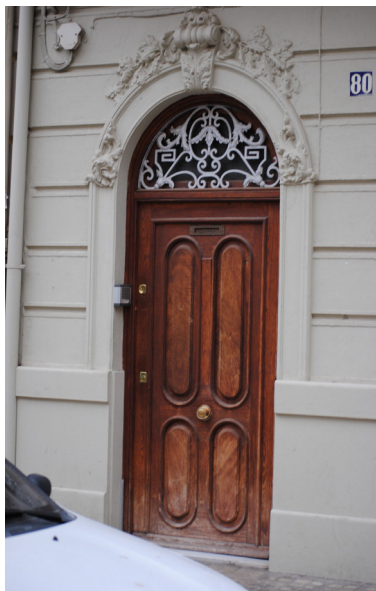
Calle de la Reina 80 Portón de una hoja de madera con rejas superiores con fantasía floral
