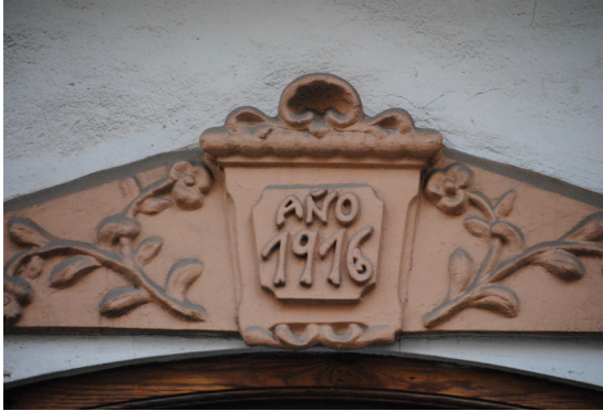
Calle Jose Benllure 66 Monogramas de fecha en piedra artificial posicionado en dovela superior a una puerta
