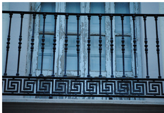
Calle Escalante 81 Barandilla de hierro fundido con grecas en banda inferior
