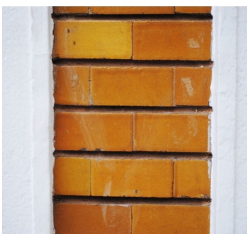
Calle de los Angeles 13 Azulejo de mayólica biselado esmal- tado monocromático amarillo
