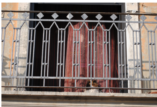
Calle de Escalante 205 Barandilla de hierro forjado con fantasías geométricas simples
