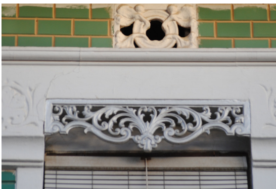
Calle Jose Benllure 246 Guardamalleta de perfil rectangular de hierro fundido con elementos vegetales de inspiración Barroca
