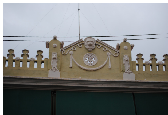
Calle de la Reina 194 Frontispicio de perfil mixtilíneo con óculo central, guirnalda, cabeza de león y elementos geométricos
