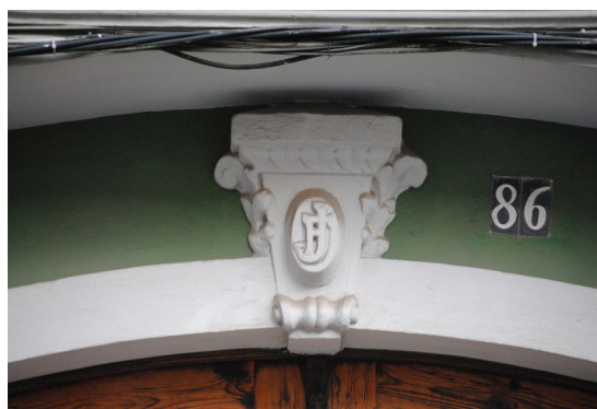
Calle Jose Benllure 86 Monogramas de fecha en piedra artificial posicionado en dovela superior a una puerta
