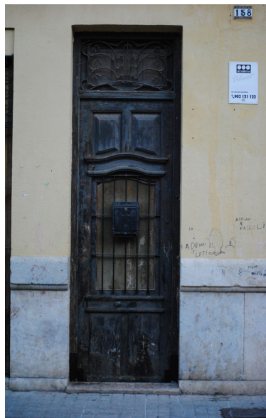
Calle Barraca 158 Puerta de madera con reja central de perfil curvado y reja superior con fantasías simples
