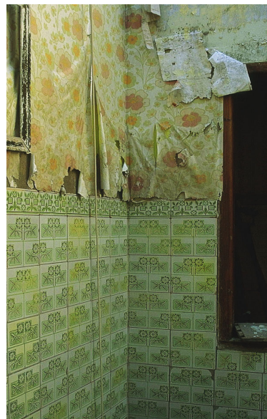
Calle Padre Luis Navarro 389 Zócalo de azulejos de mayólica decorados por el sistema de trepas en fantasía simple con elementos florales y vegetales
