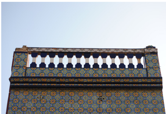
Calle de Escalante 250 Antepedecho de piedra artificial con recubrimiento cerámico
