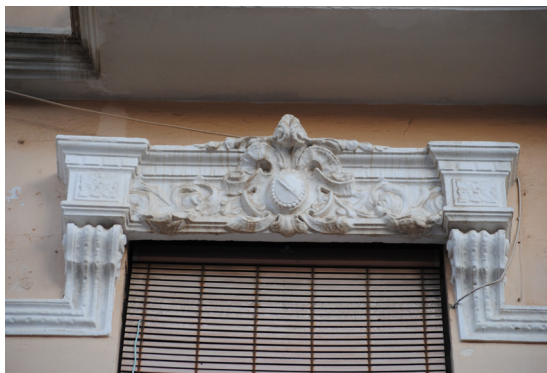
Calle Jose Benllure 239 Guardapolvo de perfil rectangular de piedra artificial con elementos vegetales y escudo heráldico central
