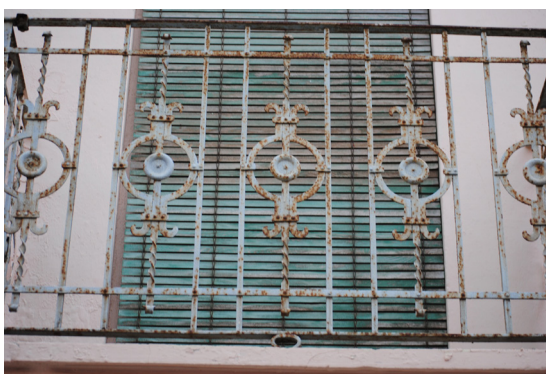
Calle Barraca 231 Barandilla de hierro forjado con fantasía simple
