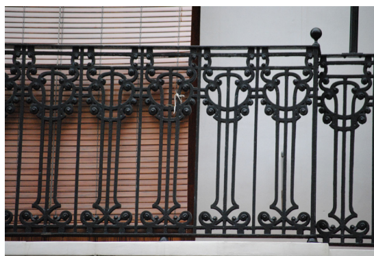
Calle de la Reina 64 Barandilla de hierro fundido con fantasías estilo Art Nouveau
