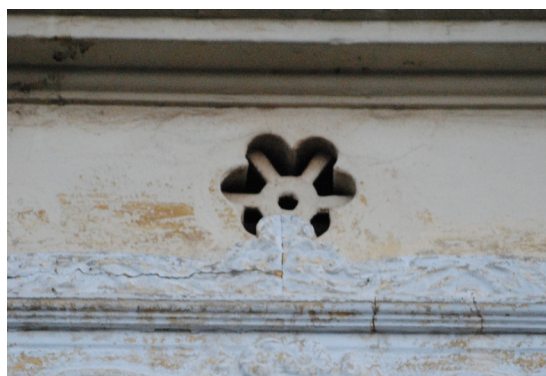
Calle Barraca 136 Respiradero de perfil a flor de piedra artificial con elementos simples
