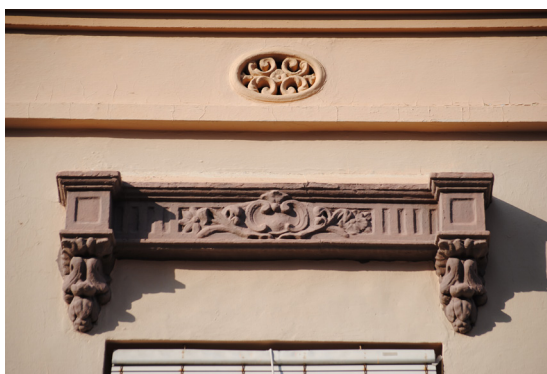
Calle de Escalante 287 Guardapolvo de perfil rectangular de piedra artificial con elementos vegetales y escudo heráldico central
