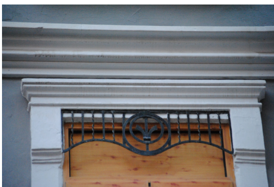
Calle Barraca 63 Guardamalleta de perfil rectangular de hierro forjado con elementos florales y geometricos
