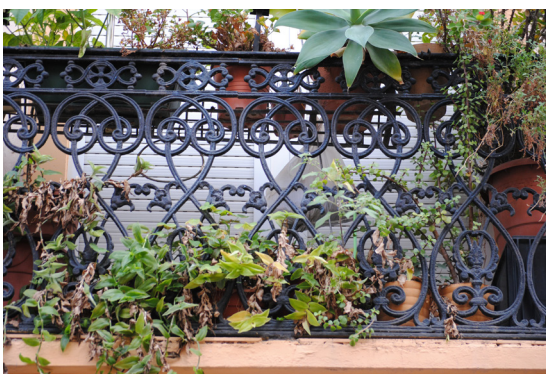
Calle del Progreso 54 Barandilla de hierro fundido con elementos vegetales y roleos de inspiración Barroca
