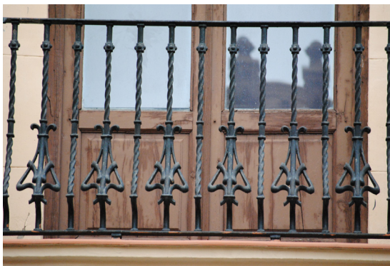
Calle de la Reina 117 Barandilla de hierro fundido con fantasía alternada estilo Art Nouveau
