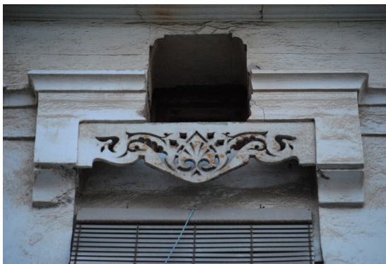
Calle Padre Luis Navarro 51 Guardamalleta de perfil rectangular de lámina de hierro perforada con fantasía simple
