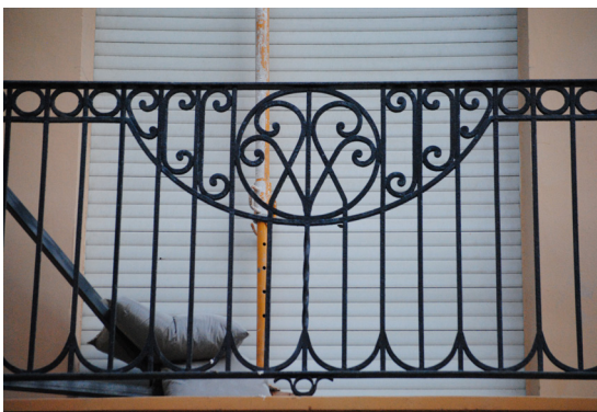
Calle Barraca 119 Barandilla de hierro forjado con motivo central con fantasías simples
