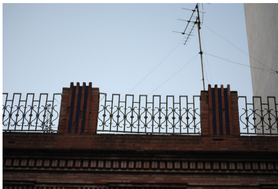
Calle Barraca 125 Antepedecho de hierro forjado separado por elementos rectangulares de ladrillos a vista
