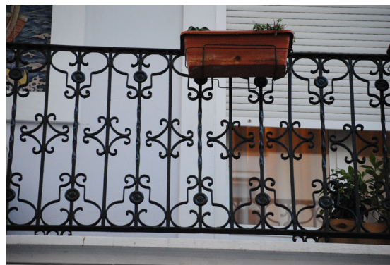
Calle de la Iglesia del Rosario 4 Barandilla de hierro forjado con fantasías simples
