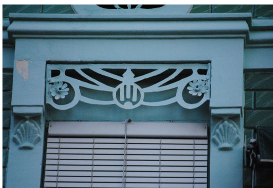
Calle Barraca 141 Guardamalleta de perfil rectangular de lámina de hierro perforada con elementos florales y fantasías estilo Art Nouveau
