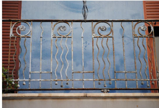
Calle Barraca 218 Barandilla de hierro forjado con flores, espirales, de inspiración Art Decó
