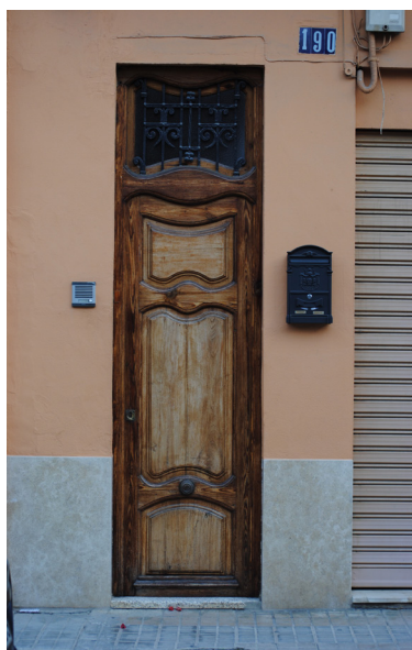
Calle Barraca 190 Puerta de madera con reja superior de perfil mixtilíneo con fantasías florales
