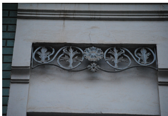
Calle de la Reina 223 Guardamalleta de perfil mixtilíneo de hierro forjado con elementos floreales
