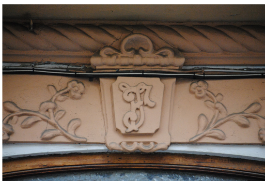
Calle José Benllure 66 Monogramas de letra en piedra artificial posicionado en dovela superior a una puerta
