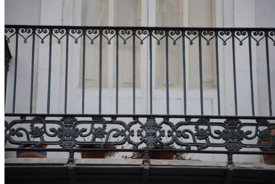
Calle Barraca 45 Barandilla de hierro fundido con fantasías florales en banda inferior de inspiración Barroca
