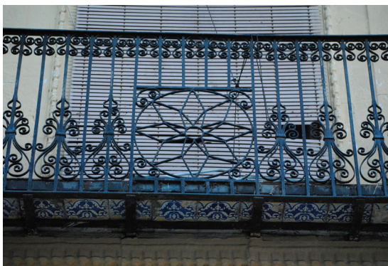
Calle Escalante 188 Barandilla de hierro forjado con espirales y motivo central
