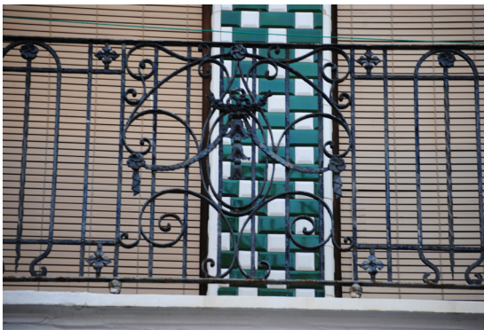
Calle José Benllure 317 Barandilla de hierro forjado con motivo central con fantasías florales
