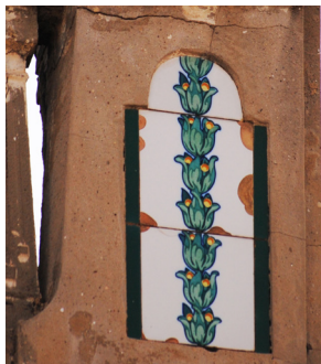
Calle de Escalante 262 Azulejo de mayólica plano decorado por el sistema de trepas con fantasía policroma con elementos vegetales
