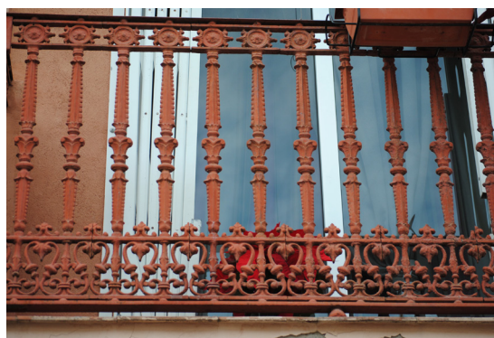
Calle del Progreso 29 Barandilla de hierro fundido con fantasías florales y elementos de inspiración Barroca
