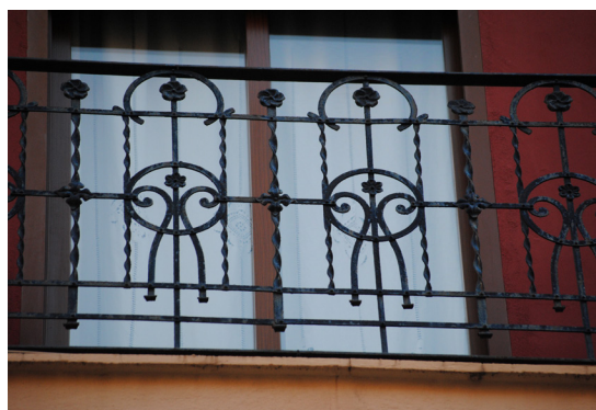
Calle Barraca 9 Barandilla de hierro forjado con fantasías florales
