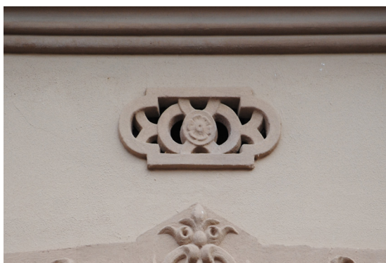
Calle del Progreso 178 Respiradero de perfil mixtilíneo de piedra artificial con elementos curvilíneos y flor central
