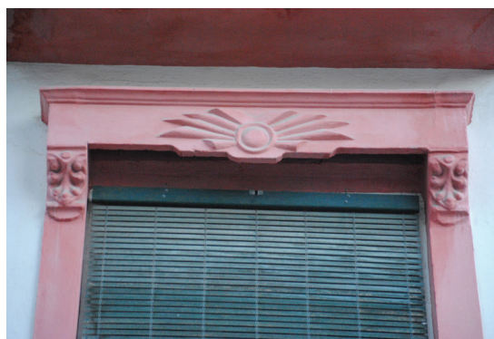
Calle de Escalante 162 Guardapolvo de perfil rectangular de piedra artificial con elemento geométrico central
