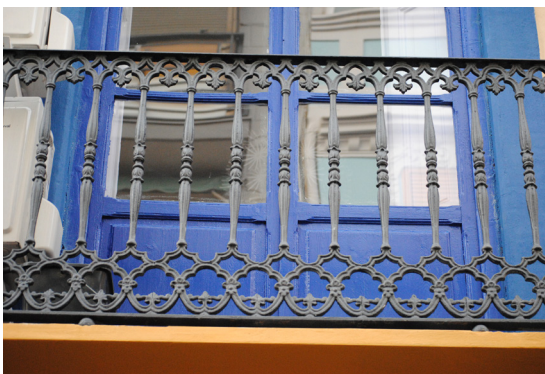
Calle José Benllure 117 Barandilla de hierro fundido con tracerías de inspiración Mudéjar
