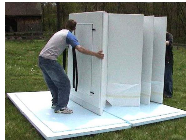
Ilustración 44: Ensamblaje de los refugios temporales de emergencia.
