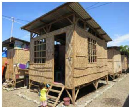
Ilustración 21. Refugio transicional para la situación de desastre en Filipinas 2011
