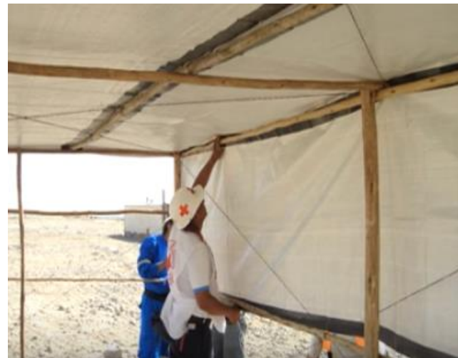
Ilustración 29: miembros del IFRC en revisión de las estructuras construidas.
