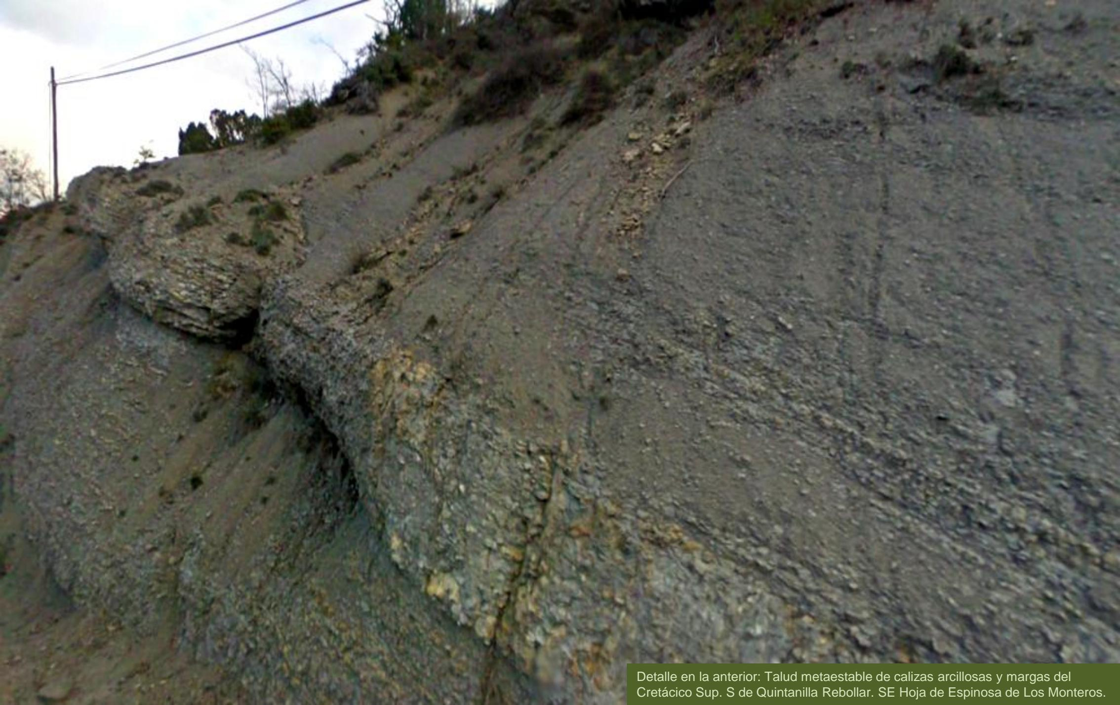
Detalle en la anterior: Talud metaestable de calizas arcillosas y margas del Cretácico Sup. S de Quintanilla Rebollar. SE Hoja de Espinosa de Los Monteros.
