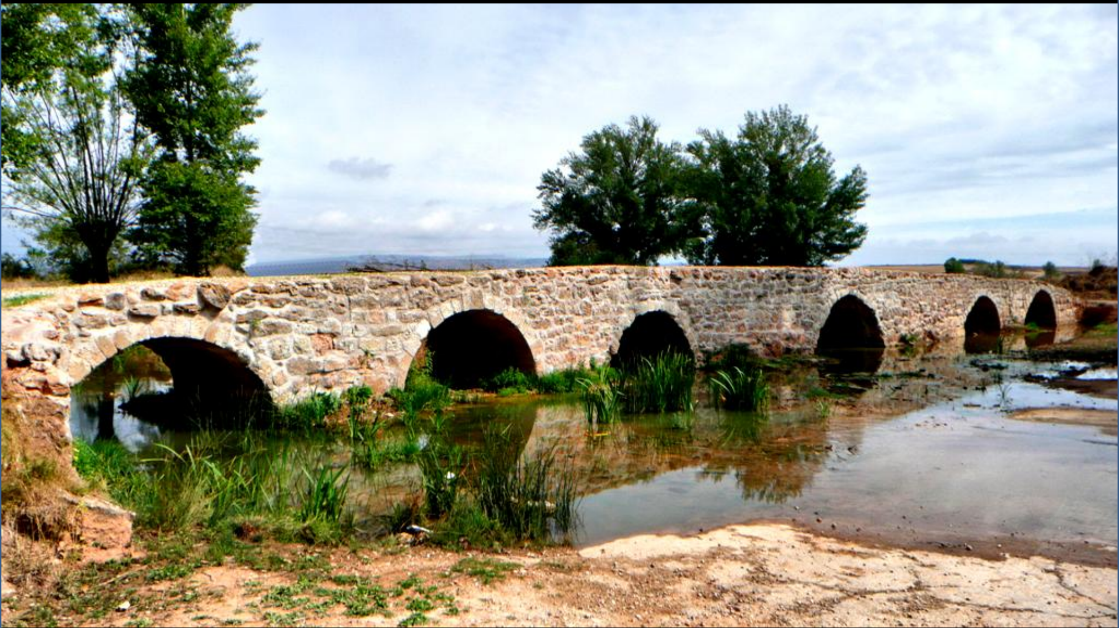
Puente romano en Río Odra, Sandoval de La Reina, Burgos. Centro W Hoja de Villadiego. (por Fernando R-Google)
