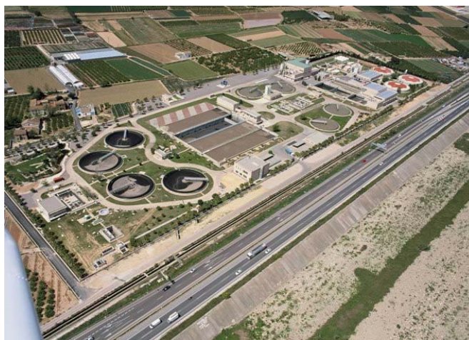
Figura 3.1. Vista aérea de la EDAR QB.
