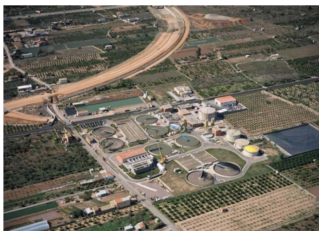
Figura 3.4. Vista aérea de la EDAR CT.
