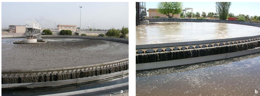
Figura 1.10. Problemas de separación del fango activo. (a) Foaming o espumación. (b) Bulking o hinchazón de fangos. Autor: Andrés Zornoza.
