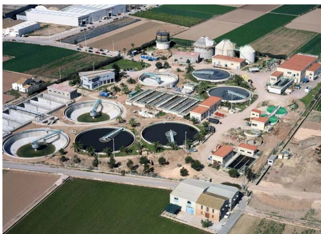
Figura 3.2. Vista aérea EDAR CX.
