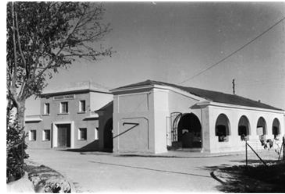
Fig. 1: Año 1955, estado final de las obras. F. Oliva Història Fotogràfica.
