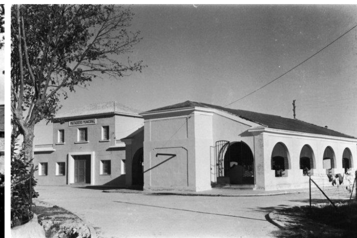
Figs. De Izq. a Der. : F1: Matadero Municipal en fase de obras F2: Matadero Municipal en fase de obras, año 1954. F3: Matadero Municipal con el acceso terminado, año 1962. Fuente: Oliva Historia Fotográfica.
