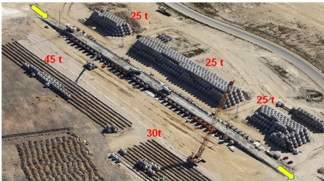
Figura 12. Vista aérea del parque de cubípodos del dique Oeste (29/05/2015). Fuente: UTE dique Oeste.
