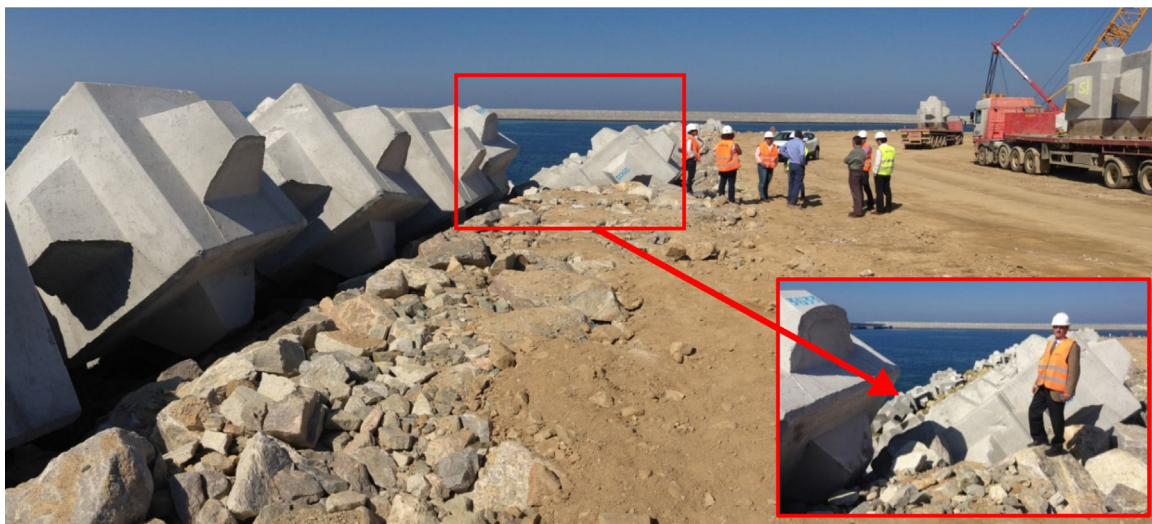
Figura 13. Vista de la transición monocapa-bicapa de cubípodos de 25 t (1/10/2015). Fuente: elaboración propia.
