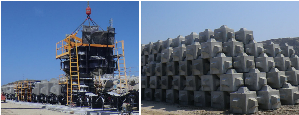
Figura 5. Línea de producción de cubípodos de 45 t y acopio a 5 alturas (29/05/2015). Fuente: elaboración propia.
