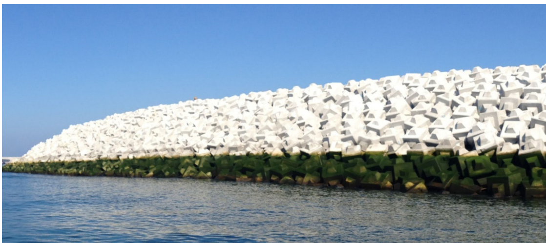
Figura 14. Aspecto exterior del dique Oeste en construcción (1/10/2015). Fuente: elaboración propia.
