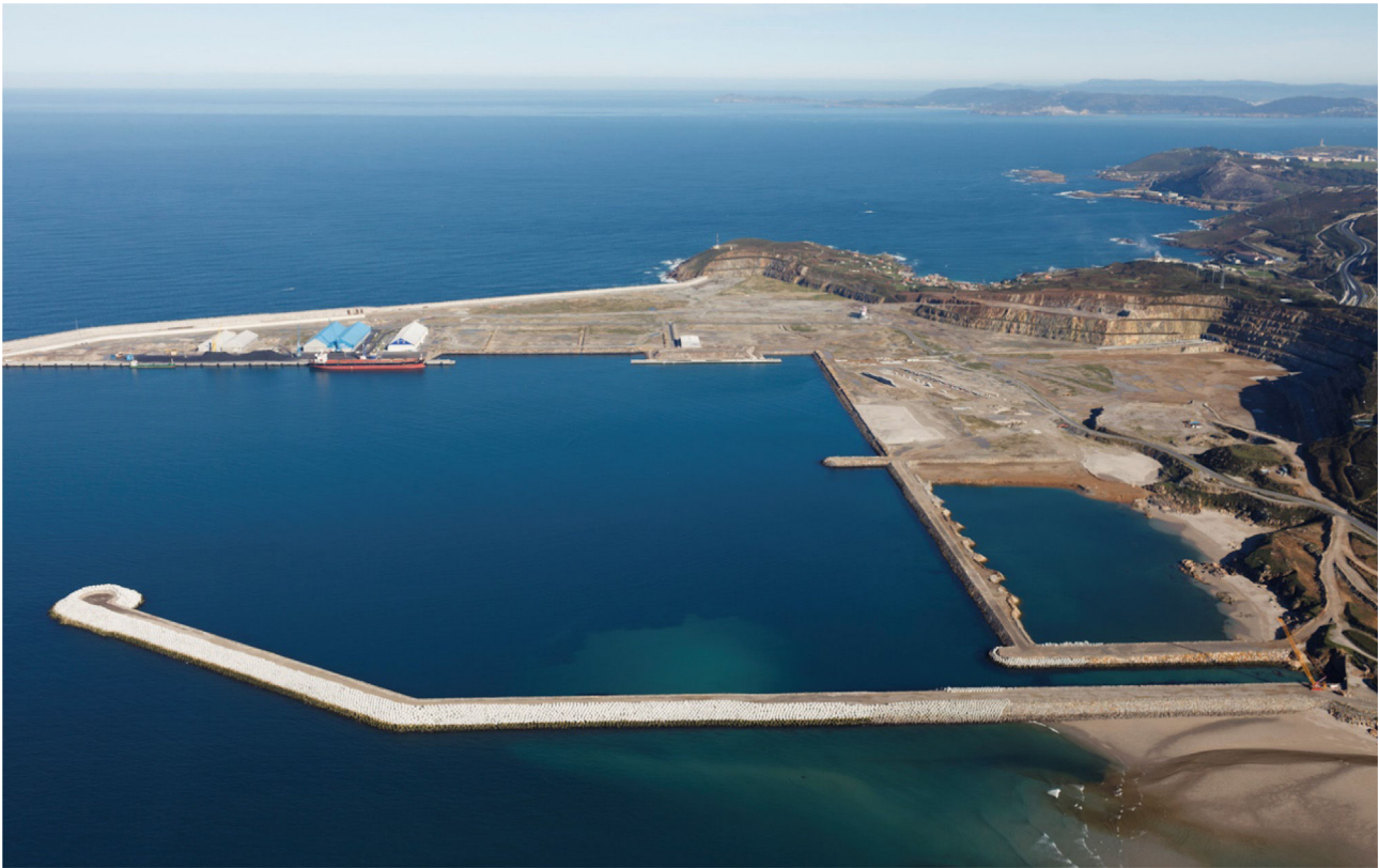
Figura 15. Vista aérea de del dique Oeste (15/01/2016). Fuente: UTE dique Oeste.
