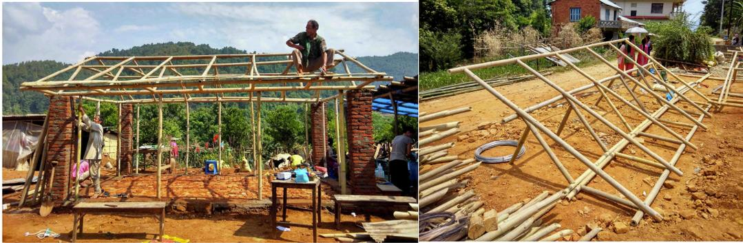
Imagen 31. Rootstudio. Su prototipo de viviendas para Nepal. Mediante una propuesta de seriación se pretende resolver la vivienda emergente en Nepal. La fácil manipulación del material permite que mediante mano de obra local y con herramientas muy sencillas se logre resolver obras de calidad en poco tiempo y con pocos recursos. <sup>27</sup>
