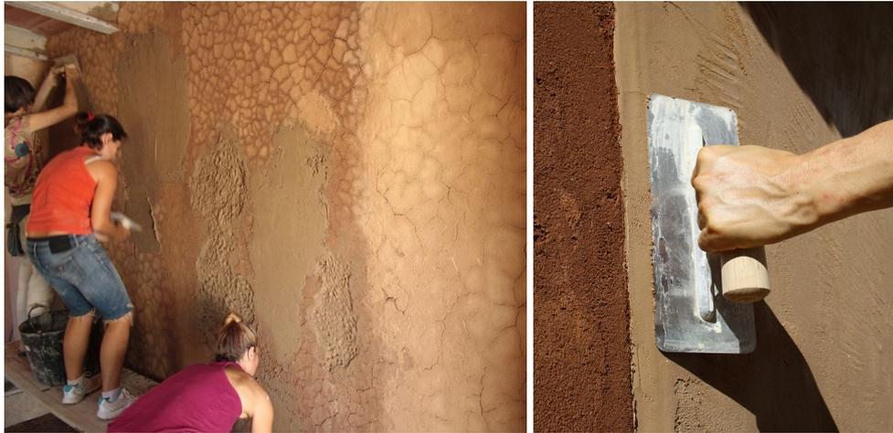
Imagen 18. Revestimiento. Enlucido fino de arcilla. (Fuente: Taller y voluntariado de construcción con tierra. <http://www.okambuva.coop/>)
