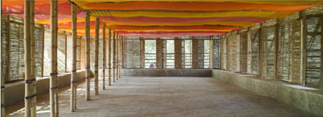
Imagen 17. Planta Alta. Aula Norte. Se puede observar la amplitud de esta planta y la dotación de la ventilación cruzada. (Fuente: [www.annaheringer.com](http://www.annaheringer.com))
