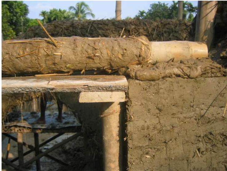
Imagen 30. Proceso de ejecución. Conformación de dinteles. (Fuente: <http://www.panoramio.com/user/6837189/tags/Dinajpur>)
