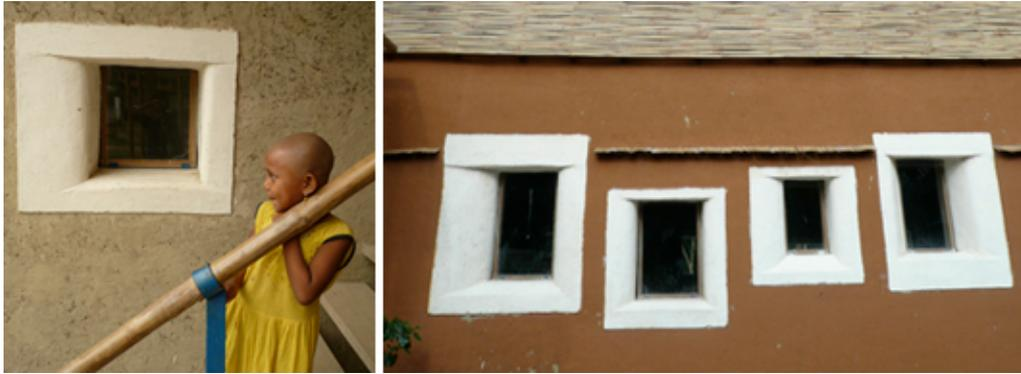
Imagen 83. Enlucido de cal que enmarca las ventanas y aleros. (Fuente: [www.annaheringer.com](http://www.annaheringer.com)) Este tipo de enlucidos contienen tierra de calidad arcillosa, con arena fina y mejorada con cal.
