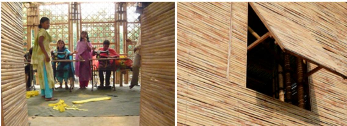
Imagen 70. Paramentos verticales y ventanas batientes hechos de bambú y con carpintería de madera. Estas ventanas batientes permiten ventilar el espacio interior. (Fuente: [www.annaheringer.com](http://www.annaheringer.com))
