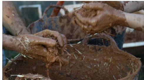
Imagen 4. Trabajo en tierra. Método Cob. (Fuente: taller de bio construcción Okambuva, Valencia, España).
