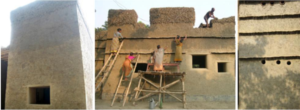
Imagen 80. Conformación de los muros de tierra. (Fuente: [www.annaheringer.com](http://www.annaheringer.com))
