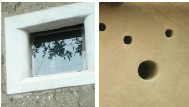
Imagen 102. Detalles de elementos construidos con tierra. La paja mezclada con la tierra ayuda a aumentar la cohesión del material y su fuerza. (Fuente: [www.annaheringer.com](http://www.annaheringer.com))
