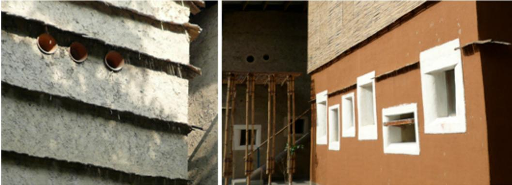
Imagen 82. Enlucido de cal que enmarca las ventanas y aleros. (Fuente: [www.annaheringer.com](http://www.annaheringer.com)). Este tipo de enlucidos contienen tierra de calidad arcillosa, con arena fina y mejorada con cal.
