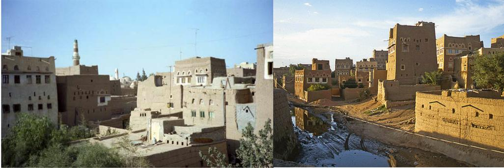
Imagen 8. Ciudad de Sadah en Yemen. Construcciones hechas en la técnica del zabur. En Yemen ha sido una técnica altamente difundida; en donde se logró hacer edificaciones de varias plantas y templos de gran tamaño. (Minke, Gernot)
