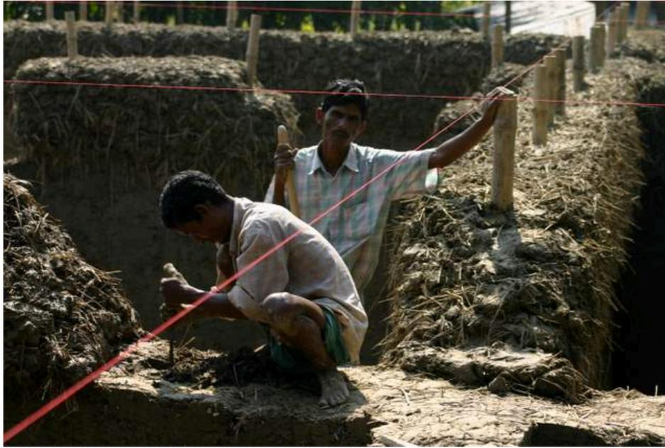
Imagen 31. Proceso de ejecución. Elementos de bambú que rigidizan de los muros de Cob. (Fuente: <http://www.panoramio.com/user/6837189/tags/Dinajpur>)
