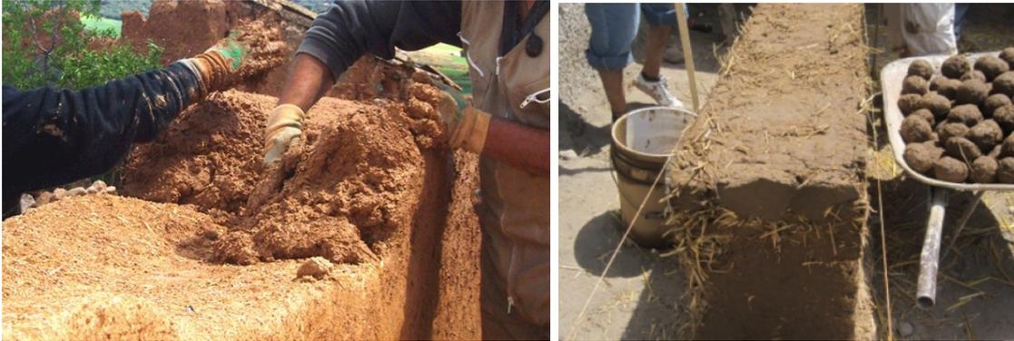
Imagen 3. Conformación de mampostería mediante el sistema del Cob.
