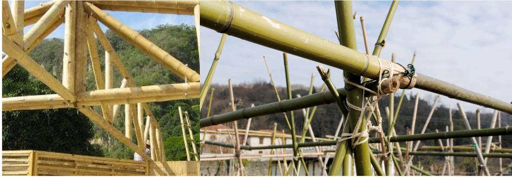
Imagen 36. En las imágenes podemos observar las opciones de ensamblado del bambú. La primera más rigurosa en cuanto a la ejecución y la otra de manera más improvisada mediante el uso de cuerdas.
