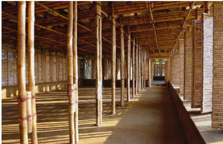
Imagen 45. Suelo realizado de tierra. Se ha utilizado este material para la Planta Alta y para la Planta baja. (Fuente: [www.annaheringer.com](http://www.annaheringer.com))
