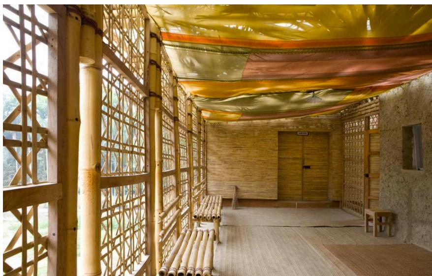
Imagen 71. Entramado de bambú que conforma la fachada este y demás elementos realizados de bambú. (Fuente: <http://sp.archello.com/en/project/desipshikha-electrical-skill-improvement>)
