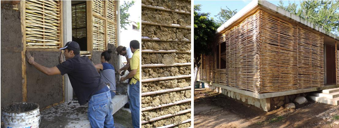
Imagen 6. Proceso constructivo para realizar la mampostería de bahareque, acercamiento a una pared de bareque en la que se puede observar el armado interno hecho de bambú y edificio que ejemplifica la utilización del bahareque en la utilización de arquitectura contemporánea.
