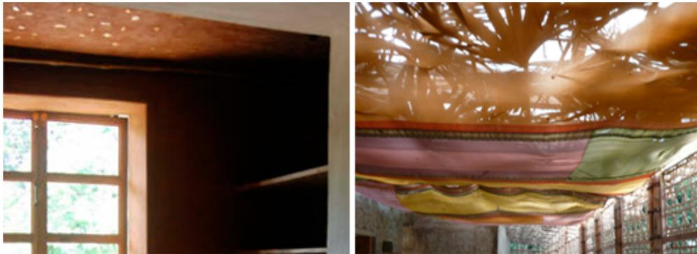
Imagen 56. Materiales ligeros y coloridos que componen el espacio. Como se puede observar el techo es muy ligero conformado con hojas de palmera, permitiendo que el espacio esté más relacionado con el exterior y dotándole también de frescor pues el sol no incide directamente sino se tamiza a través de estas dos capas y el aire fluye, hojas-tela. (Fuente: [www.annaheringer.com](http://www.annaheringer.com))
