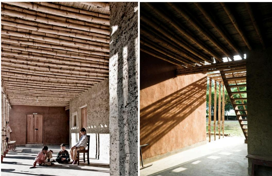
Imagen 73. Se puede observar el ordenado armado del entrepiso mediante la posición de viguetas de bambú. (Fuente: [www.arcvision.org/?p=20514&lang=en](http://www.arcvision.org/?p=20514&lang=en))
