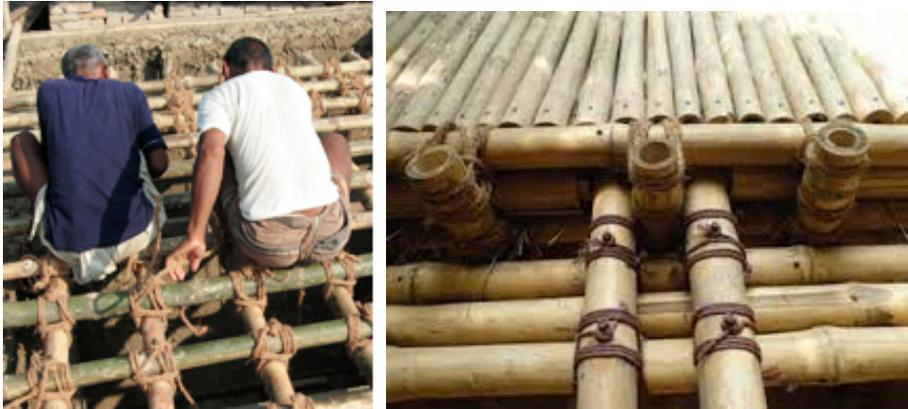
Imagen 104. Se prescindió de alambre para sujetar el cruce de las cañas, en lugar de eso se utilizaron cuerdas con el fin de conformar el entramado para armar el entrepiso. (Fuente: [www.annaheringer.com](http://www.annaheringer.com)).
