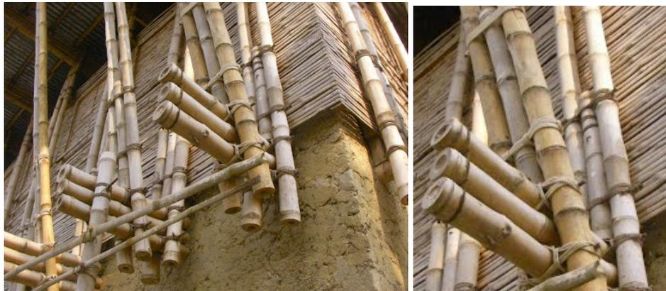
Imagen 29. Proceso de ejecución. Viga compuesta. (Fuente: <http://www.panoramio.com/user/6837189/tags/Dinajpur>)
