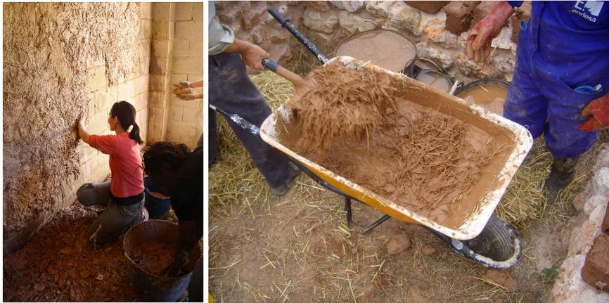
Imagen 17. Colocación y mezcla de revestimiento hecho de tierra y paja. (Fuente: Taller y voluntariado de construcción con tierra. <http://www.okambuva.coop/>)
