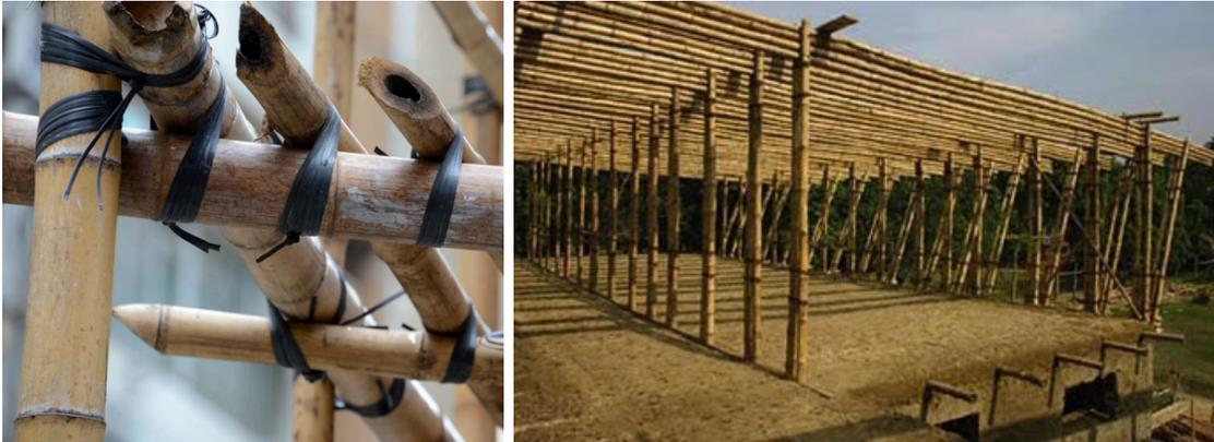
Imagen 30. Armado estructural de bambú para un andamio y para una edificación. En China y Camboya se ha conseguido levantar andamios de más de 6 pisos de altura.
