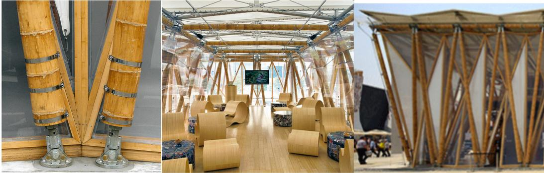
Imagen 33. La obra de Markus Heinsdorff explora las capacidades constructivas y de detalles que tiene el material en obras de arquitectura. Algunas de sus muestras se las puede encontrar en sus Pabellones.<sup>29</sup>
