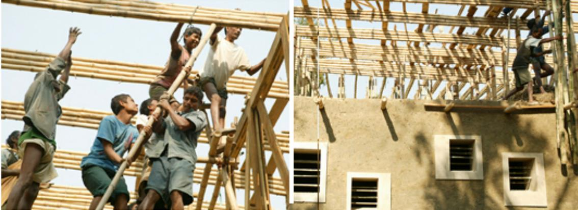
Imagen 27. Las vigas compuestas de bambú fueron prefabricadas y después se colocaron en la segunda planta. Cabe resaltar que la utilización del bambú se ha dado también en proceso de ejecución de la obra como por ejemplo en los andamios y puntales.
