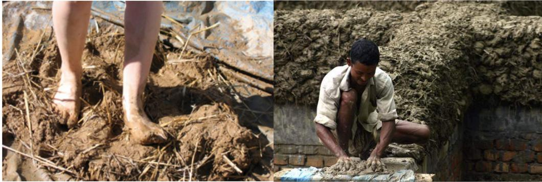
Imagen 13. Conformación de mampostería hecha con el método COB. Se puede observar a la gente compactando el material para lograr conformar los elementos constructivos.
