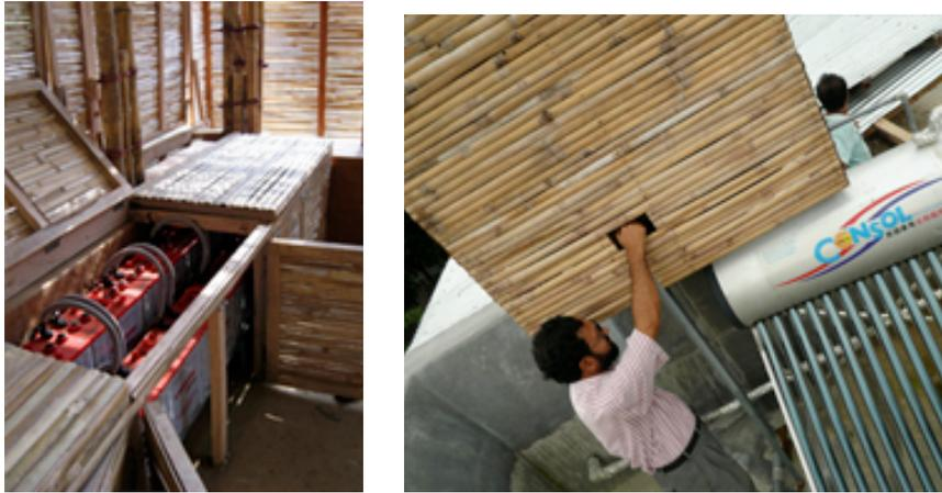
Imagen 108. Instalación de paneles solares y caldera.
