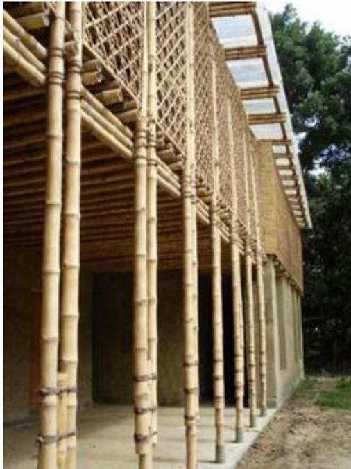
Imagen 67. Columnas compuestas en el hall este, entrepiso y entramado de bambú que da hacia la fachada en planta alta. Se puede observar el basamento de las columnas compuestas esta hecho de un tubo metálico con el fin de evitar el contacto directo de la caña con el agua. (Fuente: 84.38.224.208/sites/default/files/imagecache/header\_detail\_large/story/media/06\_97.jpg)
