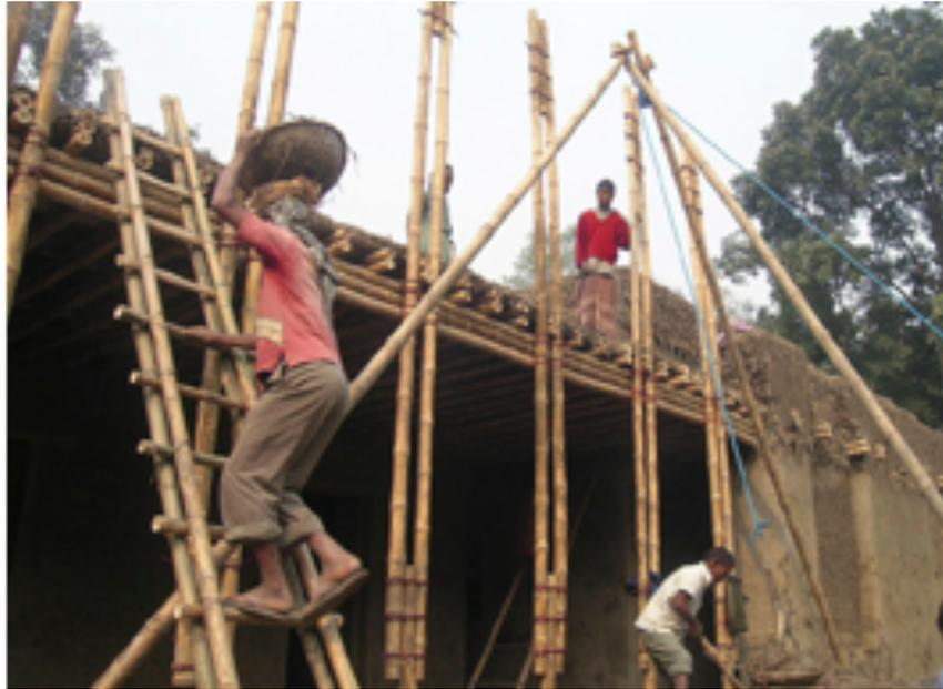
Imagen 78. Construcción de la planta alta. Se puede observar el entrepiso ya preparado y listo para recibir el Cob para los muros.
