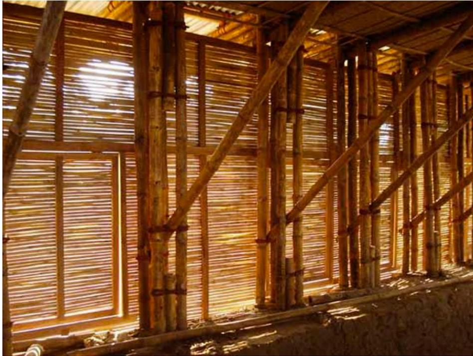
Imagen 69. Aula planta alta. La permeabilidad del espacio gracias a los paramentos que permiten que el paso del aire sea constante manteniendo fresco el ambiente. Muy útil en lugares con mucha humedad. (Fuente: <http://sp.archello.com/en/project/desi-dipshikha-electrical-skill-improvement>)
