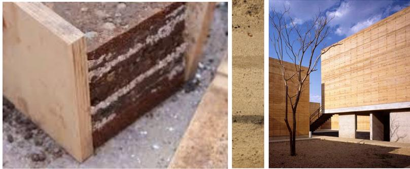
Imagen 5. Detalle de confinamiento con encofrados para realizar el tapial, textura de un muro de tapial con sus vetas que delatan la compactación en el proceso constructivo y edificio que ejemplifica las posibilidades constructivas-morfológicas del material.
