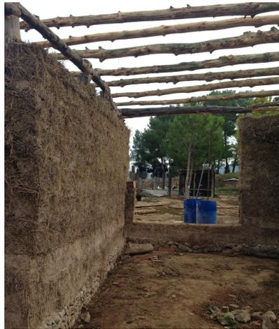
Imagen 3. Pruebas de adherencia con Cob sobre distintas superficies, previo a revocar las paredes. (Fuente: fotografía propia).
