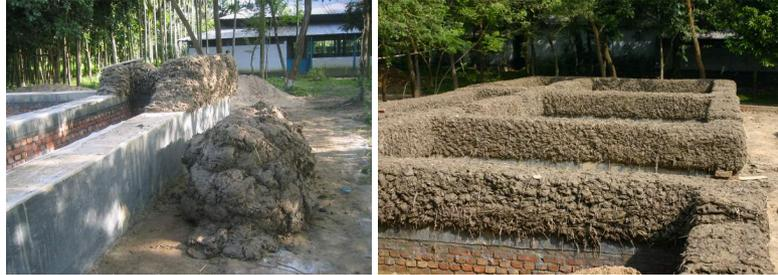
Imagen 37. Colocación del Cob sobre la cimentación de hormigón. Proceso de conformación de los elementos de mampuesto. (Fuente: <http://www.panoramio.com/user/6837189/tags/Dinajpur>)
