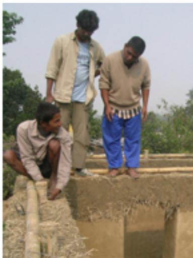
Imagen 103. Mejoramiento de técnica constructiva, al emplear bambú como armazón de los muros de cob.
