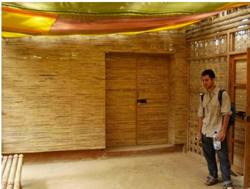
Imagen 72. Elementos de cierre realizados de bambú. (Fuente: <http://sp.archello.com/en/project/desi-dipshikha-electrical-skill-improvement>)
