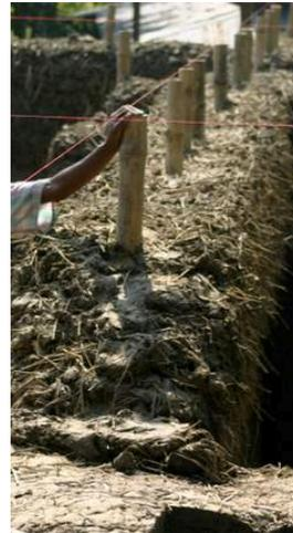
Imagen 15. Conformación de muros. Rigidización con cañas o elementos verticales. (Fuente: manual de construcción con tierra de Gernot Minke).
