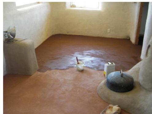
Imagen 22. Terminación de arcilla sobre suelo hecho de tierra. Suelo en la obra de Martin Rouch (Fuente: <http://www.panyaden.ac.th/construction-blog/tag/balance/>)
