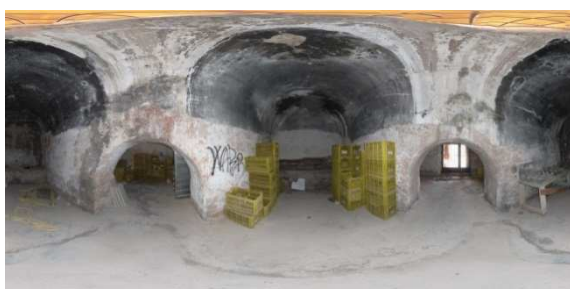
Figura 41. Esfera interior del aljibe
