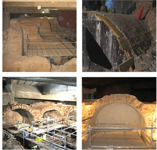
Figura 142. Reconstrucción bóveda (2010) Autor Lourdes Boix
