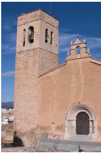
Figura 119. 114 Torre Campanario Estado actual. (2014) Foto del autor
