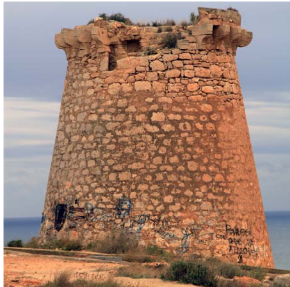
Figura 109. Torre Escaletes (Fotografía de Mayor, 2013)
