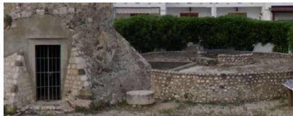
Figura 28. Restos de la instalación de abastecimiento de agua anexa a la torre (Fotografía de Mayor, 2013)
