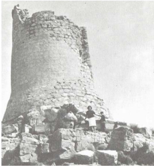
Figura 98. Torre de l'Aigua Amarga. Fotografía antigua (Imagen tomada de Seijo, 1978)
