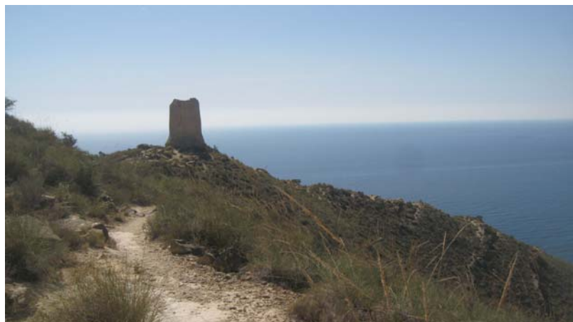
Figura 237. Tramo final de la senda de acceso a la Torre del Riu d'Aigües (Fotografía de Mayor, 2013)
