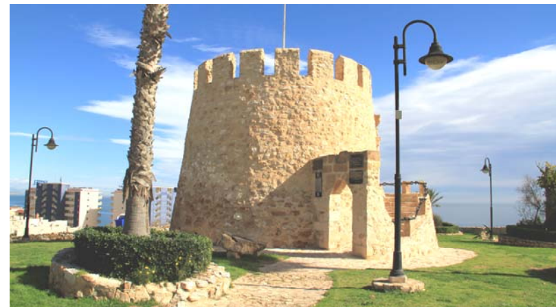
Figura 12. Torre del Cap Cerver. Estado actual (Fotografía de Mayor, 2013)
