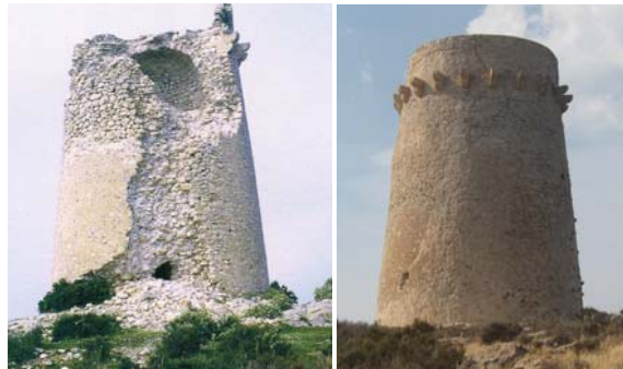
Figuras 51 y 52. Izquierda: Torre del Cap de Moraira antes de su restauración (Imagen tomada de Boira, 2007); derecha: estado actual (Fotografía de Mayor, 2013)
