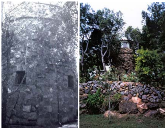
Figuras 60 y 61. Izquierda: Torre de la Galera antes de su restauración (Imagen tomada de Seijo, 1978); derecha: estado actual (Ficha BIC's. Consellería de Cultura)
