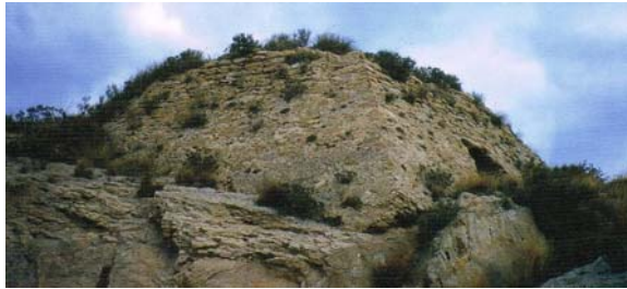
Figura 67. Torre de la Bombarda antes de su restauración (Imagen tomada de Boira, 2007)
