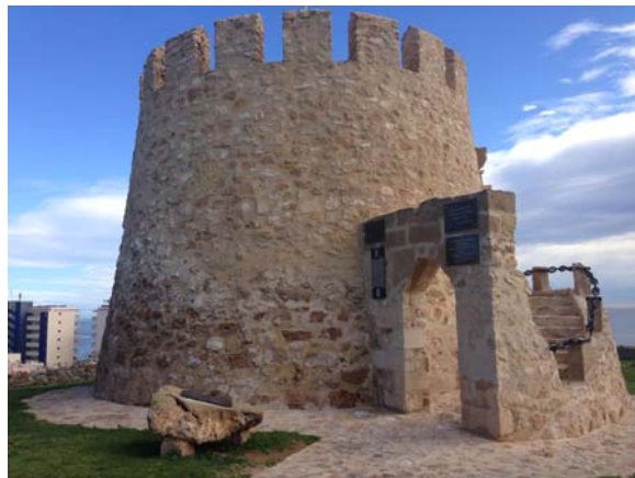
Figura 122. Torre del Cap Cerver después de su restauración (Fotografía de Mayor, 2013)
