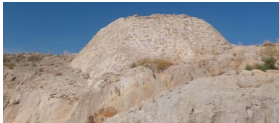
Figura 68. Torre de la Bombarda después de su restauración (Fotografía de Mayor, 2013)
