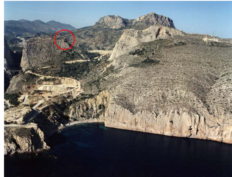
Figura 148. Torre del Mascarat (Fotografía de la Dirección General de Costas, Ministerio de Medio Ambiente)
