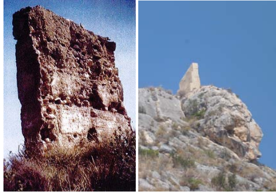
Figuras 55 y 56. Izquierda: Torre del Mascarat antes de su restauración (Catálogo de elementos, edificios y conjuntos de interés histórico-artístico, Ayuntamiento de Calp); derecha: estado actual (Fotografía de Mayor, 2013)
