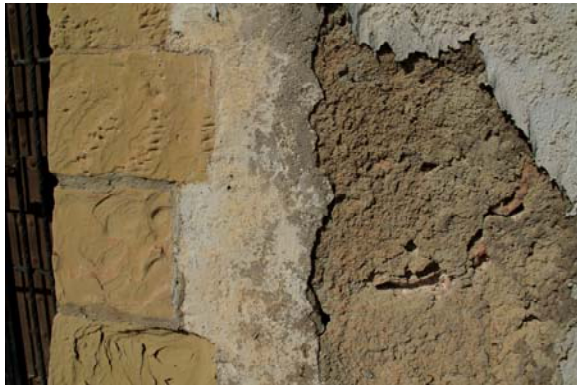
Figura 129. Torre del Cap Roig. Detalle muro (Fotografía de Mayor, 2013)
