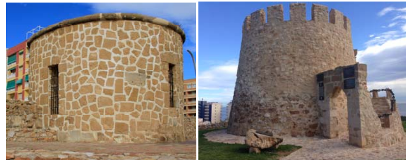
Figuras 223 y 224. Izquierda: Torre de la Mata, derecha: Torre del Cap Cerver (Fotografías de Mayor, 2013)
