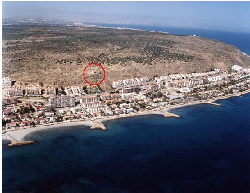
Figura 181. Torre Escaletes (Fotografía de la Dirección General de Costas, Ministerio de Medio Ambiente)
