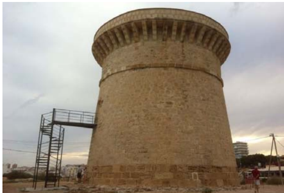
Figura 91. Torre de la Illeta después de su restauración (Fotografía de Mayor, 2013)
