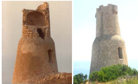
Figuras 31 y 32. Izquierda: Torre del Gerro antes de su restauración (Fotografía de Varela); derecha: estado actual (Fotografía de Mayor, 2013)
