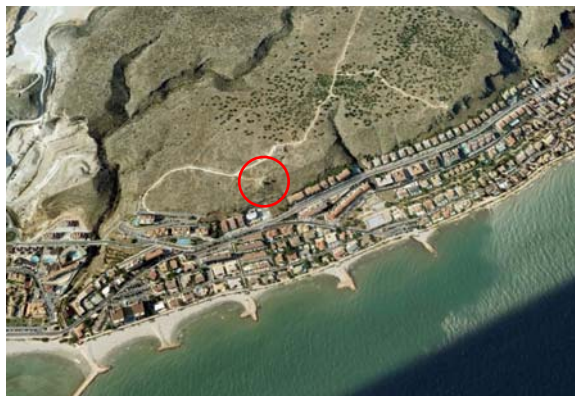
Figura 108. Emplazamiento Torre Escaletes (www.google.es-Consultado 10/12/2015)
