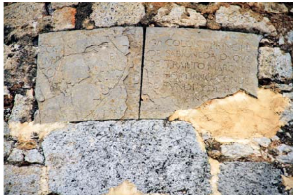
Figura 110. Torre Escaletes. Detalle de la inscripción (Fotografía de Mayor, 2013)
