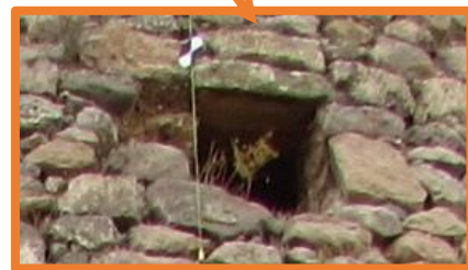
Imatge 31. Tronera al mur nord-oest.
