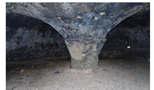
Imatge 29. Interior torre sud-est.
