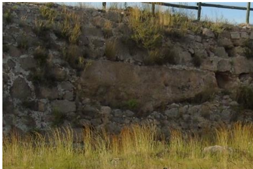
Imatge 41. Pedra al interior del mur sud.
