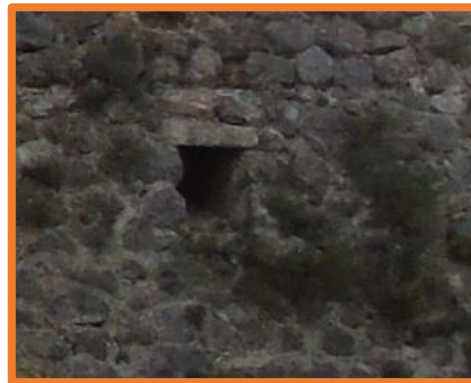
Imatge 31. Tronera al mur nord-oest.
