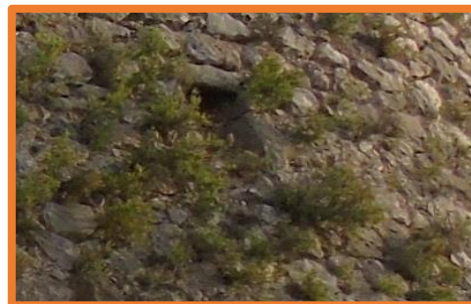
Imatge 33. Tronera al mur nord-oest.
