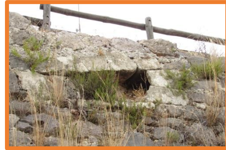
Imatge 34. Tronera al mur nord-oest.
