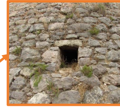
Imatge 38. Tronera al mur sud-est.
