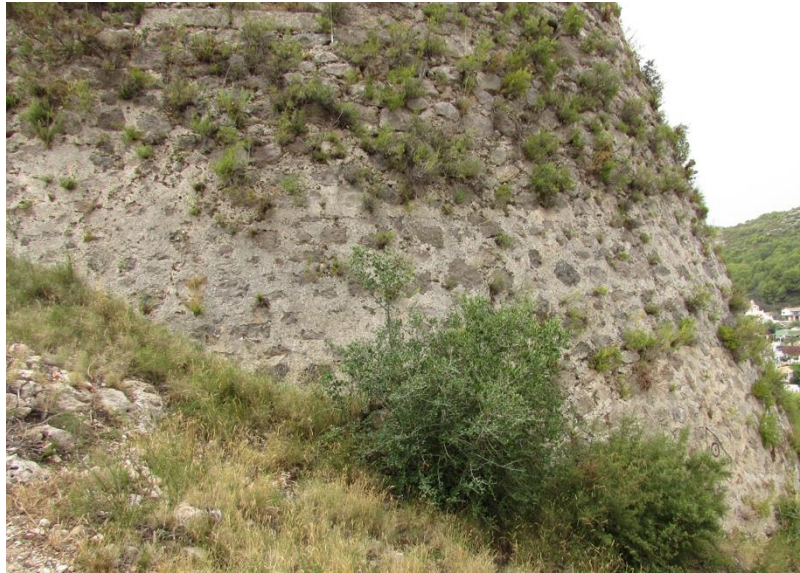
Imatge 45. Intervenció amb el material impropri
