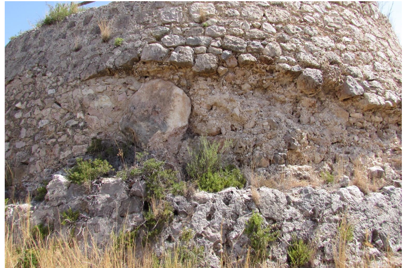
Imatge 42. Part de l'interior del mur a la torre sud-est.
