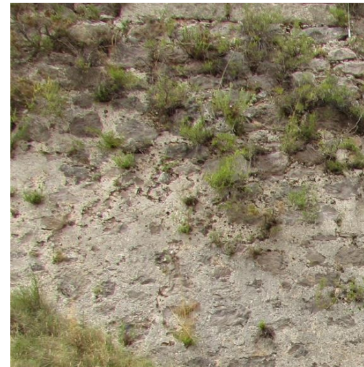
Imatge 49 . Intervenció amb material incorrecte.
