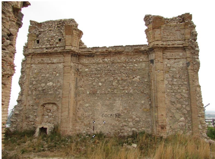
Imatge 43. Estructura de la façana est de l'Ermita de Santa Anna.
