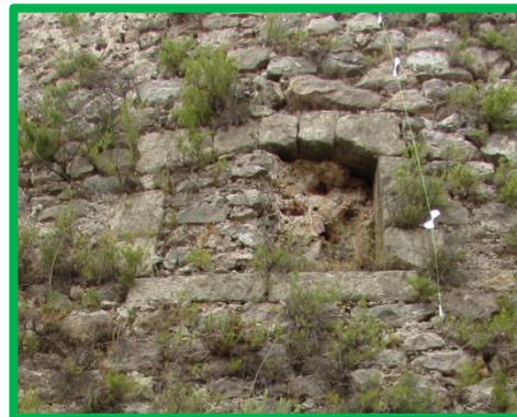
Imatge 32. Tronera al mur nord-oest.
