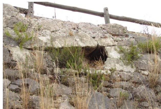
Imatge 26. Tronera situada al mur est.
