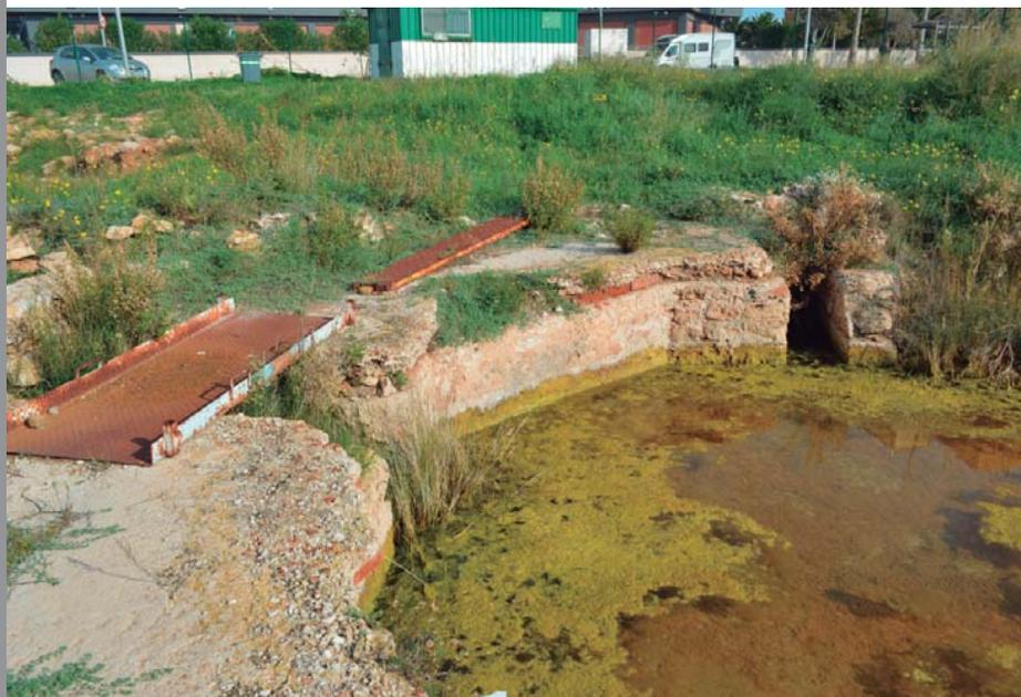
**Fig. 67** - Sala octogonal donde puede apreciarse el desnivel entre el hypocaustum y el nivel de pavimento, así como los canales de circulación de aire (diciembre 2015)
