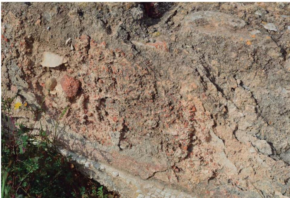
**Fig. 96** – Muestra de disgregación de materiales en paramento vertical por solubilización (febrero 2016)
