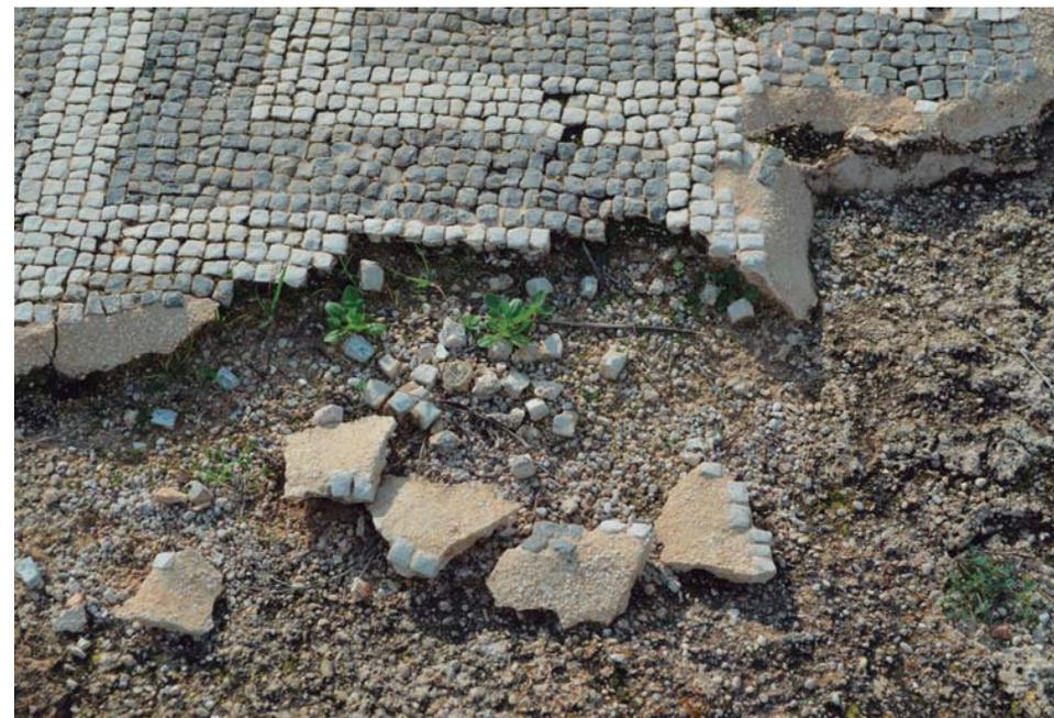
Fig. 95 – Rotura en el borde exterior de fragmento de mosaico (diciembre 2015)
