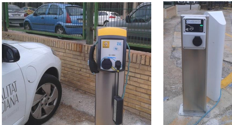
Ilustración 25. Cargador Renault Fluence (a la izquierda) y cargador del Renault ZOE (a la derecha). Fuente: MOVUS
