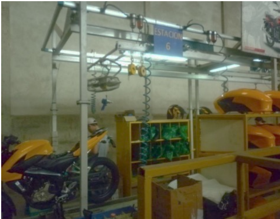
Figura 16. Instalación de cableado
