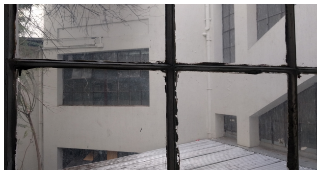
Figura 4.50 Vista hacia uno de los 4 patios interiores.
