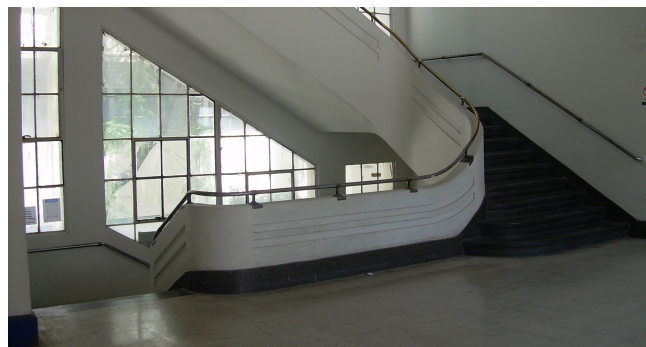
Figura 4.48 Una de las cuatro escaleras centrales.
