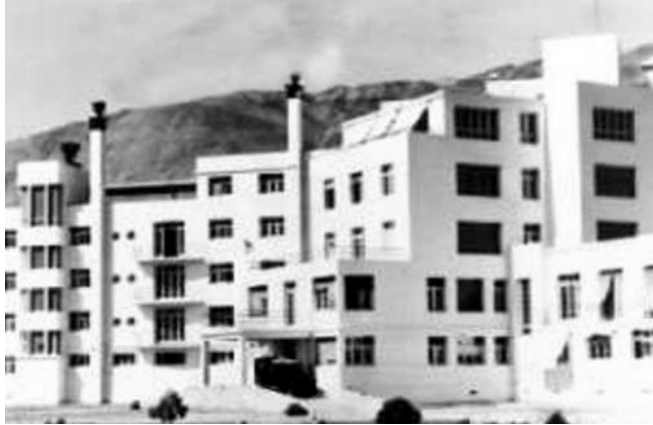
Figura 4.9 Hospital de Beneficencia, ubicado en la ciudad de Iquique, construido bajo la misma lógica del “monoblock”.
