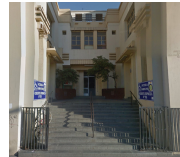
Figura 5.22 Acceso principal al edificio por Planta Baja.
