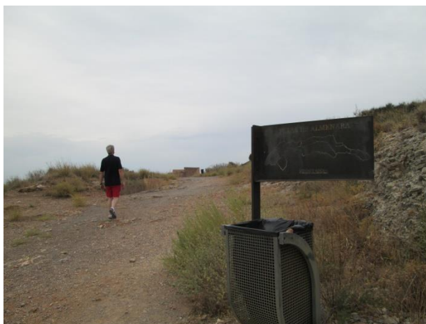
Imagen 19. Plaza de Almenara. Observamos el deterioro de la señalización.
