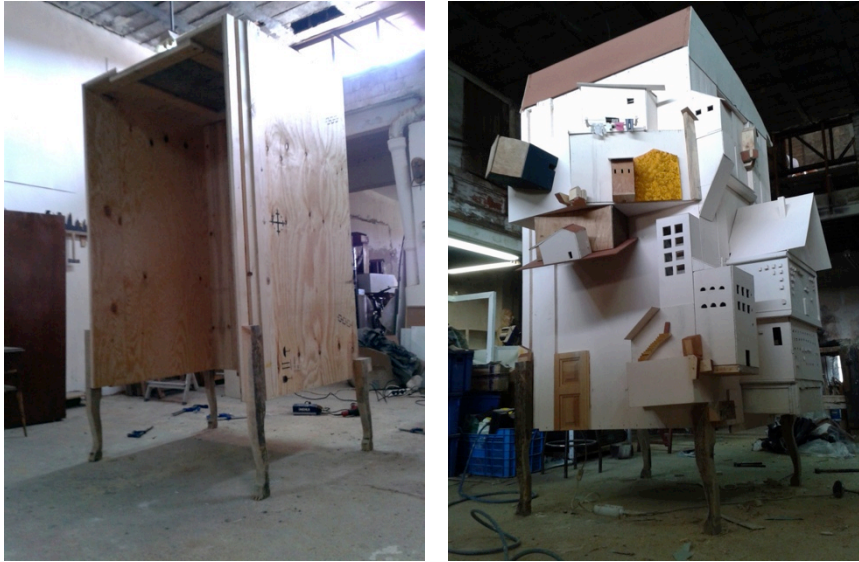
Figura 65 i 66. Procés de construcció al taller.
