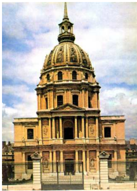
Figuras 166: Vista exterior
