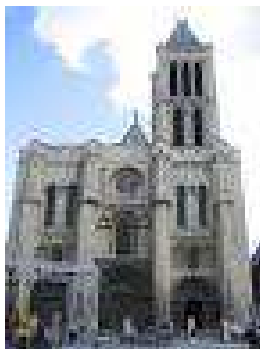
Figuras 107: Vista exterior
