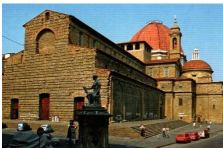
Figuras 141: Vista exterior
