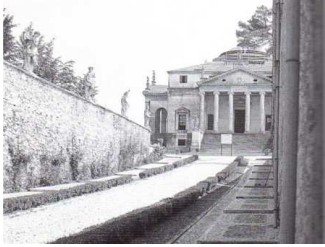
Figuras 159: Vista exterior
