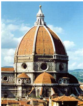
Figuras 136: Vista exterior
