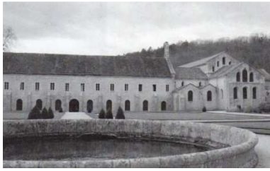
Figuras 116: Vista exterior
