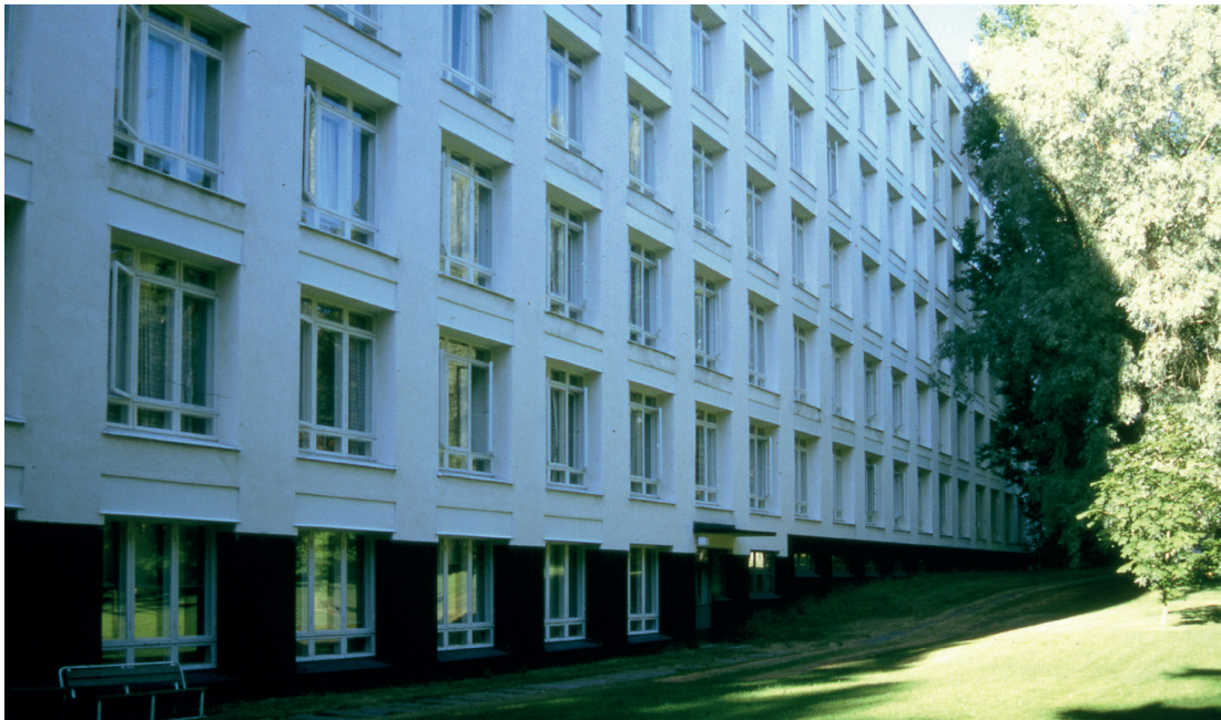
Figura 5. Alvar Aalto. Sanatorio de Paimio. Muro sur.
