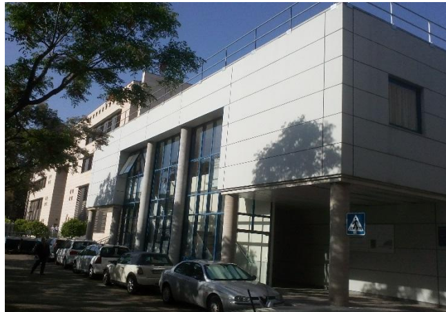
Fig. 2. Edificio de Laboratorios E.T.S.I.E. Fachada principal.
