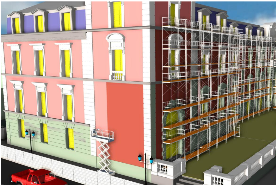
Fig. 1. Vista Noreste del modelo 3D del Salón de Reinos limpiándose el ladrillo (durante la rehabilitación). 2016. Fuente propia.
