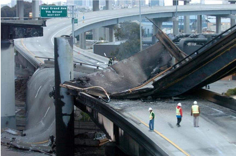
Figura 1. Colapso del Intercambiador MacArthur Maze en Oakland, CA, USA. Fuente: Noah Berger.
