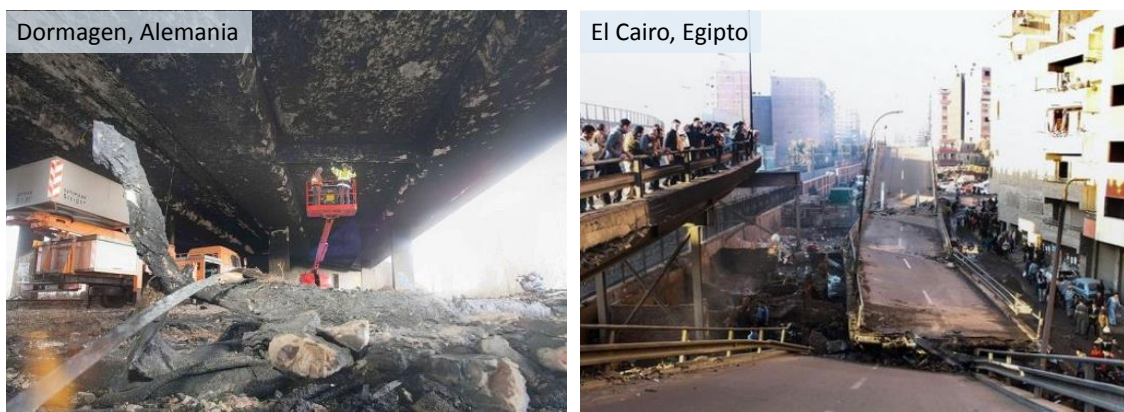
Figura 9. Izda. Daños ocasionados por el incendio de unas pilas de plástico bajo la estructura, Dormagen, Alemania. Fuente: thelocal.de. Dcha. Colapso de un puente en El Cairo debido al incendio de una tubería de gas. Fuente: ndjblogalnews.
