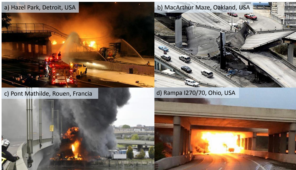
Figura 3. Imágenes de incendios recientes en puentes. a) Hazel Park, Detroit, Usa. Fuente: Ap Phile Photo / Carlos Osorio. b) MacArthur Maze, Oakland, USA. Fuente: Associated Press. c) Pont Mathilde, Ruan, Francia. Fuente: Dvelec. d) Rampa I270/70, Ohio, USA. Fuente: 10tv.com
