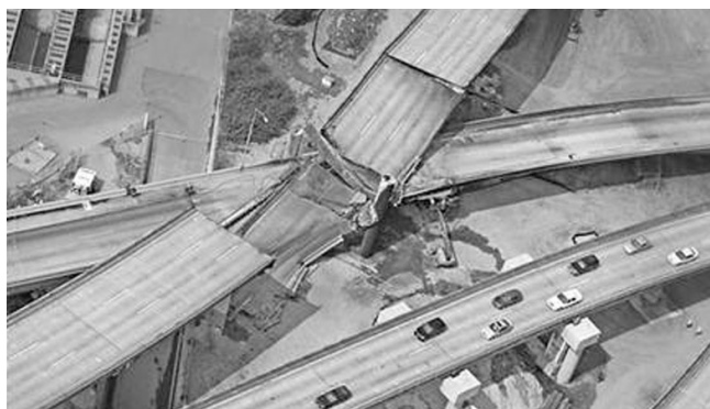
Figura 1. Imagen aérea del estado en que quedó el Intercambiador Mc Arthur en Oakland tras el incendio sufrido el 29 de abril del año 2007. Fotografía de Robert Campbell usada con su permiso.
