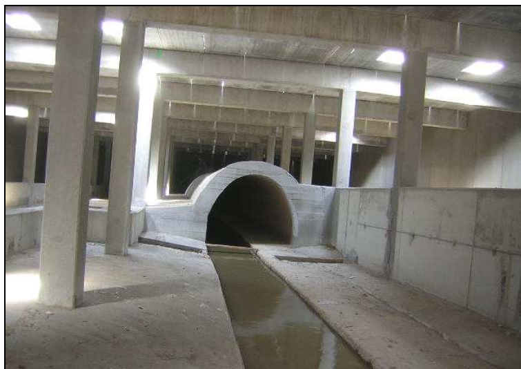
Figura II.9. Tanque de tormenta en Burjassot, Valencia.
