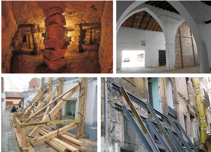
Figura 1. Materiales utilizados en distintos tipos de apuntalamientos
