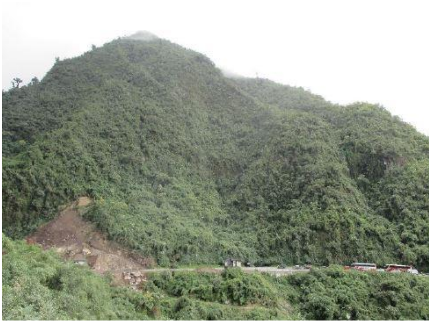
Fotografía 8. Deslizamiento rotacional en el emboquille de entrada.
