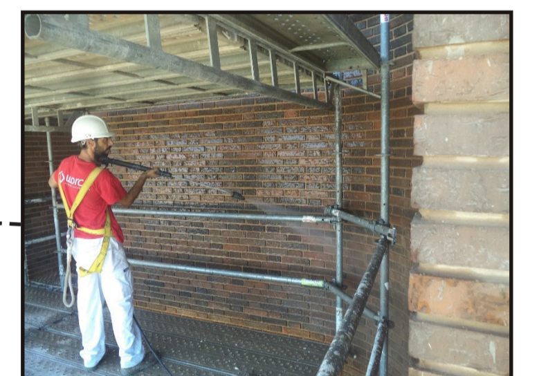
Prueba de hidrofugado en fachada
