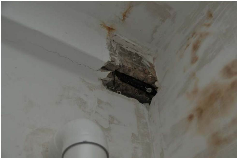
Imagen 7 Estado actual viga a reforzar
