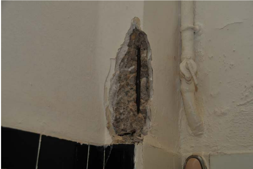
Imagen 8 Estado actual pilar a reforzar
