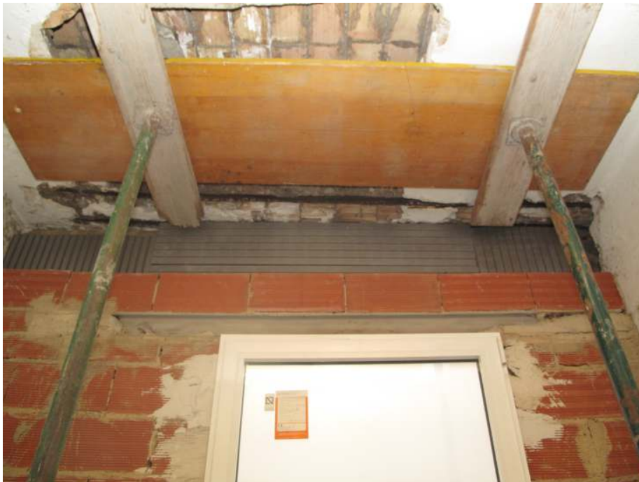
Imagen 6 Estas viguetas destapan el estado de la estructura
