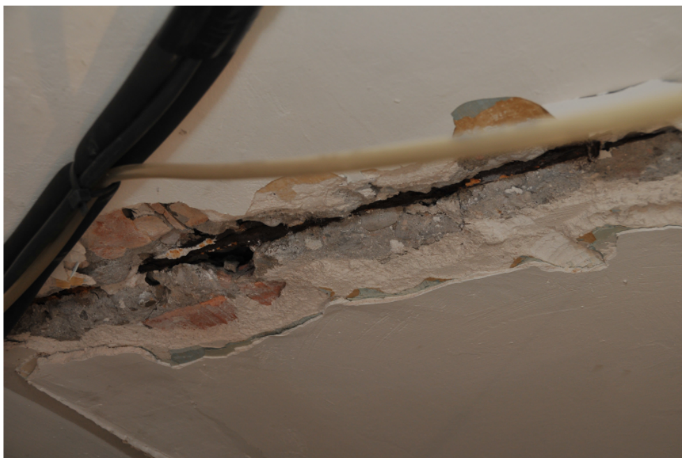
Imagen 1 Vigueta a reforzar
