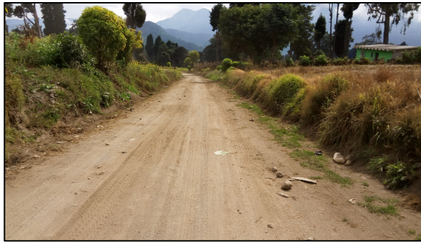
Imagen 6.5: Carretera de terracería. Fuente: Archivo propio.
