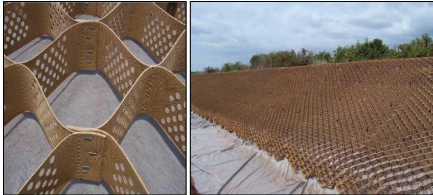
Figura 18. Detalle geocelda y colocación de la misma.
