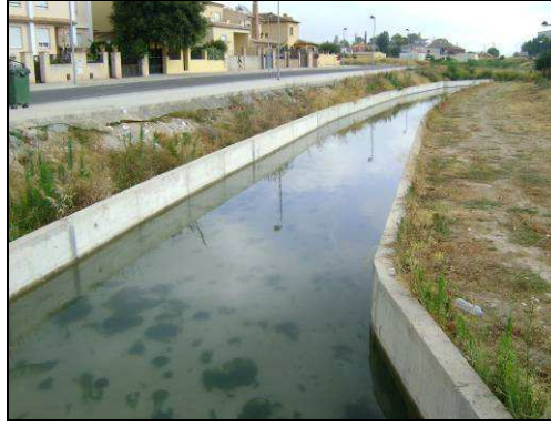
Figura 15. Desvío del cauce del Riu Sants a su paso por Canals.
