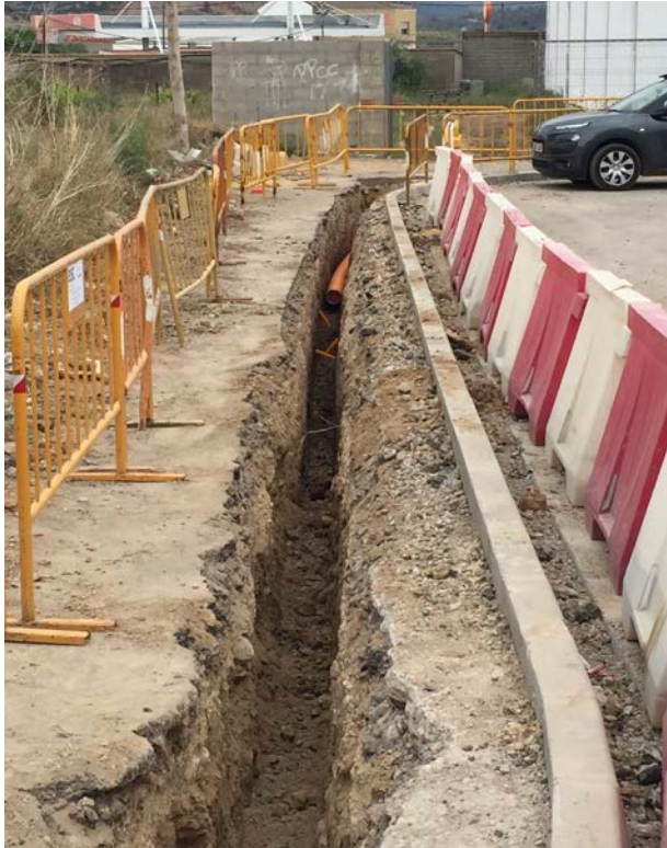
CANALIZACIÓN GAS NATURAL CANALIZADO PREVIA VISITA CON LA SUMINISTRADORA
